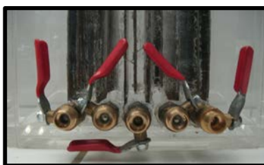
Figura 36: Sistema de válvulas usadas para desfogue de lodos. UNI – FIQT Laboratorio de fisicoquímica N° 11
