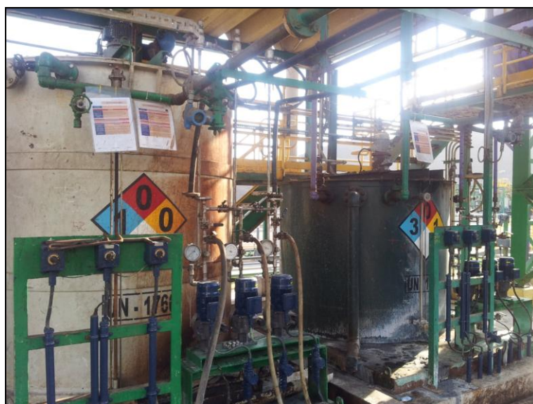
Figura 2. 26. Drums de almacenamiento del deshidratante y floculante
