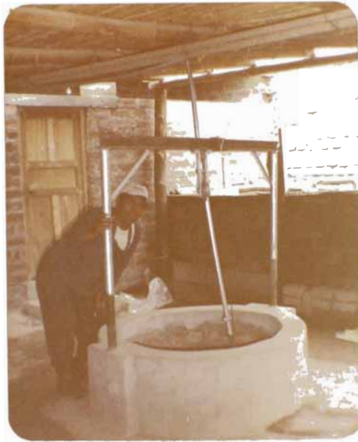
PEQUEÑO DOZO PARTICULAR PARA USO DOMESTICO EN EL INTERIOR DE UNA VIVIENDA DE LA AV. BENAVIDES.
