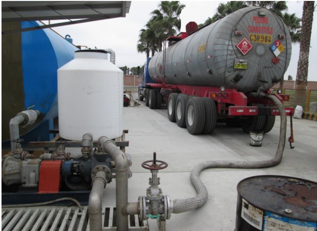
Figura 1.2. Despacho de emulsión asfáltica.
