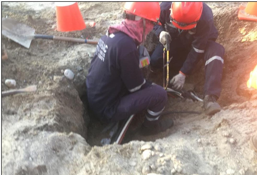
Figura N°22: Interferencias encontradas durante la excavación.
