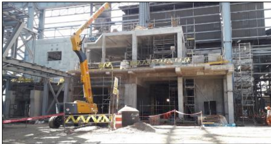
Figura N°73: Edificio eléctrico LF. Fecha: 05/11/2019.
