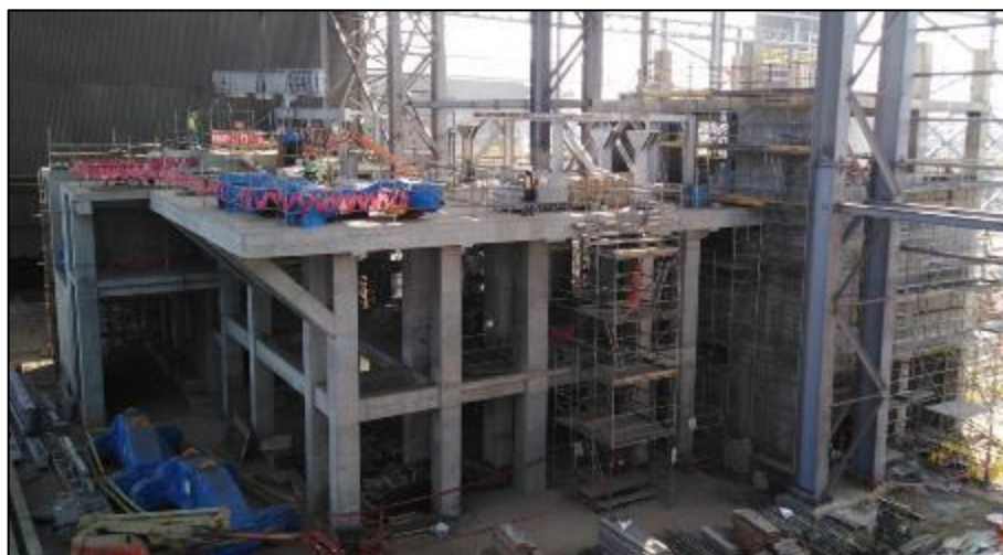
Figura N°77: Torre de cucharas del CCM, edificio del CCM y edificio eléctrico del CCM. Fecha: 05/12/2019.
