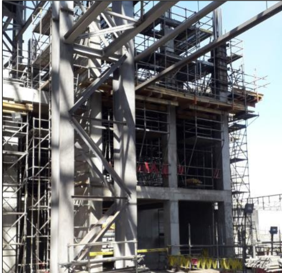
Figura N°81: Edificio eléctrico del CCM. Fecha: 05/11/2019. Fuente: Elaboración propia.
