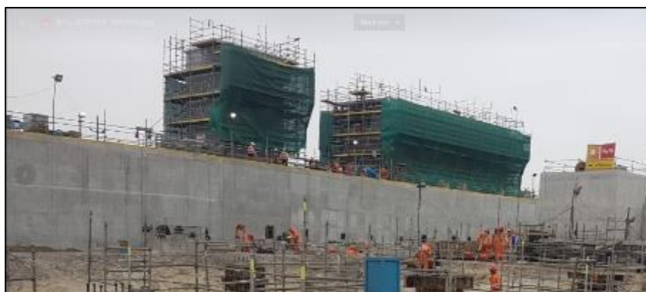
Figura N°96: Torre de refrigeración del WTP. Fecha: 07/10/2019.
