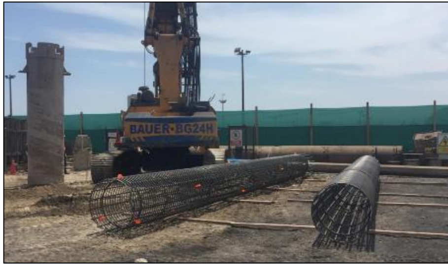
Figura N°66: Pilotera BAUER BG24H y armaduras de pilotes. Fecha: 02/10/2018
