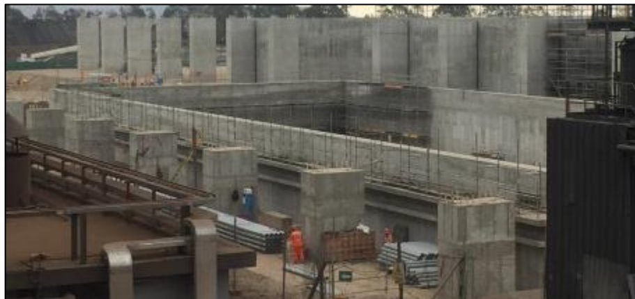
Figura N°86: Parque de chatarras / scrap yard. Fecha: 04/04/2019.
