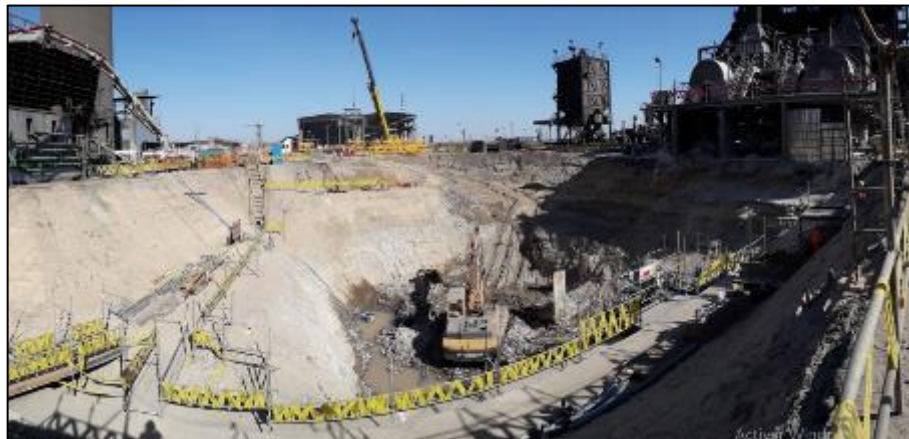
Figura N°82: Excavación del Scale Pit. Fecha: 14/05/2019. Fuente: Elaboración propia.
