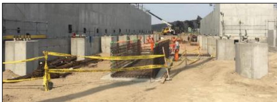
Figura N°98: Edificio de bombas del WTP. Fecha: 23/09/2019.
