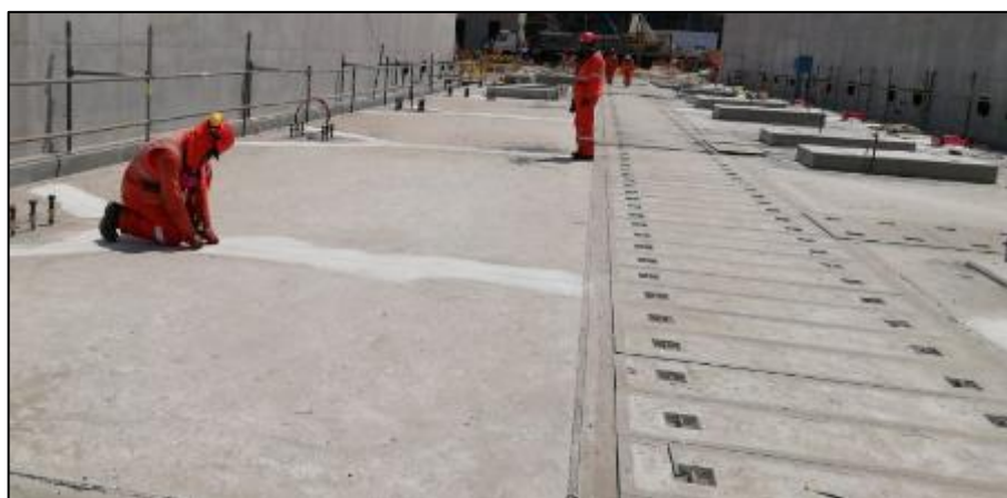
Figura N°99: Edificio de bombas del WTP. Fecha: 08/11/2019.
