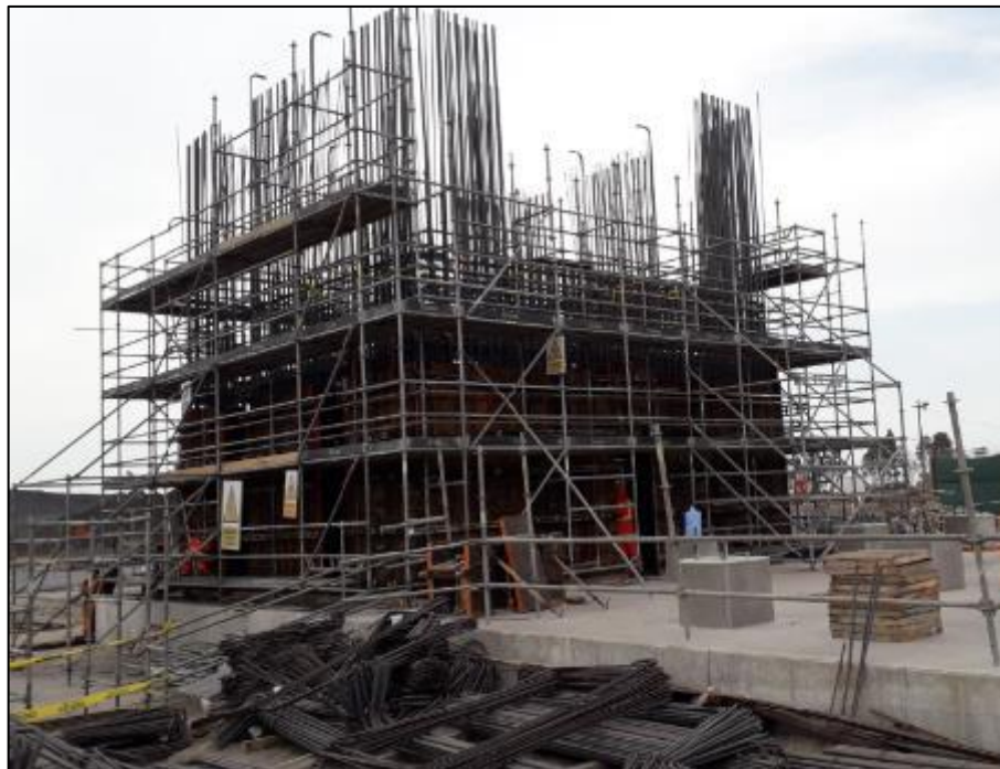
Figura N°39: Fotografía del 18/01/19 de la chimenea. Fuente: Elaboración propia.
