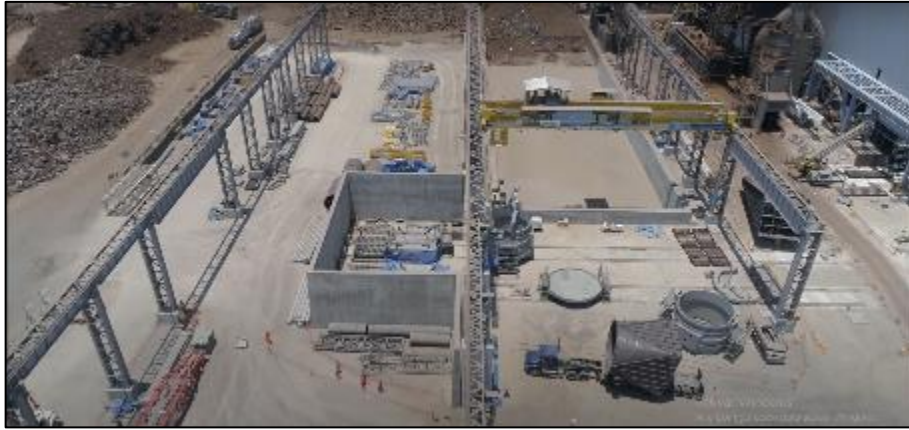
Figura N°87: Parque de chatarras / scrap yard. Fecha: 14/02/2020.
