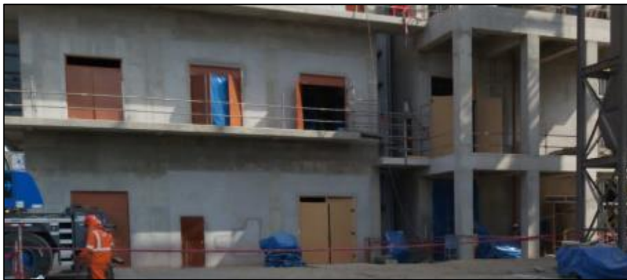
Figura N°71: Edificio eléctrico EAF. Fecha: 05/03/2020.
