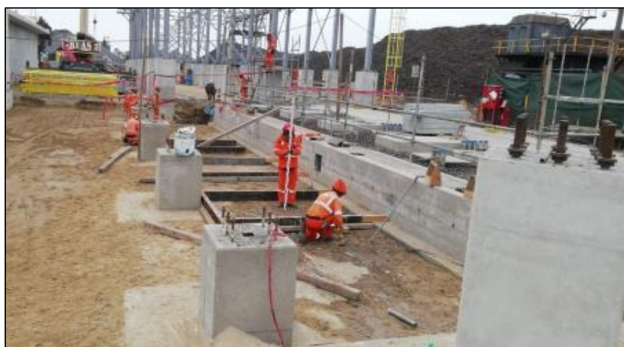
Figura N°102: Edificio de bombas booster del WTP. Fecha: 13/11/2019.
