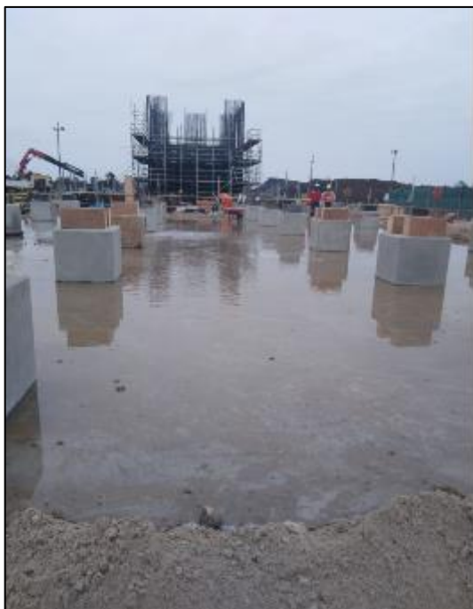
Figura N°38: Fotografía del 18/01/19 de la losa del filtro de cartuchos. Fuente: Elaboración propia.
