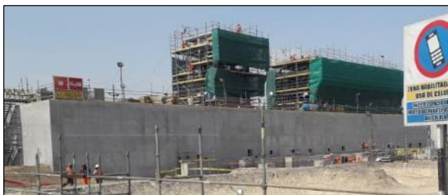
Figura N°95: Torre de refrigeración del WTP. Fecha: 23/09/2019.
