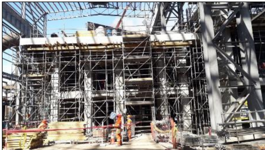
Figura N°80: Edificio CCM. Fecha: 05/11/2019.
