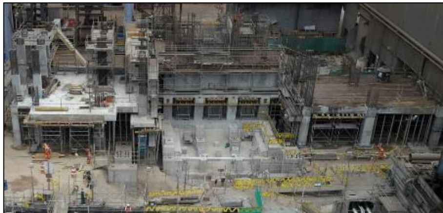
Figura N°76: Torre de cucharas del CCM y edificio del CCM. Fecha: 18/07/2019.
