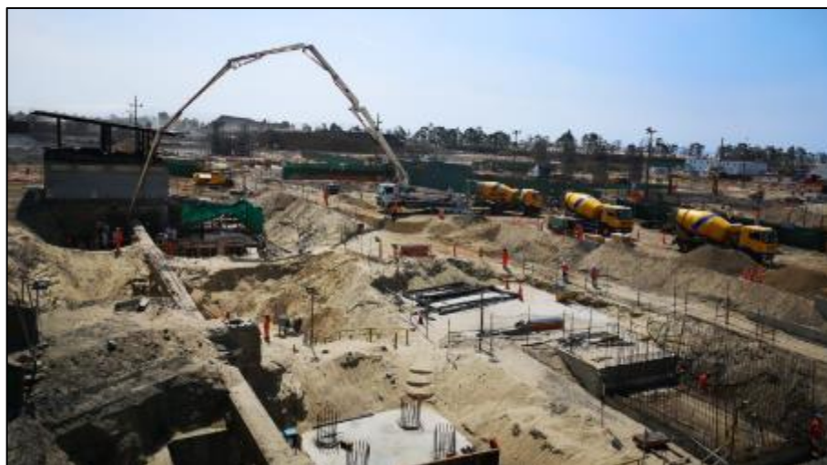
Figura N°68: Vaciado de zapata del edificio de acería. Fecha: 09/01/2019.
