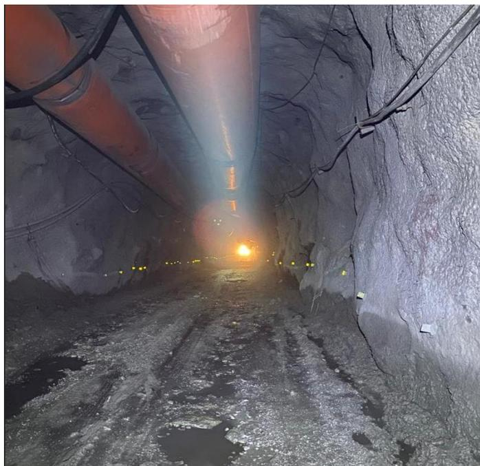
*Figura 5.4* Sistema de Ventilación con 02 mangas de 32" de diámetro en paralelo RP (-)
