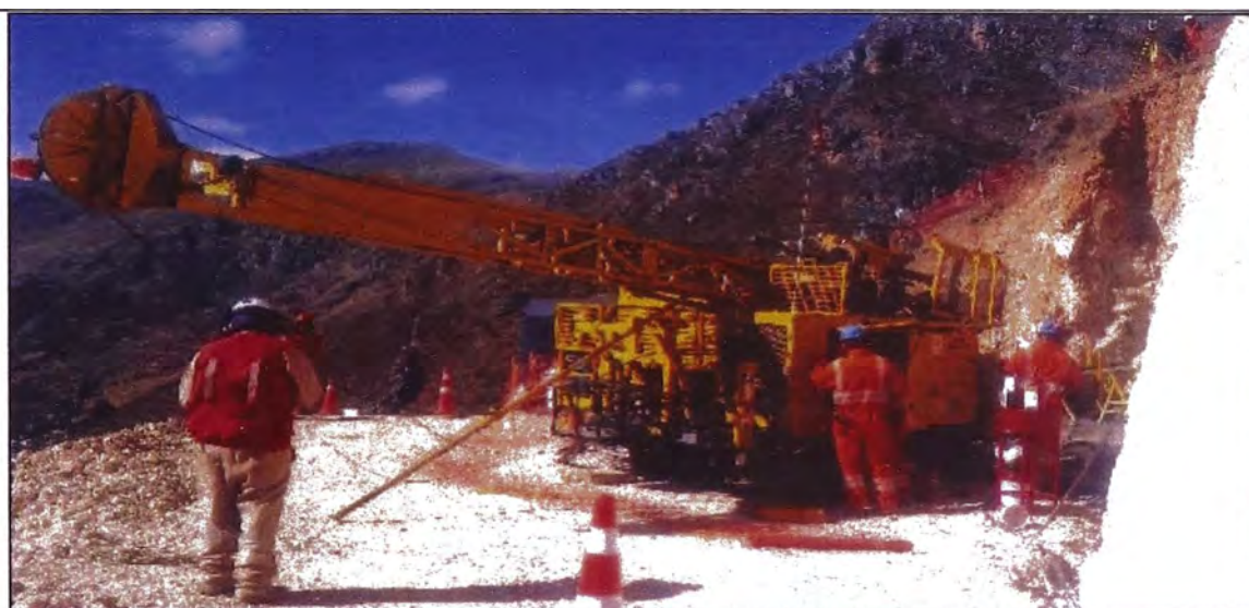
FIGURA 3.22 SUPERVISIÓN EN PLATAFORMA TANTO EN LA CORRECTA MANIPULACIÓN DE LAS MUESTRAS Y MANIOBRAS DE MAQUINARIA
