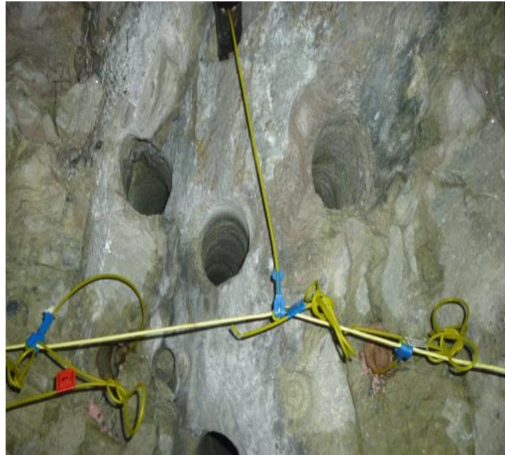
Figura 2,10 Corte con 4 taladros vacíos Fuente: Mina-estudio
