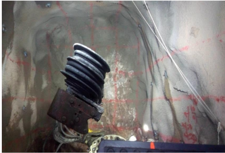
Figura 2,18 Perforación de frontón Fuente: Mina-estudio
