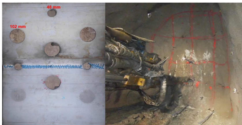
Figura 4,6 Diseño de corte Veta Nancy Fuente: Mina-estudio
