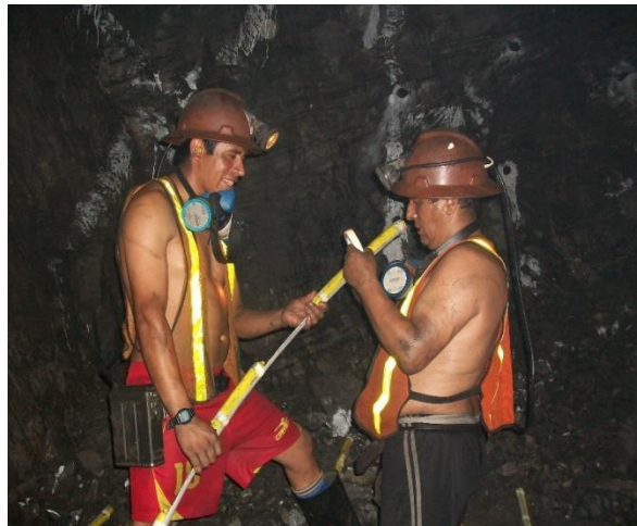
Figura 2,33 Pre-corte con MEC espaciada Fuente: Mina-estudio
