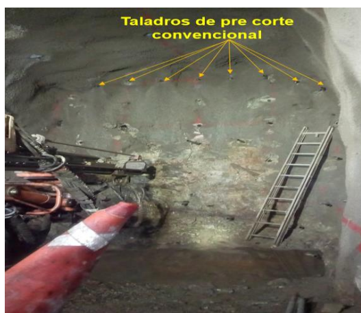
Figura 2,28 Perforacion de los taladros Fuente: Mina-estudio
