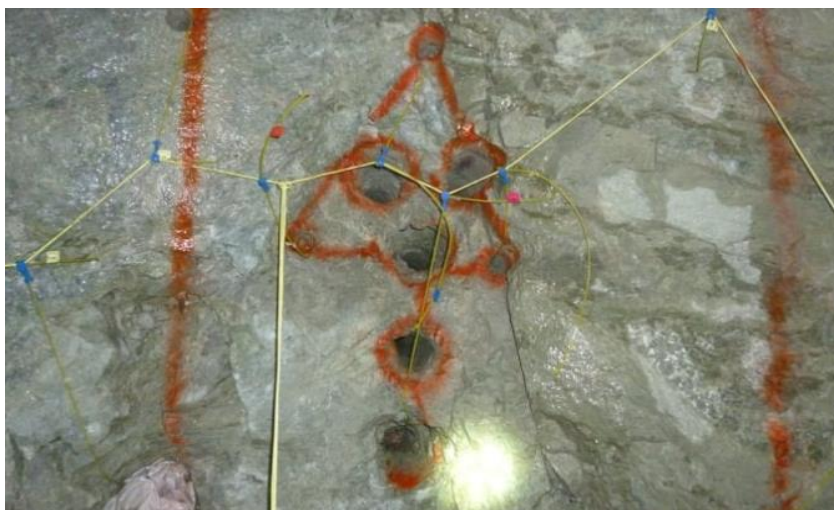
Figura 2,11 Corte con taladros paralelos Fuente: Mina-estudio
