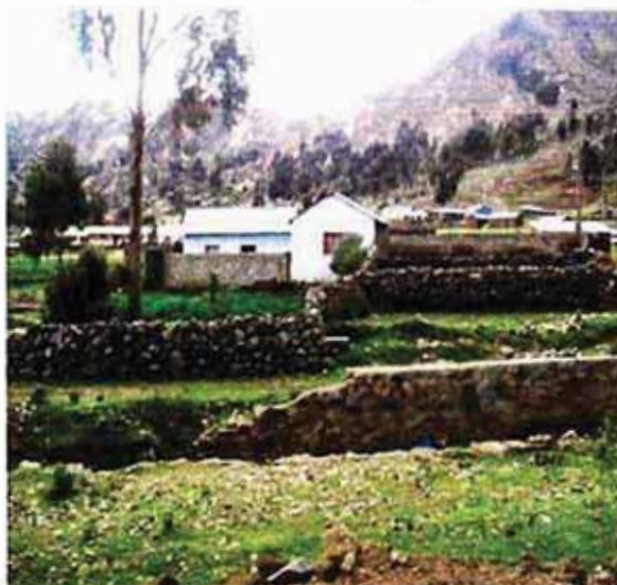
Foto 4.12 Vivienda de adobe de un piso en el sector Jayllihuaya Fuente: Del autor
