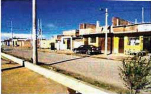
Vivienda típica regular: Casa de 1 piso de albañilería confinada sin acabados.
