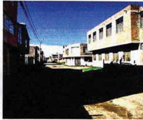
Vivienda típica Buena: Casa de albañilería confinada de 2 pisos
