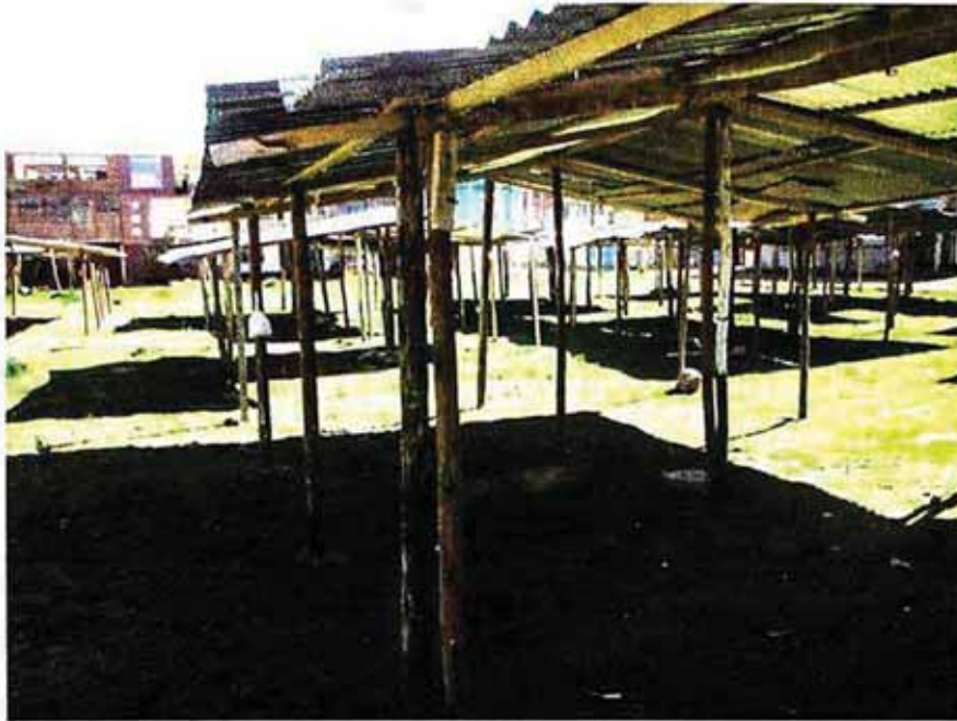
Foto 4.8 Infraestructura actual del mercado de abastos en el sector Salcedo. Fuente: Del Autor
