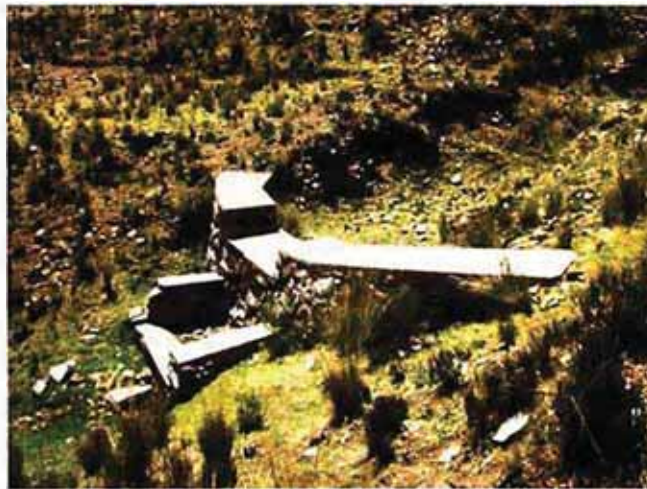
Foto 4.4 Diques para evitar cárcavas en la zona de estudio Fuente: del autor
