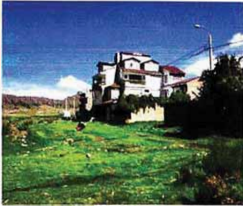
Vivienda Muy buena: Casa de albañilería confinada de 3 a más pisos con recubrimiento.
