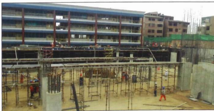
Figura N° 4.2.- Encofrado de Viga Postensada – Ampliación Colegio Champagnat
