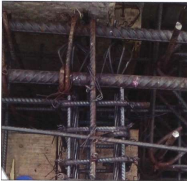
Figura N° 2.19.- Anclaje tipo H
