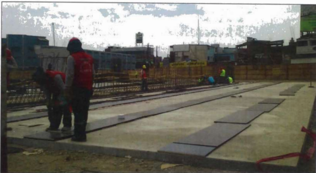
Figura N° 4.18.- Colocación del Fondo de Encofrado en Viga Postensada Fuente: Samayca Ingenieros SAC – Obra Intercambio Vial Óvalo Grau
