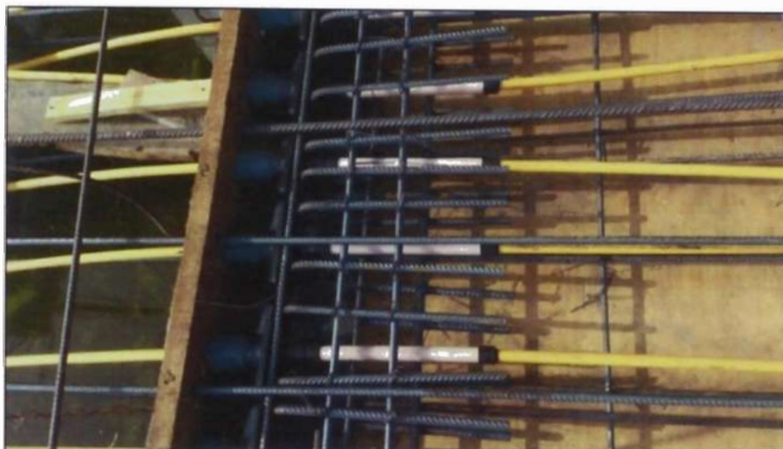
Figura N° 4.32.- Colocación de Anclajes
