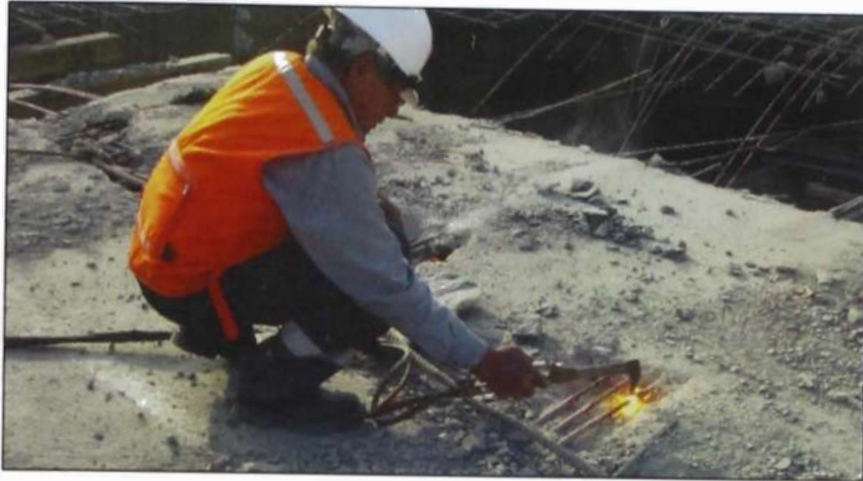
Figura N° 4.40.- Corte de Cables Postensados con Oxicorte
