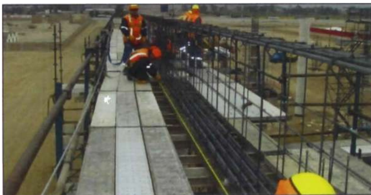
Figura N° 4.5.- Trazado de Cables en Viga Postensada
