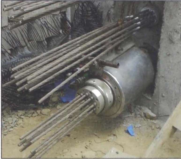
Figura N° 2.23.- Gato Tensa 2600 (9 a 12 cables) Fuente: Samayca Ingenieros SAC – Obra Puente Sucre
