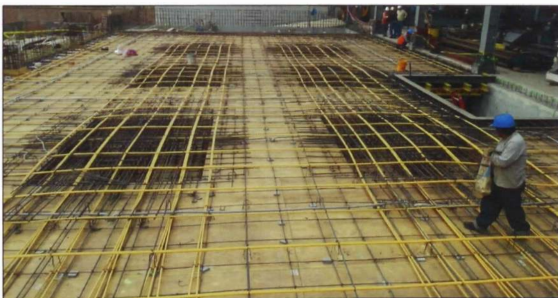
Figura N° 2.5.- Tendido de cables en Losas Postensada Fuente: Samayca Ingenieros SAC – Obra Almacén CGZ
