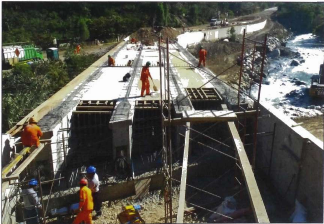
Figura N° 2.7.- Tensado de Vigas Fuente: Samayca Ingenieros SAC – Obra Puente Mataka, Huaral Acos
