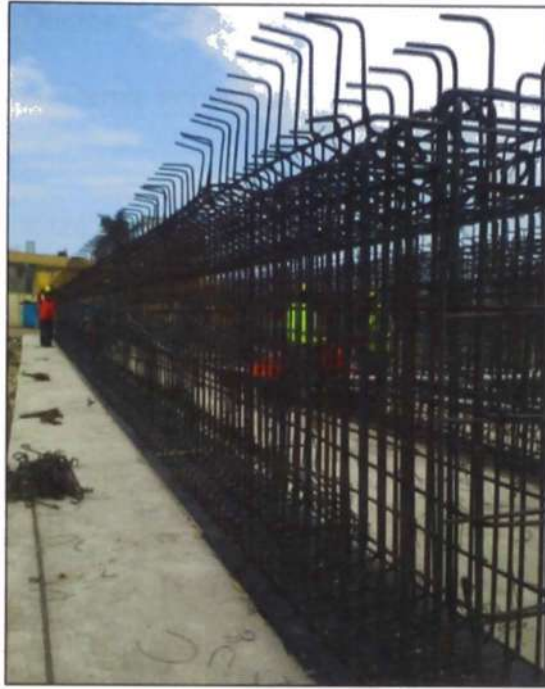
Figura N° 4.19.- Colocación de Acero de Refuerzo
