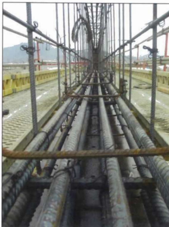
Figura N° 4.3.- Colocación de acero longitudinal y estribos
