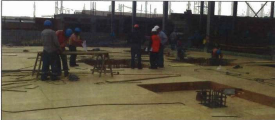
Figura N° 4.28.- Encofrado de Losa Postensada
