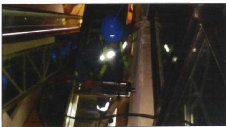
Figura N° 4.51.- Tensado de cables de pretensar reparados
