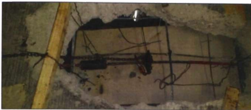
Figura N° 4.50.- Colocación del empalme entre los cables postensados.
