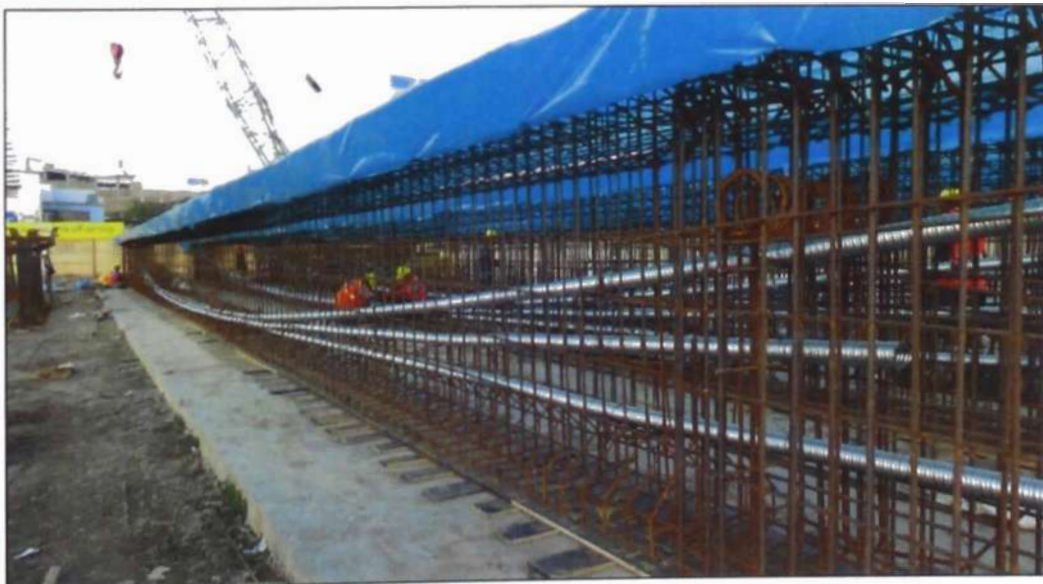
Figura N° 4.21.- Colocación de Ductos
