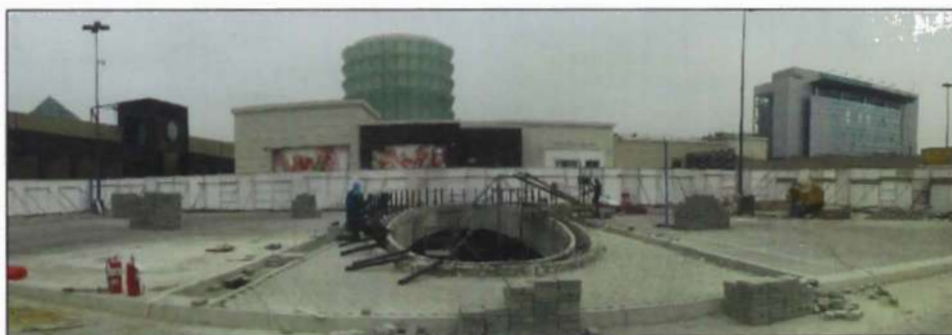
Figura N° 4.45.- Vista Panorámica del Ducto Elíptico
