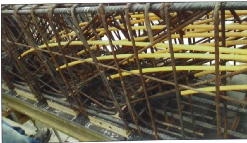
Figura N° 4.10.- Colocación de Anclajes en la parte inferior de la Viga Postensada
