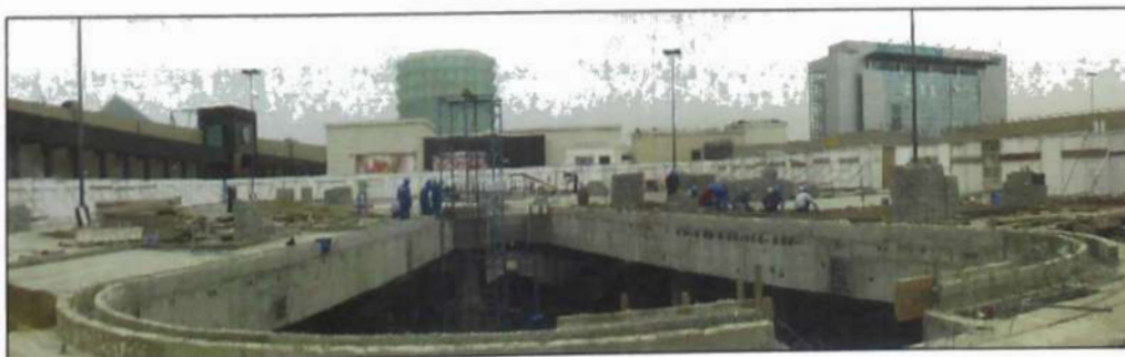
Figura N° 4.46.- Vista Panorámica del Ducto Trapezoidal
