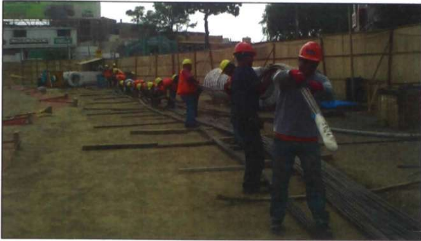
Figura N° 4.22.- Colocación de Cables
