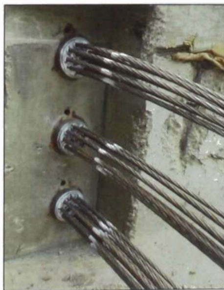
Figura N° 2.20.- Anclajes Multitorón
