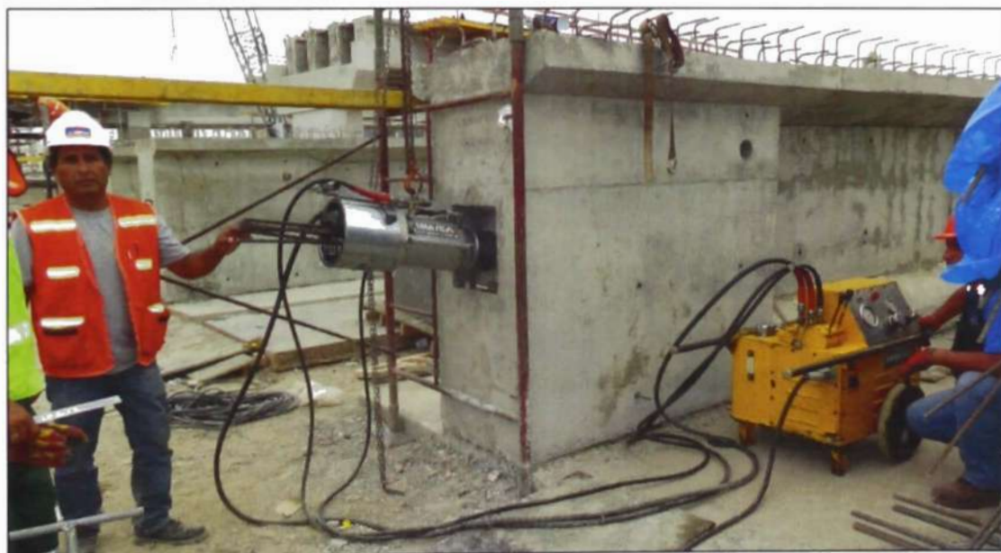
Figura N° 4.24.- Tensado de Vigas
