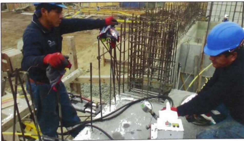
Figura N° 4.34.- Tensado de Losa Postensada
