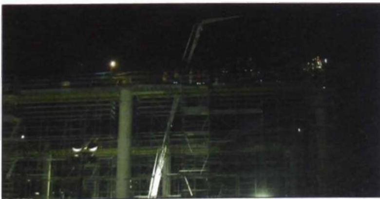
Figura N° 4.12.- Vaciado de Concreto en Viga Postensada Fuente: Samayca Ingenieros SAC – Obra Planta Lindley Pucusana
