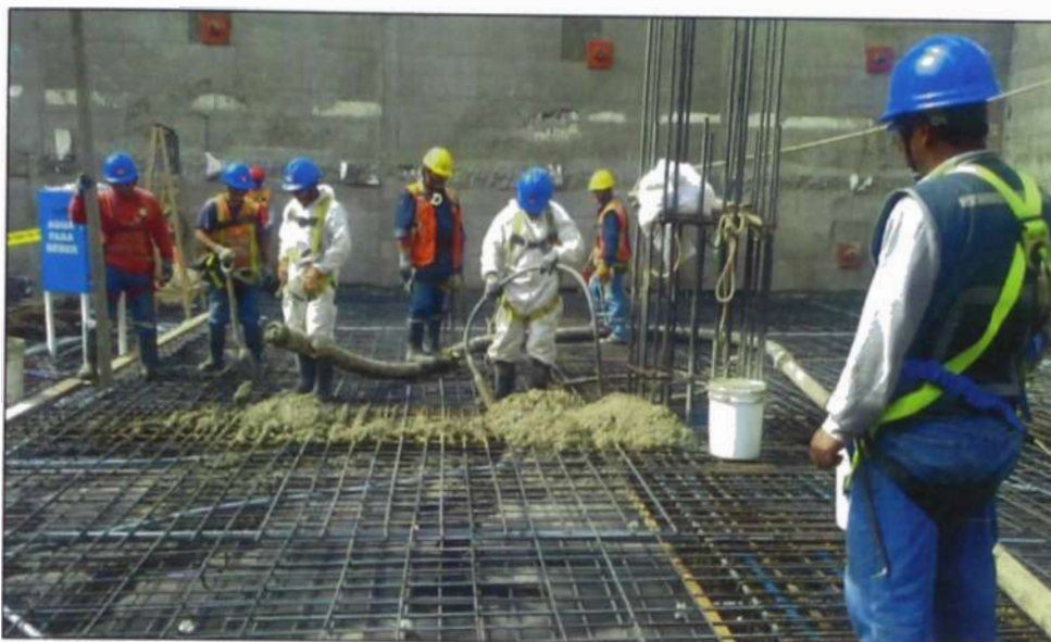
Figura N° 4.13.- Vaciado de Concreto en Viga Postensada
