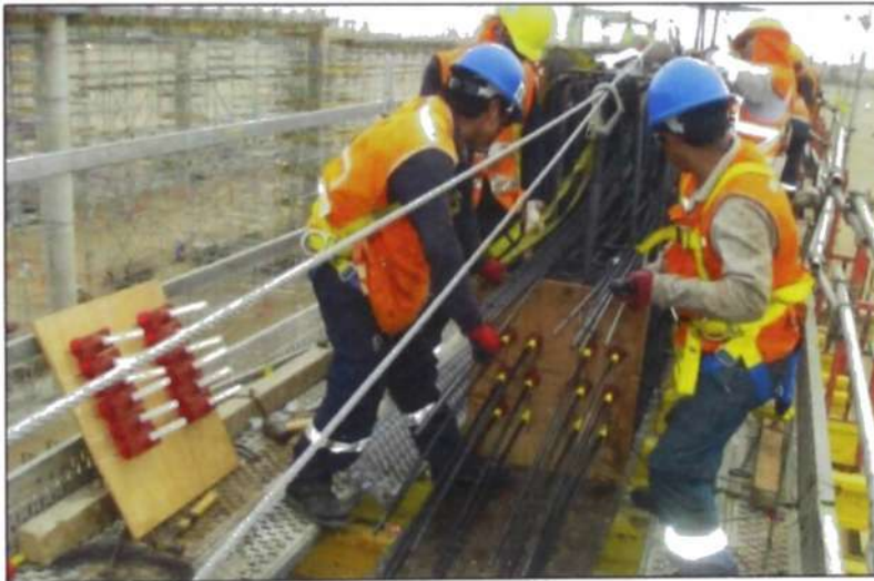
Figura N° 4.9.- Colocación de Anclajes
