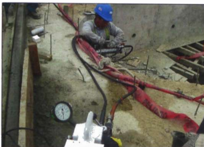
Figura N° 4.44.- Tensado de la Losa Postensada y Viga Postensada
