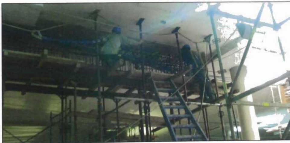
Figura N° 4.39.- Reforzamiento de Losa Postensada con Vigas Postensadas
