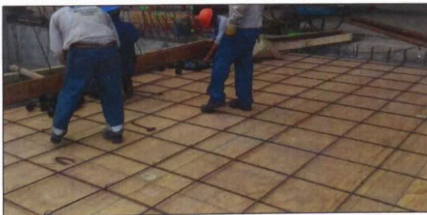
Figura N° 4.29.- Colocación de malla inferior de la Losa Postensada
