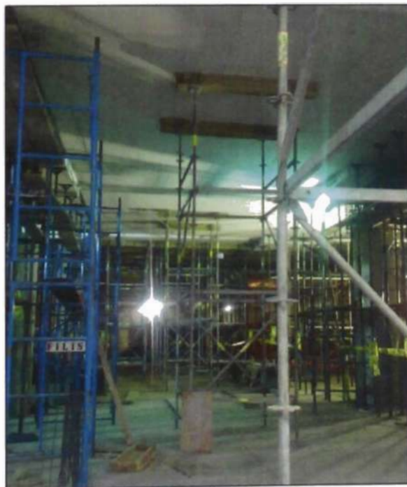
Figura N° 4.38.- Apuntalamiento de la Losa Postensada
