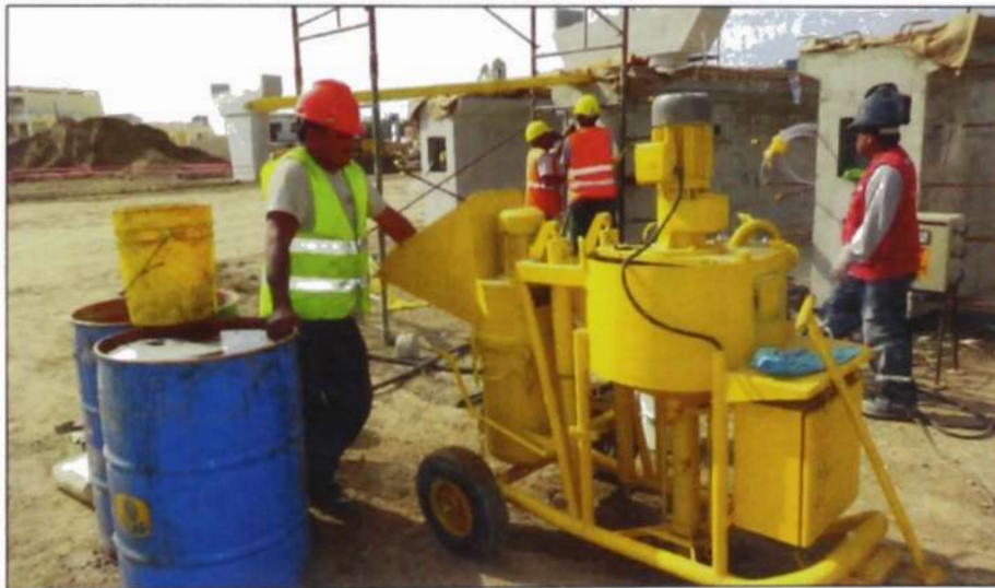
Figura N° 4.25.- Inyección de Vigas
