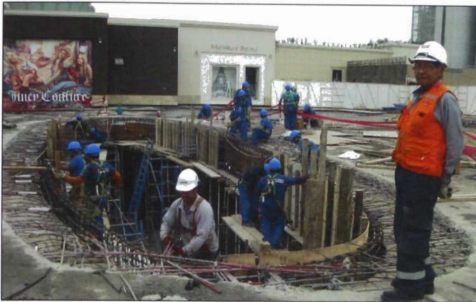
Figura N° 4.42.- Colocación de anclajes móviles en la Losa Postensada (Ducto Elíptico) Fuente: Samayca Ingenieros SAC – Obra Reforzamiento Estacionamiento Jockey Plaza
