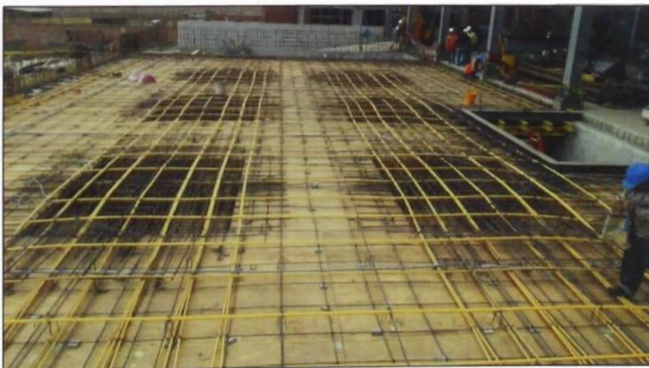
Figura N° 4.31.- Colocación de Cables Tipo Distribuido
