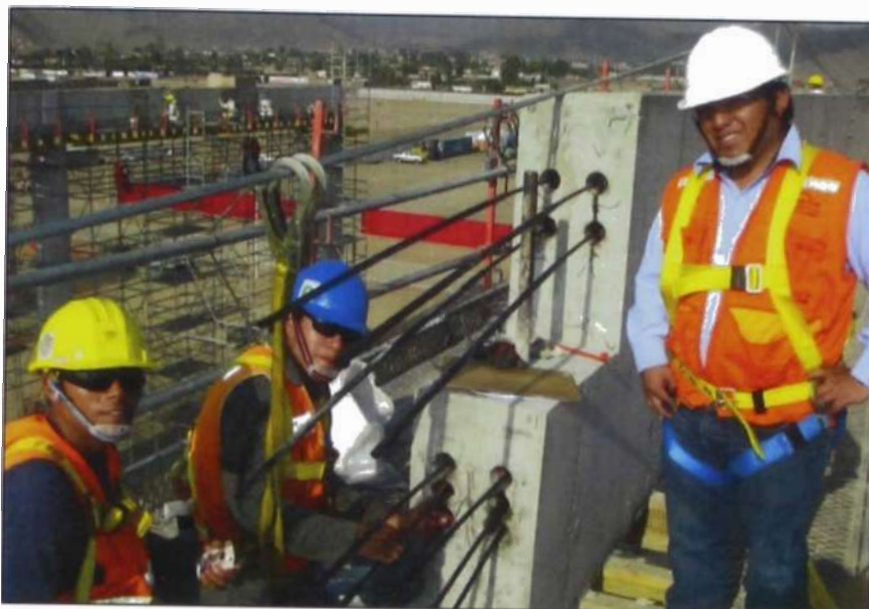
Figura N° 4.14.- Tensado de Tendones
