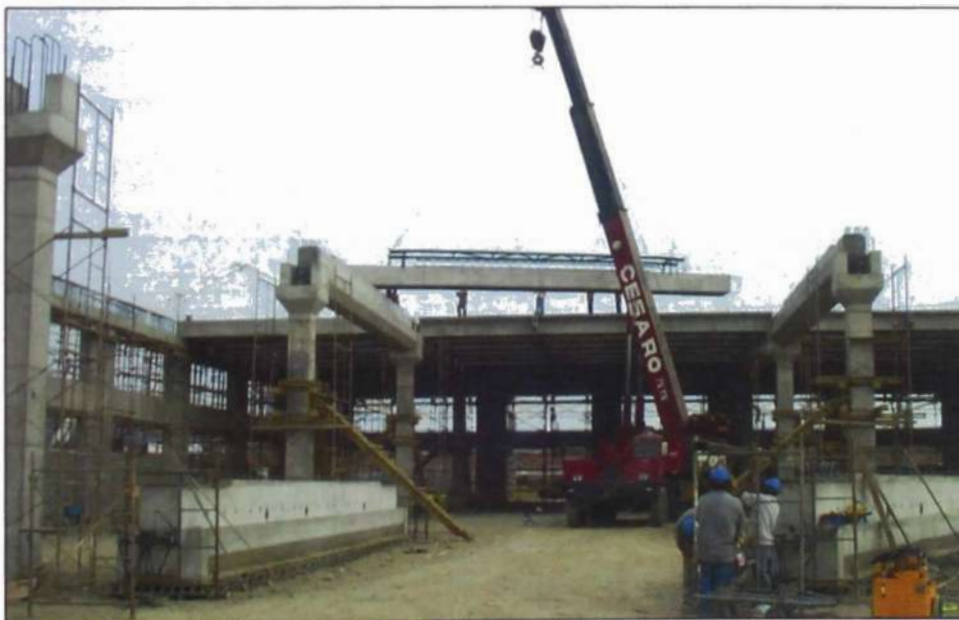
Figura N° 1.7.- Montajes de vigas prefabricadas
