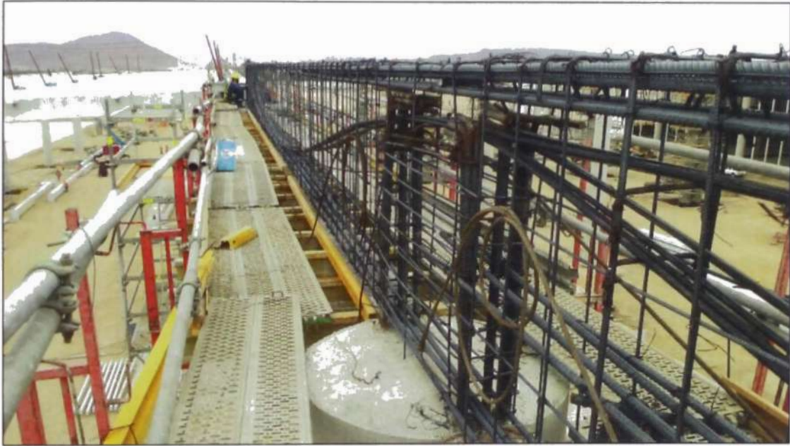
Figura N° 4.7.- Instalación de Tendones en Viga Postensada Fuente: Samayca Ingenieros SAC – Obra Planta Lindley Pucusana
