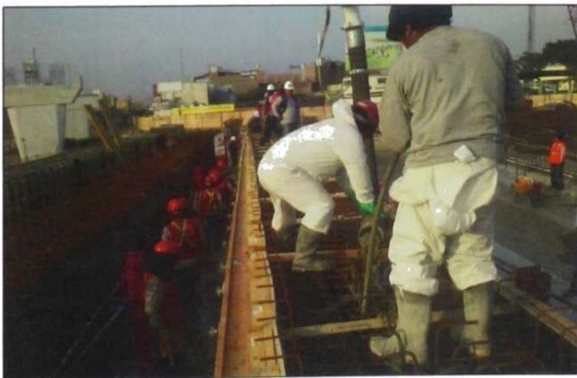
Figura N° 4.23.- Vaciado de Vigas
