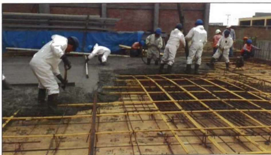
Figura N° 4.33.- Vaciado de Losa Postensada
