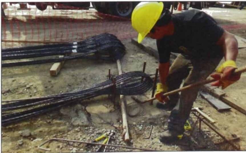
Figura N° 4.20.- Preparación de Anclajes Fijos
