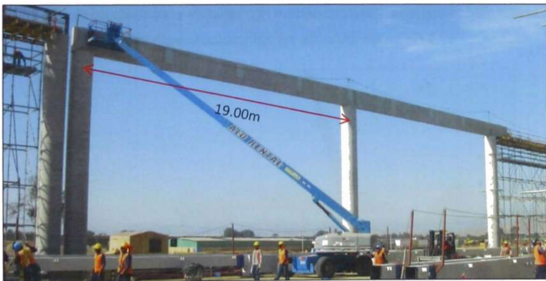
Figura N° 1.5.- Vigas postensadas
