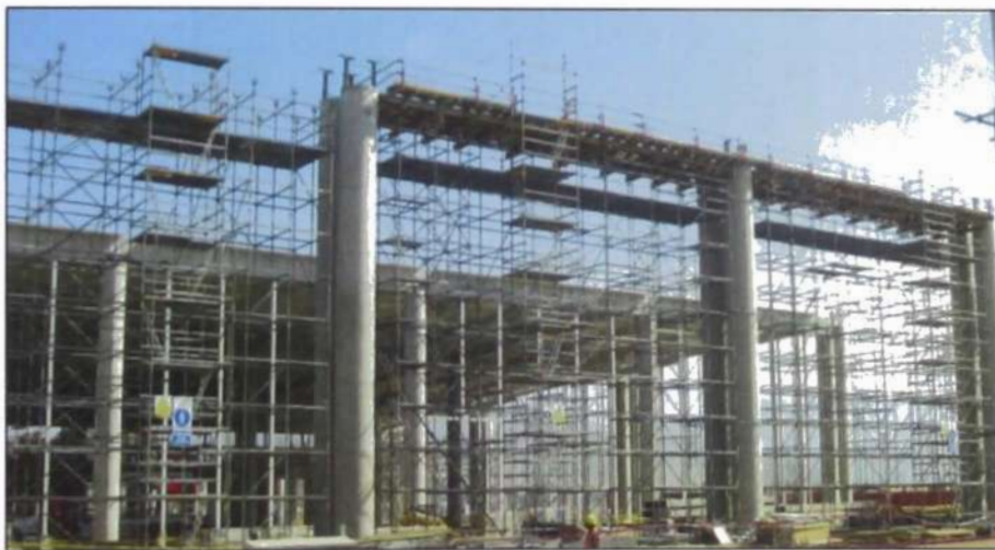
Figura N° 4.1.- Encofrado de Viga Postensada
