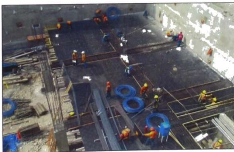
Figura N° 4.6.- Trazado de Cables en viga Postensada
