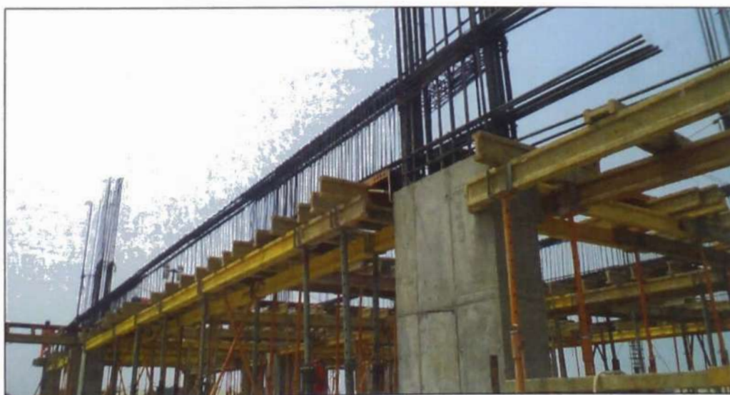
Figura N° 4.4.- Colocación de acero longitudinal y estribos
