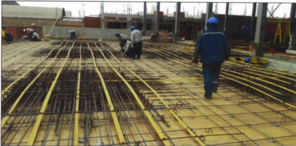
Figura N° 4.30.- Colocación de Cables en Viga Tipo Banda
