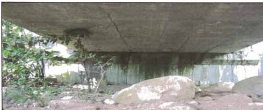
Figura N°1.2.- Vista del estribo del Puente Nochoz en la que se aprecia su buen estado, sólo se nota a la vista presencia de moho por la humedad.
