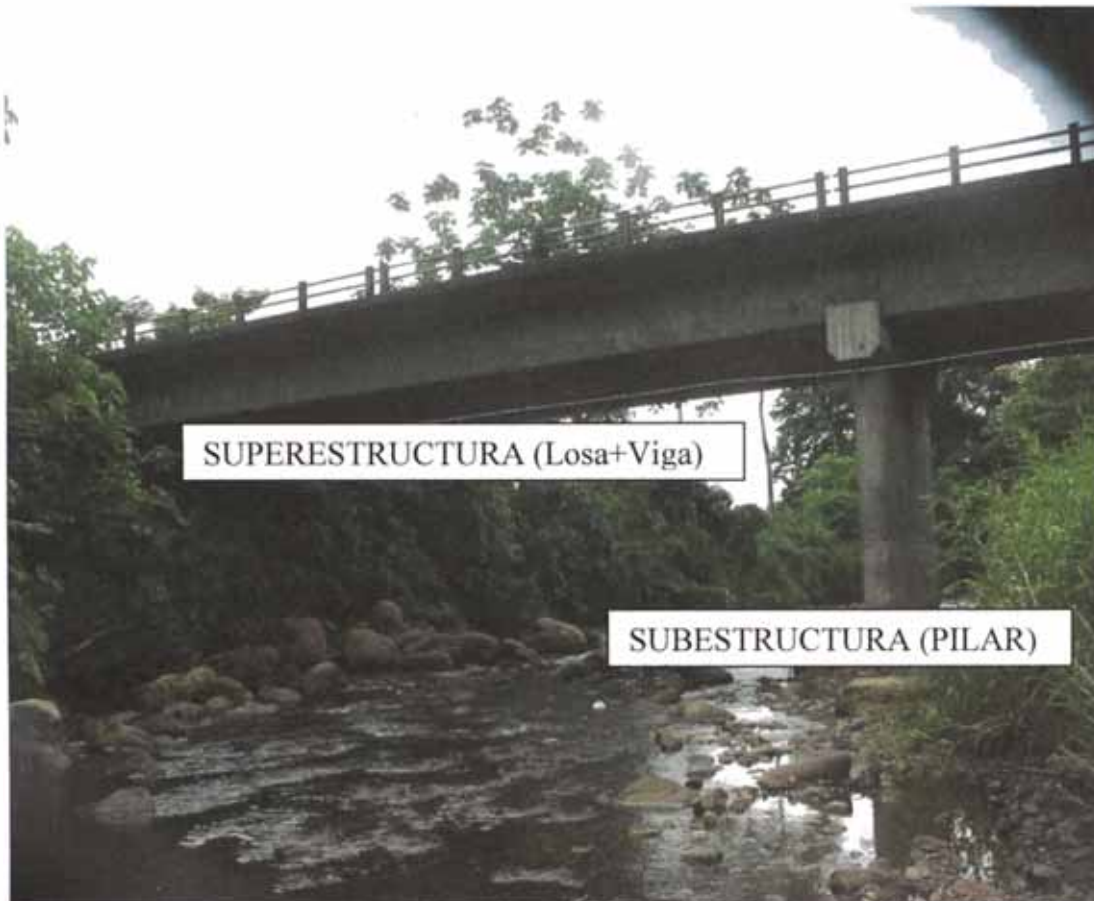
Figura N°1.6.- Vista actual de las partes principales del Puente Nochoz (Super estructura – Subestructura).
