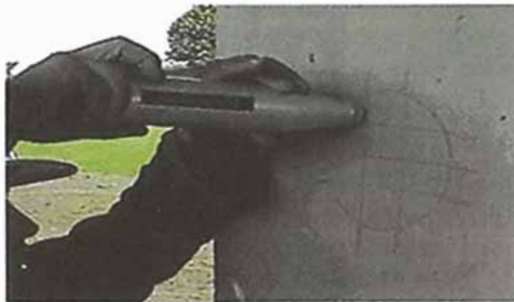
Figura N°2.7.- Ensayo de compresión del concreto por esclerómetro
