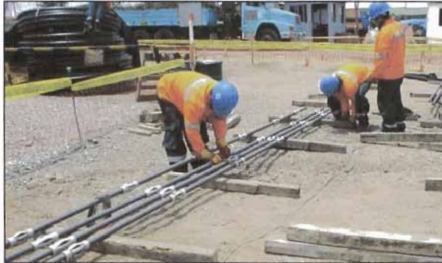
Figura 11. Colocación de Centralizadores. Fuente: Samayca Ingenieros.
