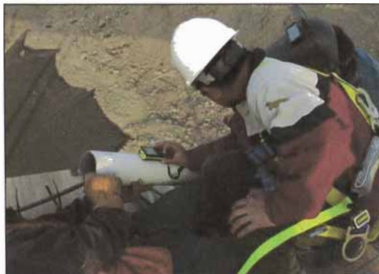
Figura 8. Medición de péndolas con láser. Fuente: Samayca Ingenieros.
