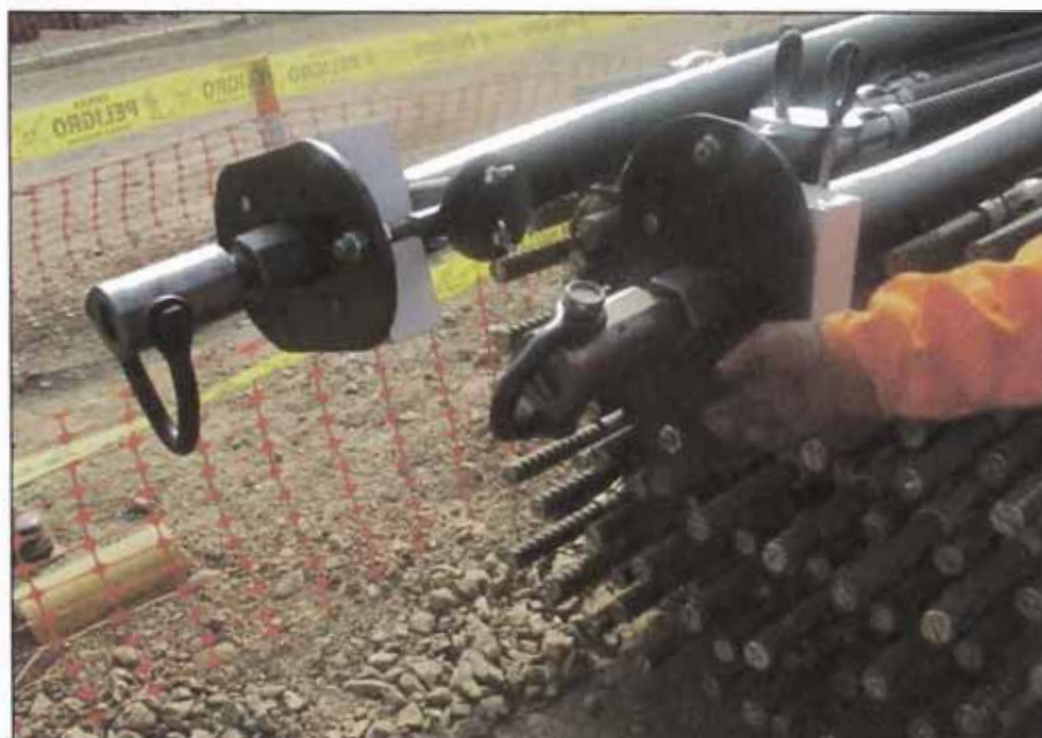
Figura 14. Colocación de Accesorios de Izaje. Fuente: Samayca Ingenieros.
