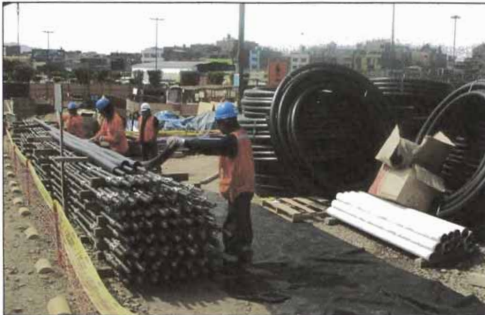
Figura 13. Colocación de Barras en Tubo Polietileno (PE). Fuente: Samayca Ingenieros.
