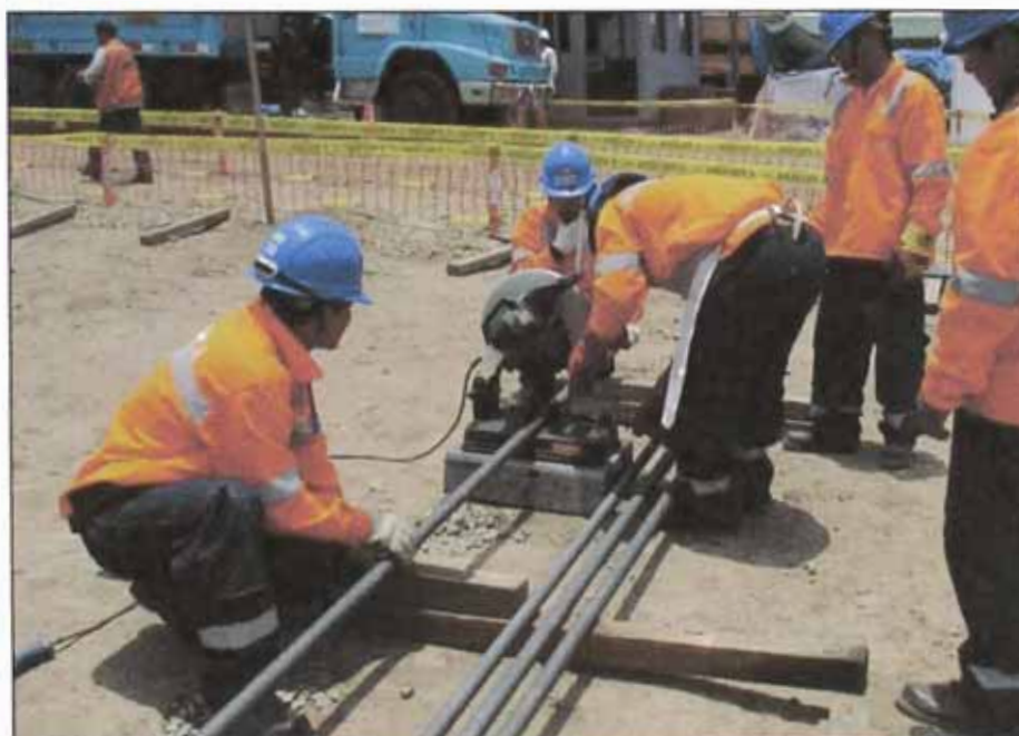
Figura 10. Corte de Barras. Fuente: Samayca Ingenieros.
