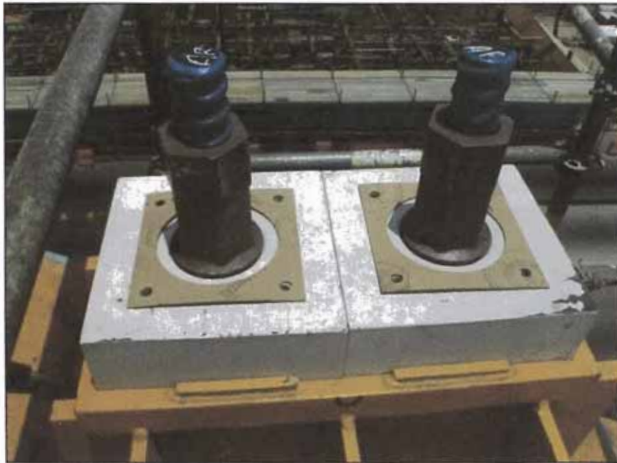
Figura 16. Colocación de Placas de Anclaje, Tuerca y Contratuerca. Fuente: Samayca Ingenieros.
