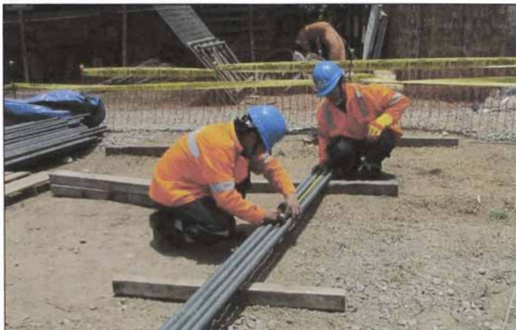
Figura 9. Medición de Barras. Fuente: Samayca Ingenieros.
