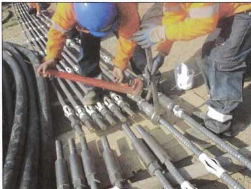
Figura 12. Colocación de Empalmes. Fuente: Samayca Ingenieros.
