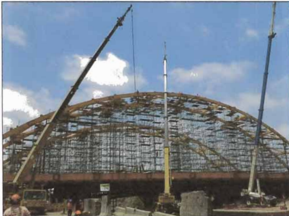
Figura 15. Izaje y colocación de Péndolas. Fuente: Samayca Ingenieros.
