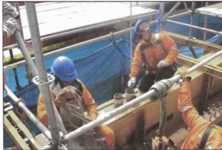
Figura 7. Medición con cinta métrica. Fuente: Samayca Ingenieros.
