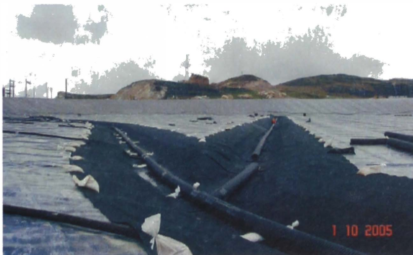
Figura 1.10 Construcción de las tuberías de colección (Cesar et al, 2014)
