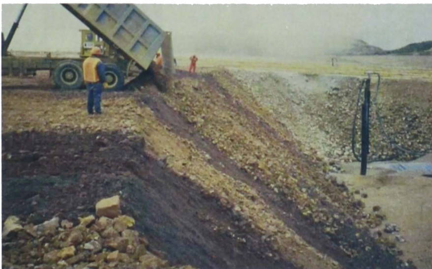
Figura 1.6: Ángulo de reposo del mineral colocado sobre el material de sobrevestimiento (Breitenbach y Thiel, 2005)
