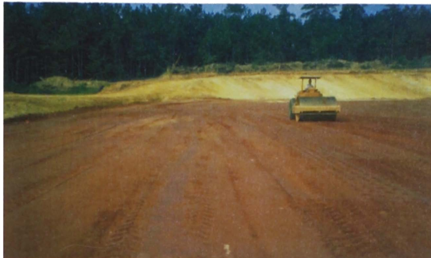
Figura 1.8: Compactación del suelo de baja permeabilidad (Breitenbach, 2013)
