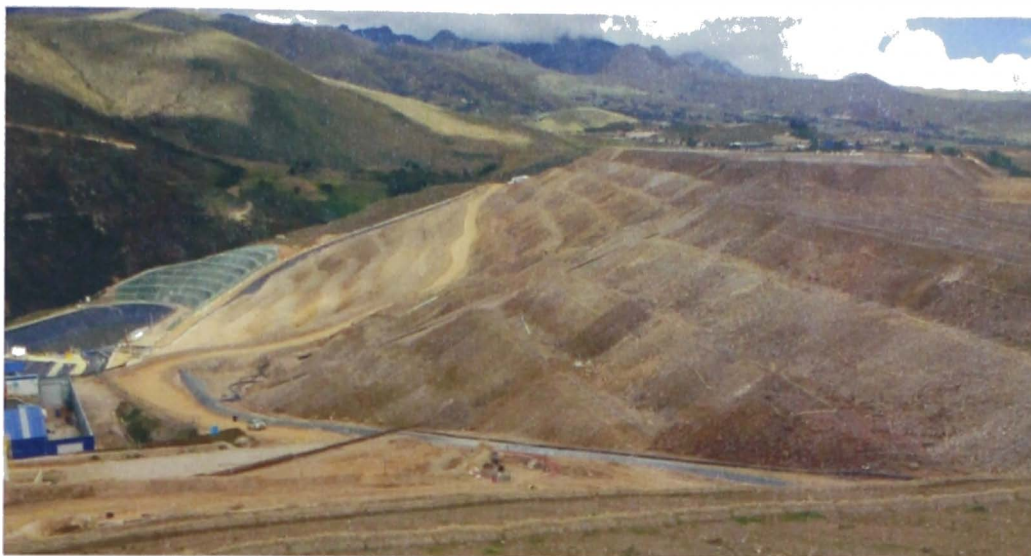
Figura 1.16: Fase 1 y 2 de la pila de lixiviación en estudio (fases en operación)
