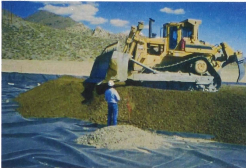
Figura 1.9: Colocación de capa de sob revesti miento (Breitenbach, 2013).
