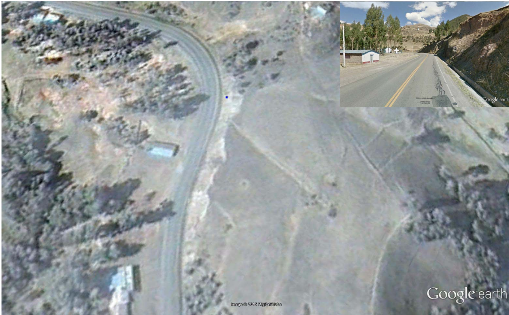
FOTO N° 14: Tramo de Concentración de accidentes N° 14 (Km. 290+800)
