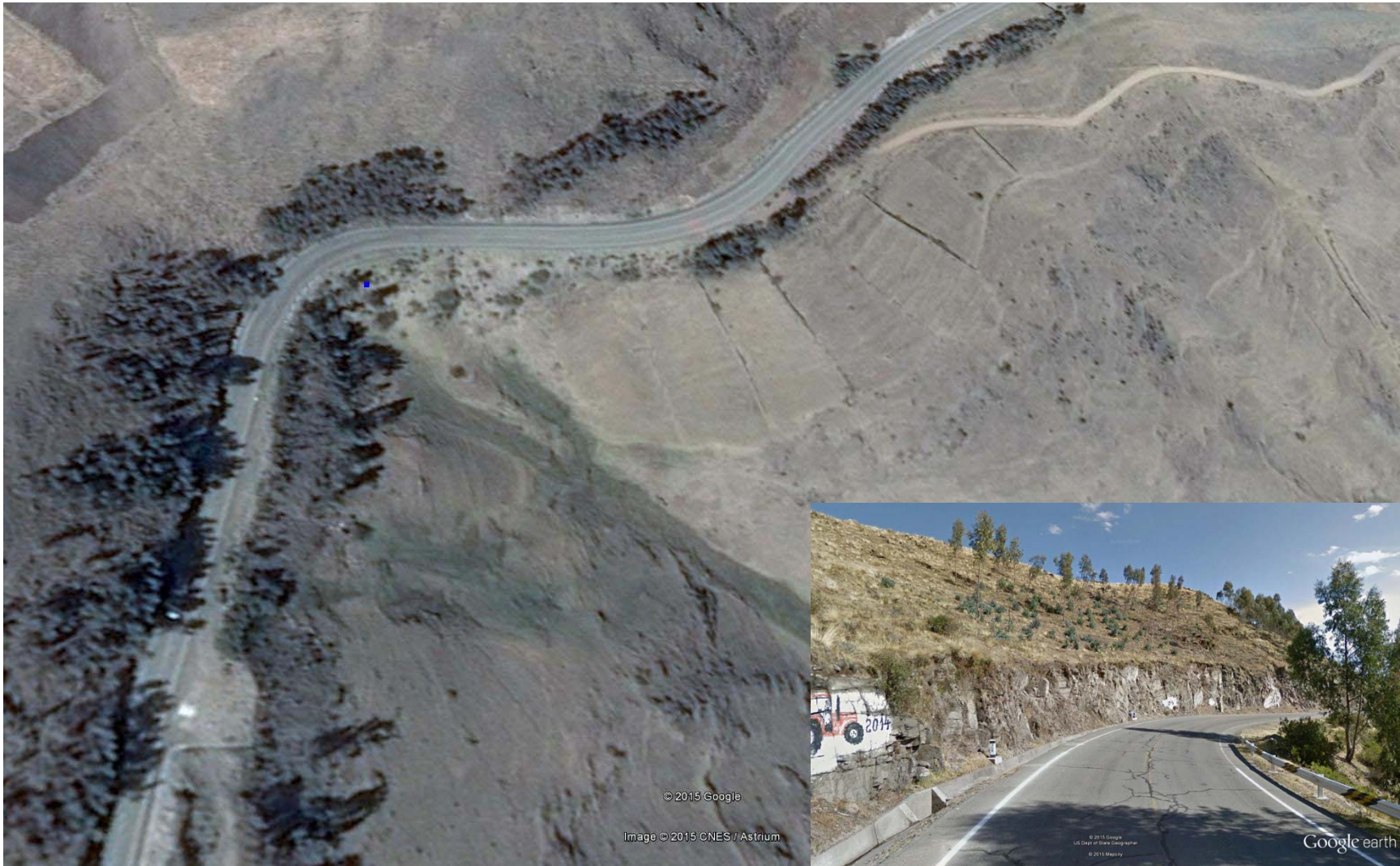
FOTO N° 18: Tramo de Concentración de accidentes N° 18 (Km. 308+000)
