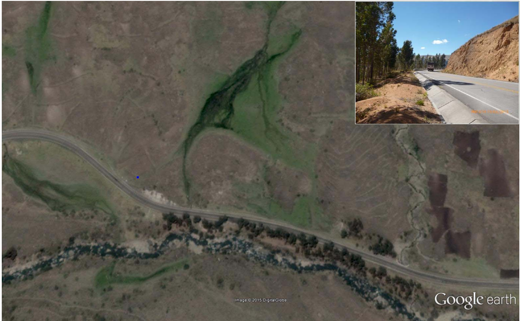
FOTO N° 12: Tramo de Concentración de accidentes N° 12 (Km. 269+200)
