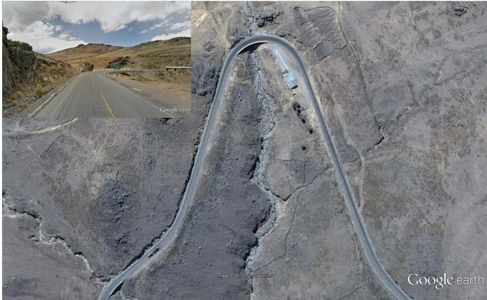
FOTO N° 03: Tramo de Concentración de accidentes N° 03 (Km. 138+500)
