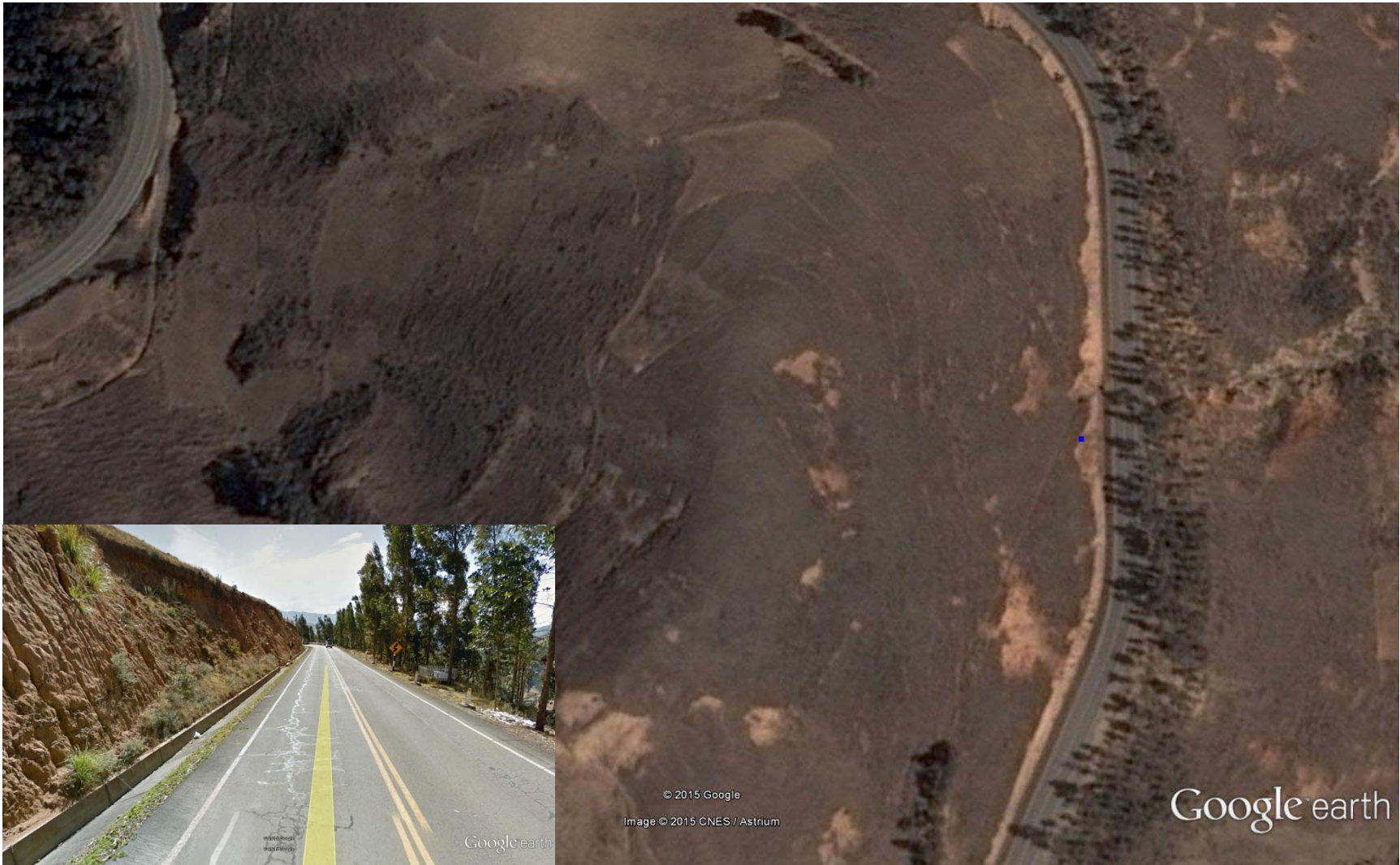
FOTO N° 15: Tramo de Concentración de accidentes N° 15 (Km. 297+500)
