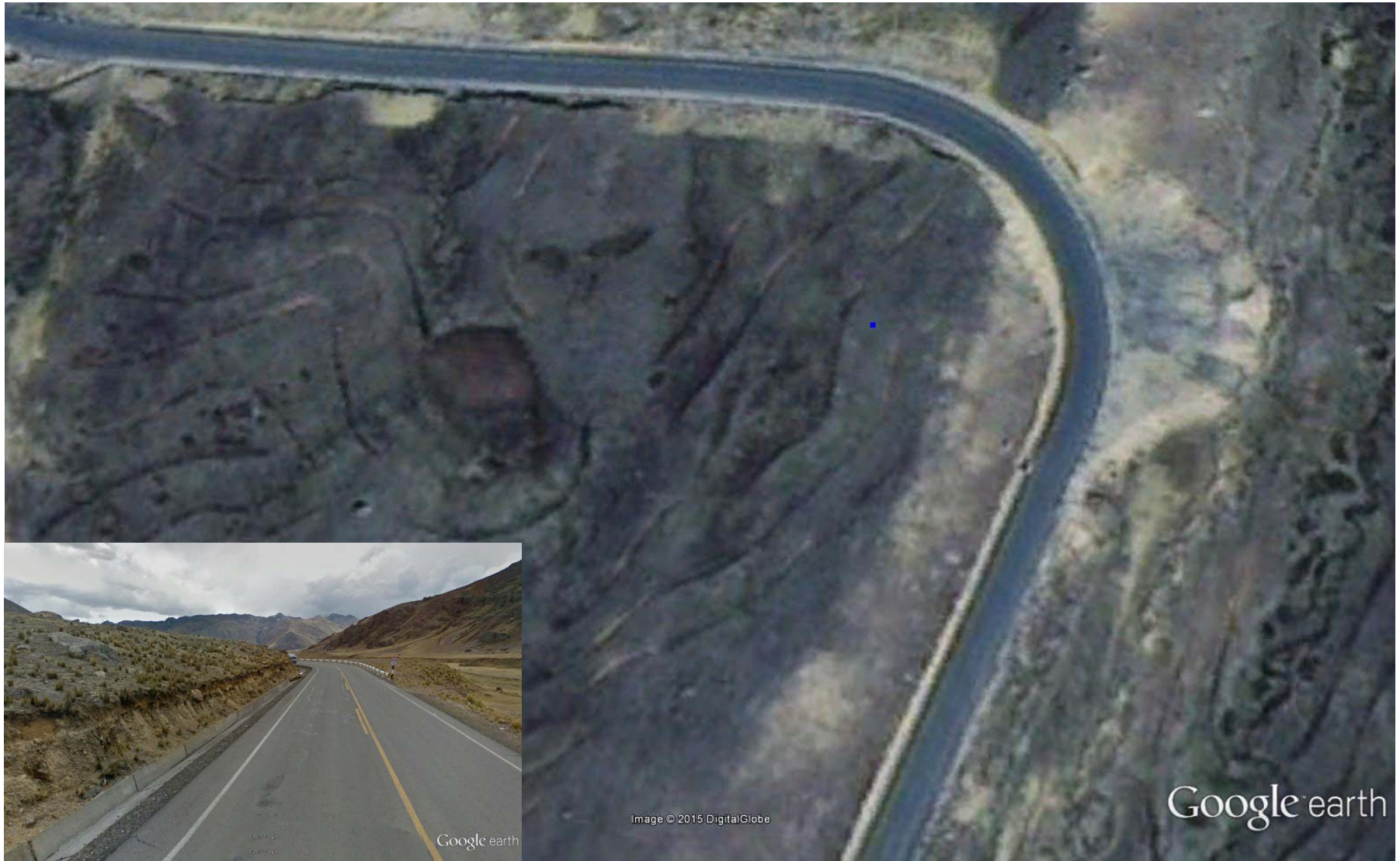
FOTO N° 08: Tramo de Concentración de accidentes N° 08 (Km. 219+400)
