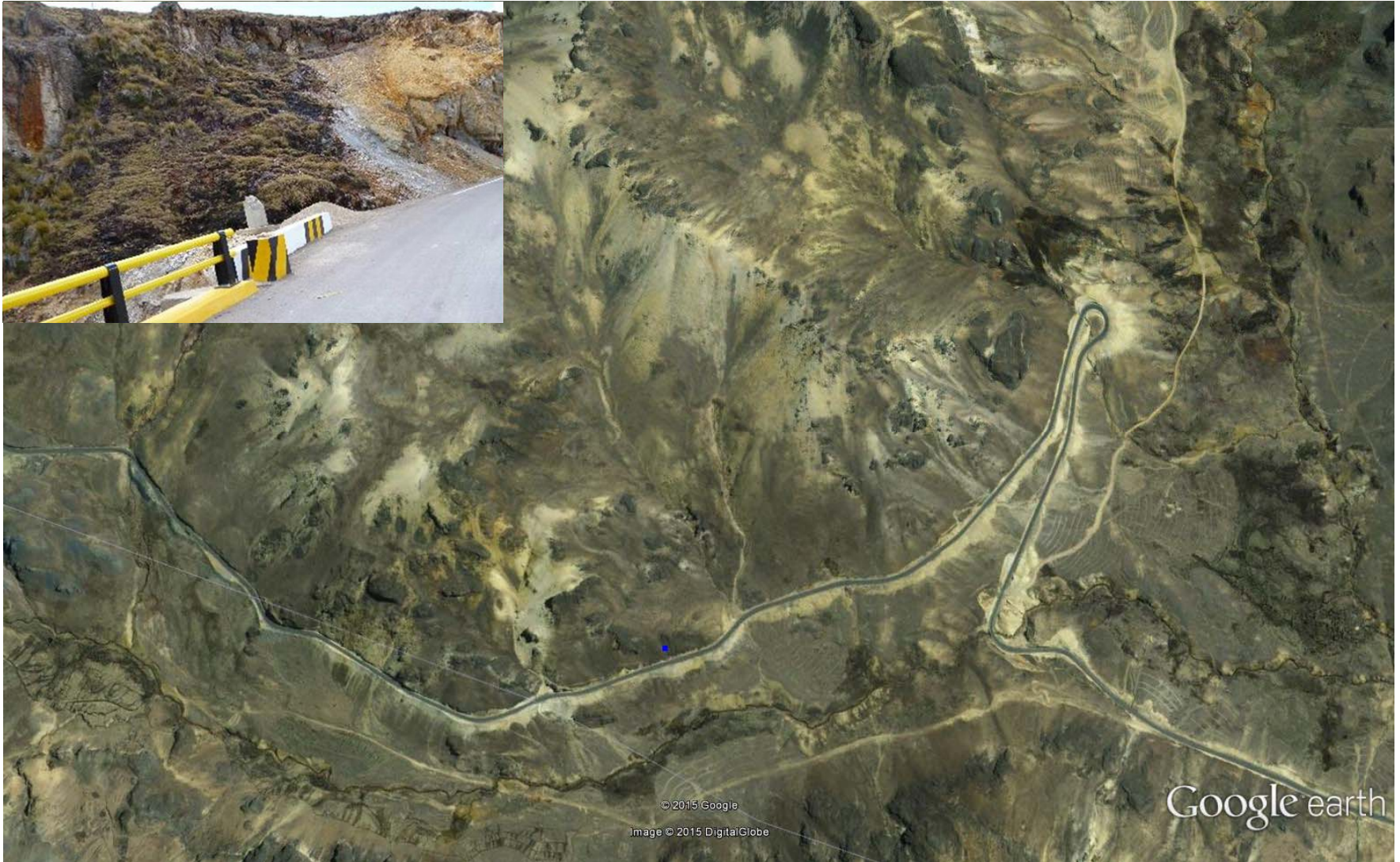
FOTO N° 10: Tramo de Concentración de accidentes N° 10 (Km. 247+200)
