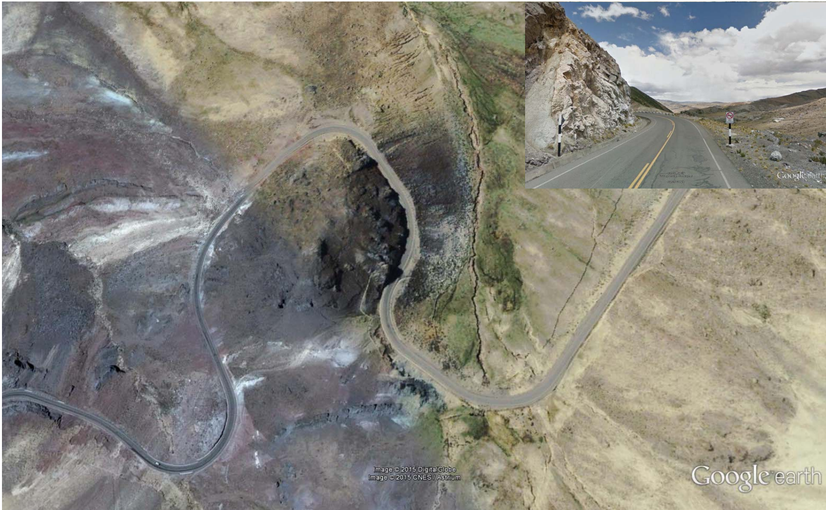
FOTO N° 06: Tramo de Concentración de accidentes N° 06 (Km. 184+700)
