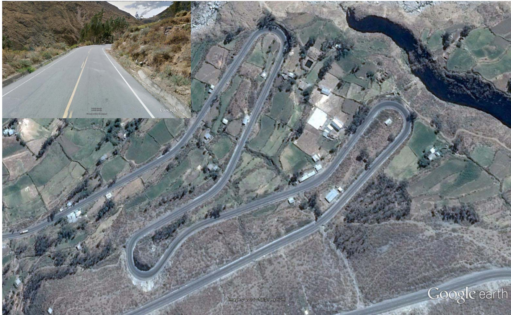
FOTO N° 02: Tramo de Concentración de accidentes N° 02 (Km. 116+500)
