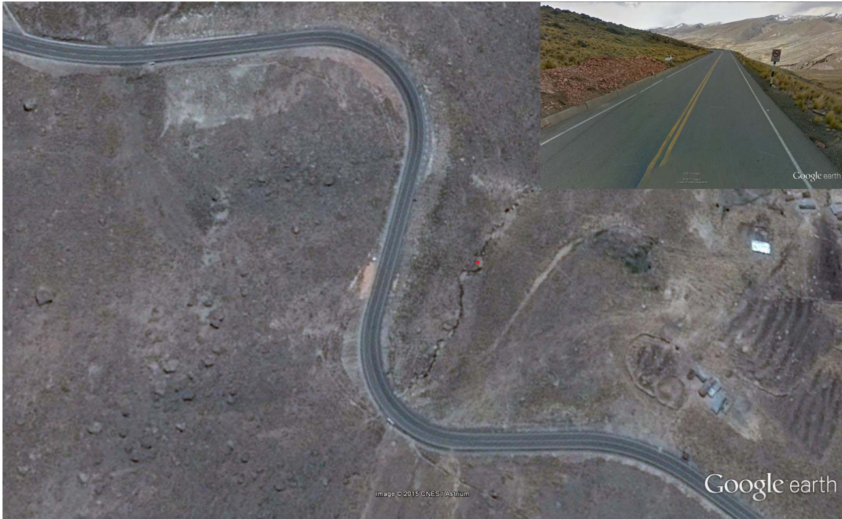
FOTO N° 07: Tramo de Concentración de accidentes N° 07 (Km. 206+500)
