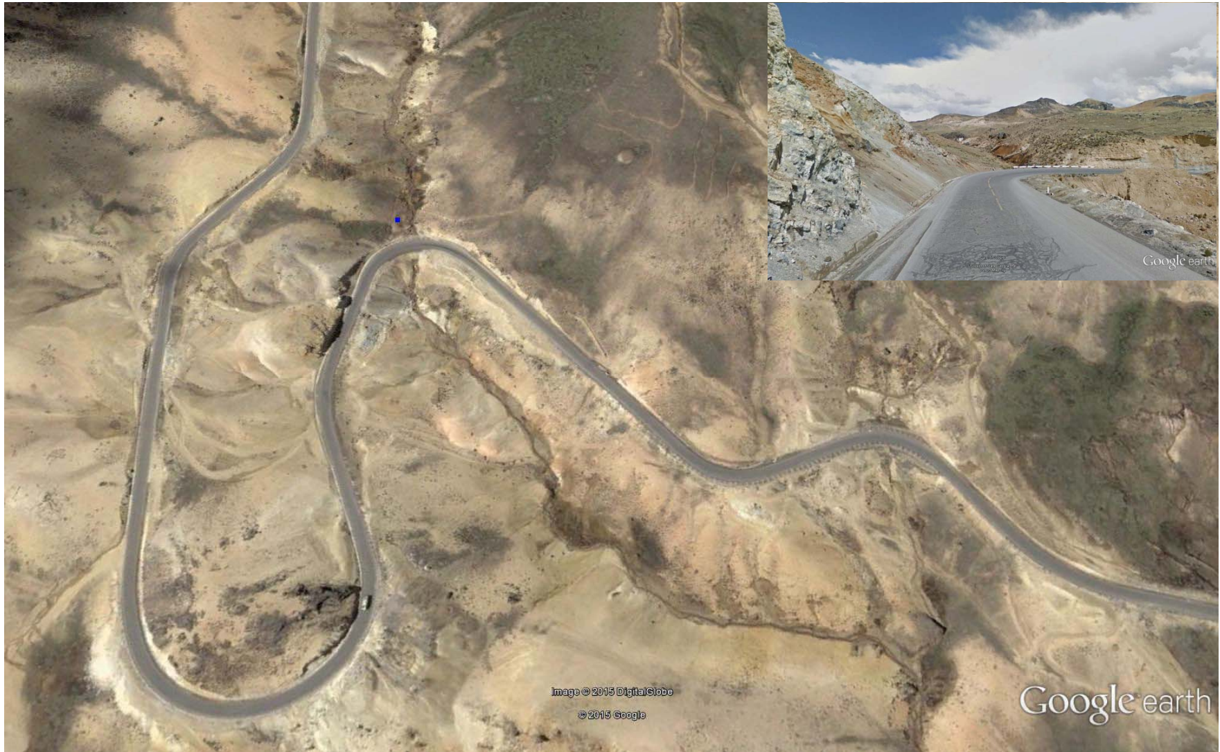
FOTO N° 09: Tramo de Concentración de accidentes N° 09 (Km. 230+700)
