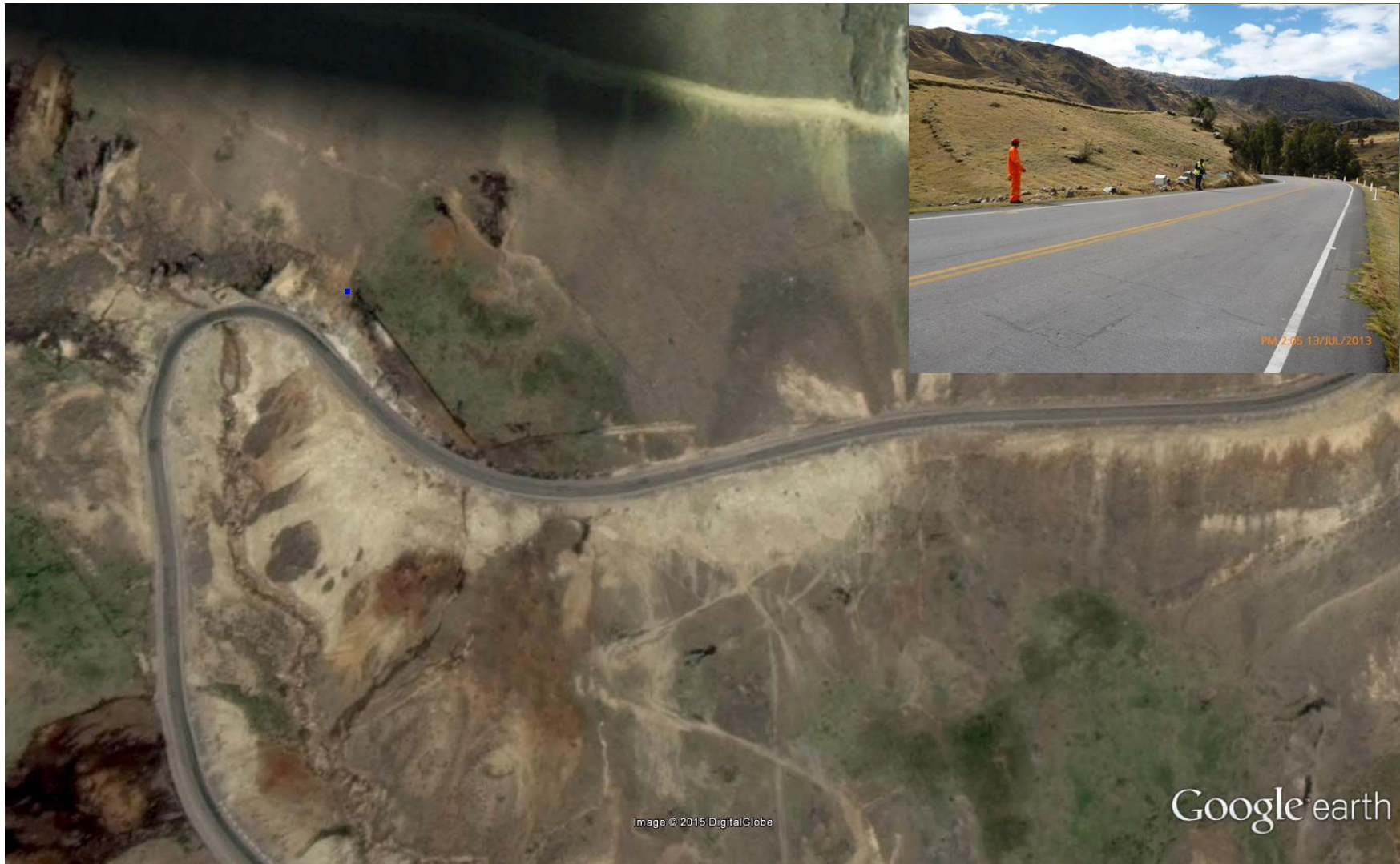
FOTO N° 11: Tramo de Concentración de accidentes N° 11 (Km. 263+100)
