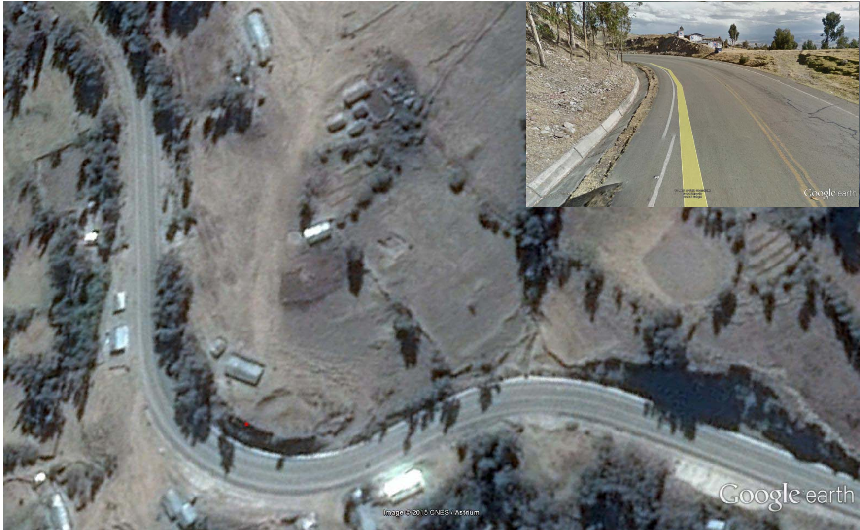
FOTO N° 17: Tramo de Concentración de accidentes N° 17 (Km. 304+200)
