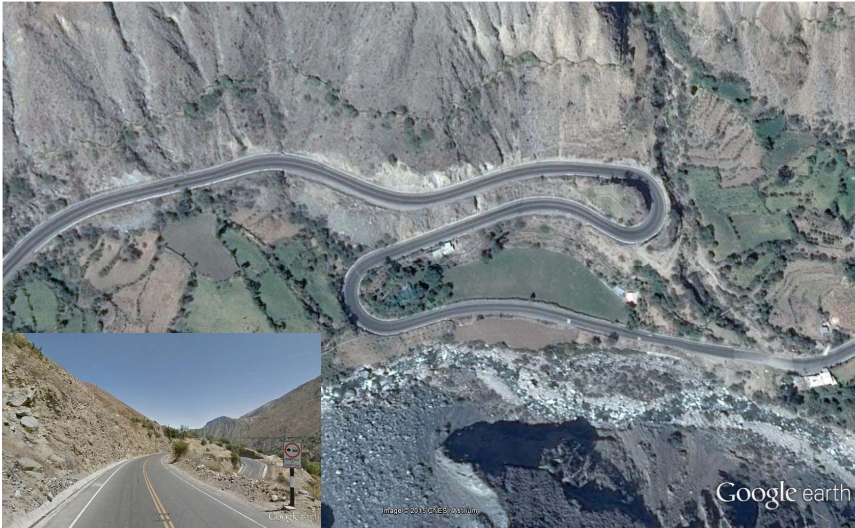
FOTO N° 01: Tramo de Concentración de accidentes N° 01 (Km. 99+700)
