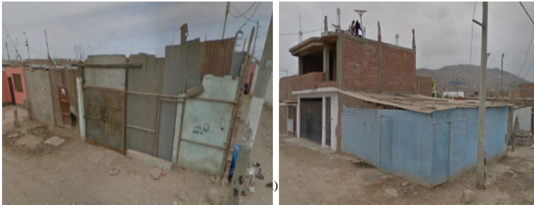
Figura 8-11: En las vistas a y b se muestran los materiales provisionales empleados en las viviendas
