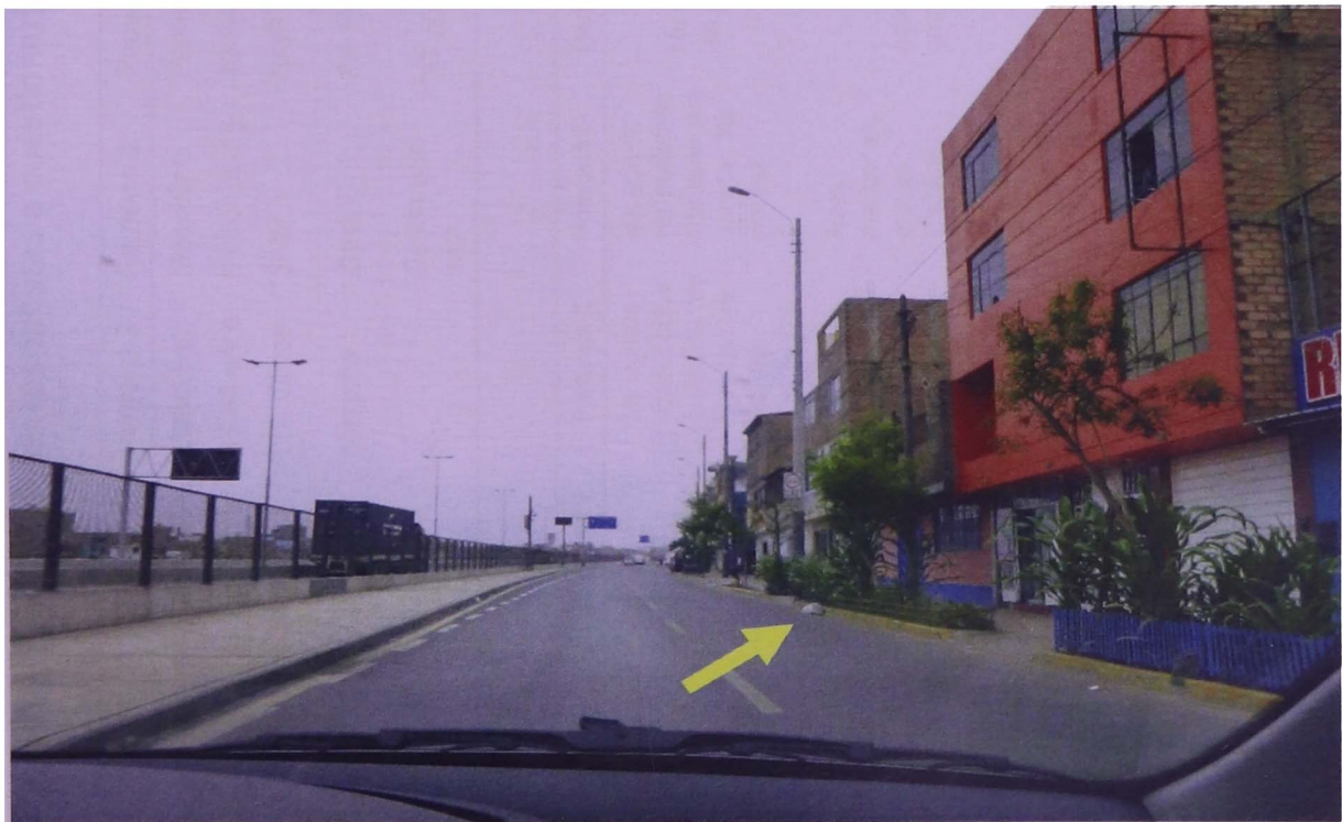
Fotografía 6: Recorrido en la Av. Morales Duárez. A la mano izquierda se visualiza la LA que separa a los vecinos de Cercado con respecto al río Rímac. A la mano derecha se visualiza el cuidado de la vegetación fuera de sus viviendas; sin embargo, se observó también bolsas de residuos en la vía – 24/11/2020.
