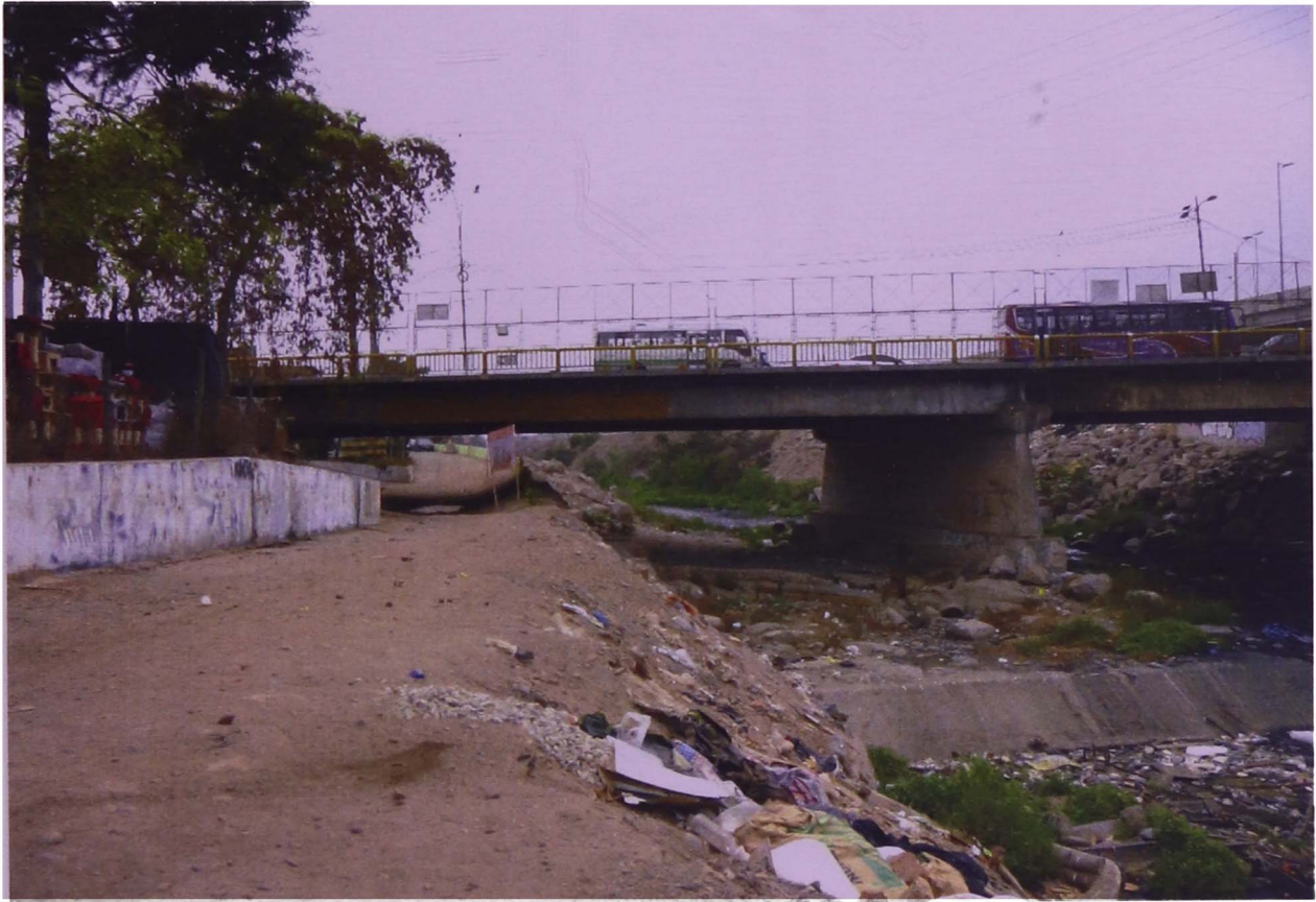
Fotografía 4.1-2: Visita de campo. La fotografía se tomó desde la Av. Malecón Rímac hacia el puente Dueñas, se aprecia zona de desnivel y residuos sólidos vertidos al río – 24/11/2020. (B)
