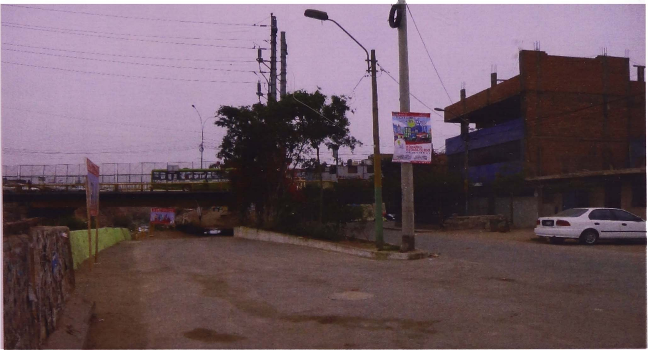
Fotografía 4.1-3: Visita de campo. Vista al puente Dueñas desde Av. Malecón Rímac, en la parte debajo del puente se tiene restringido el acceso – 24/11/2020. (C)
