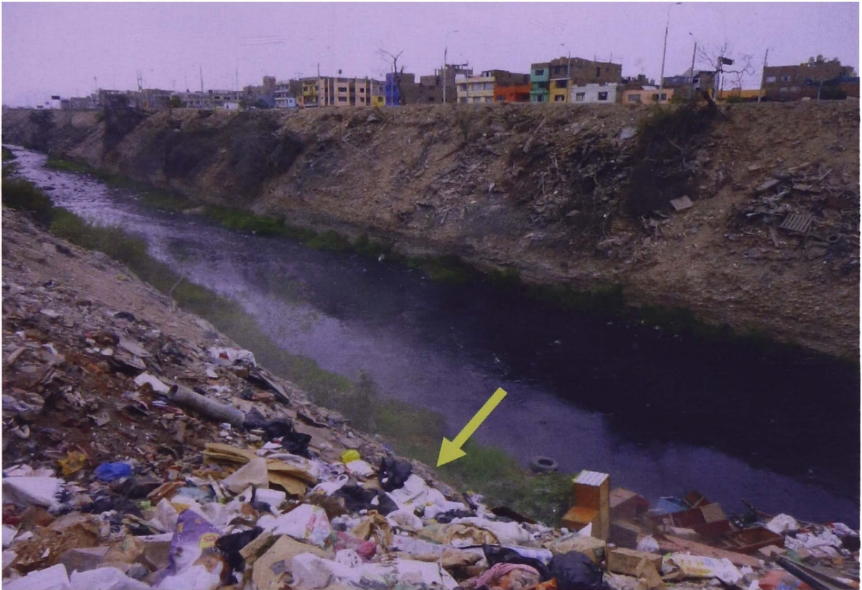
Fotografía 1: Vista del río Rímac desde el puente peatonal Bella Unión, fotografía tomada desde la parte de SMP. Se visualiza residuos y desmonte en el cauce del río, vertidos desde el mismo puente; pese a ello se aprecia pequeña vegetación – 23/07/2020.
