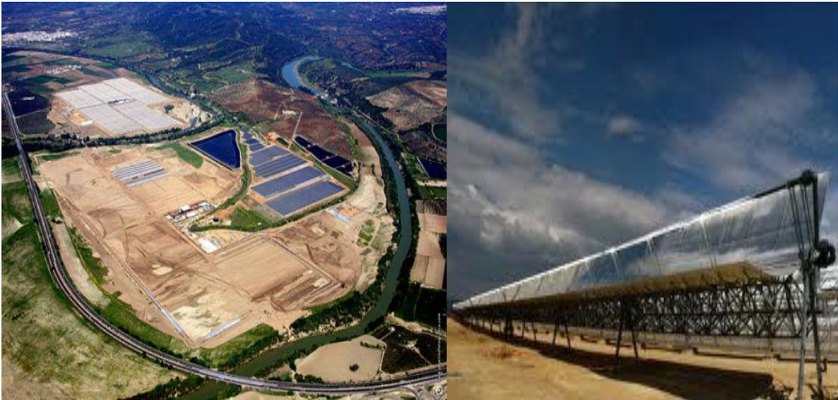
**Figura 1.6: Central termo solar Solarcor 1 con tecnología de espejos parabólicos**
