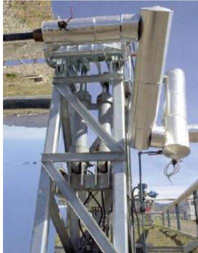
**Figura 5.14: Sistema hidráulico de un colector.**
