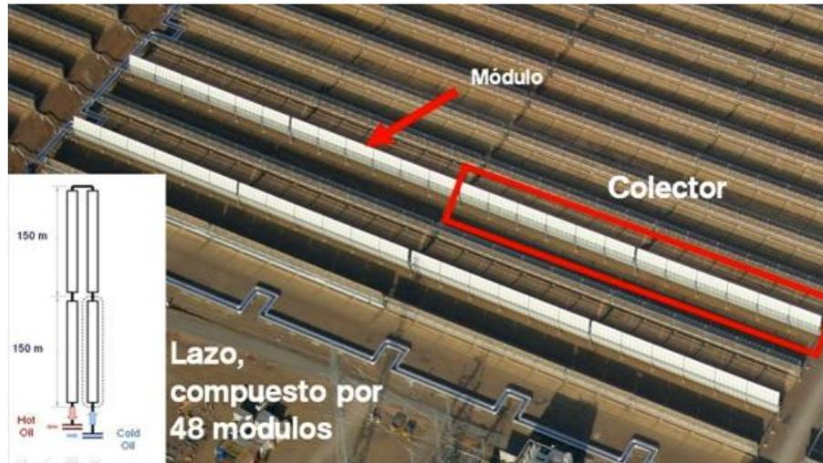
**Figura 5.6: Módulo y colector cilindro - parabólicos**
