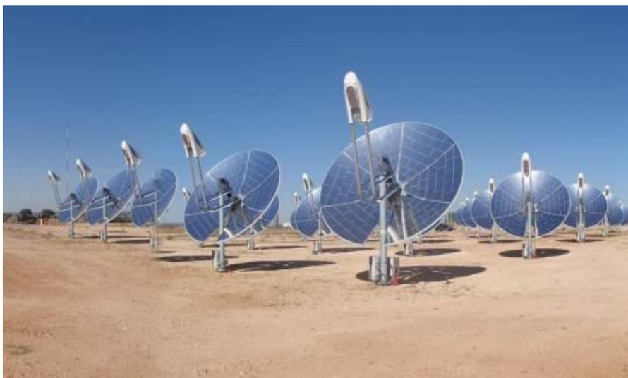
**Figura 1.10: CT de Renovalia en Villarobledo (España), con 33 discos Stirling de Infinia Corp. y 1 MW.**
