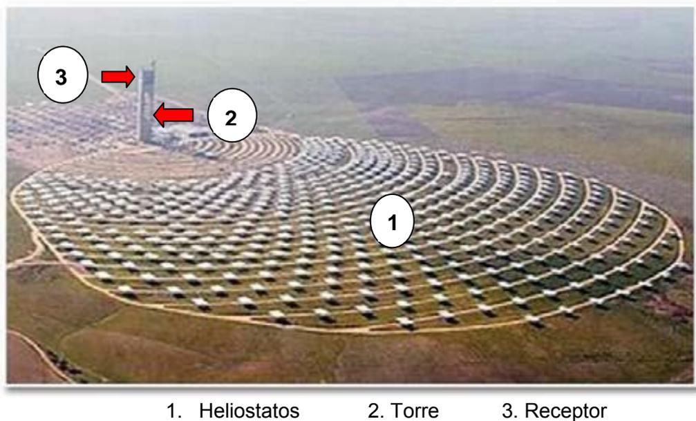
**Figura 1.7: Partes principales de la tecnología termo solar de torre central**
