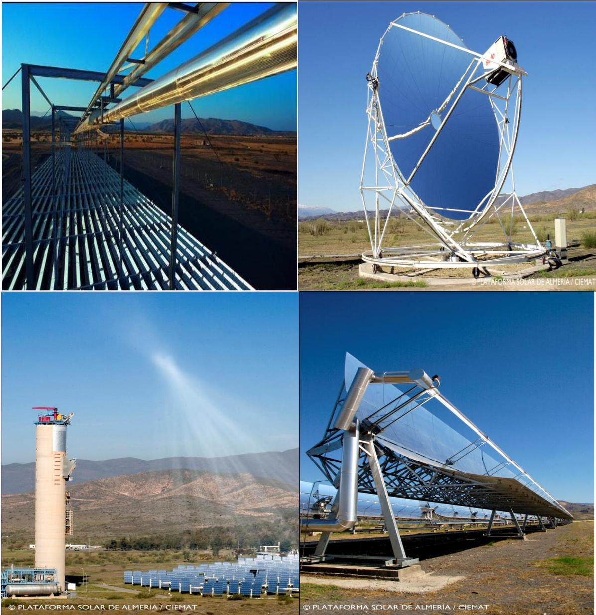
**Figura 1.3: Tecnologías termo solares de la Plataforma Solar de Almería (España)**
