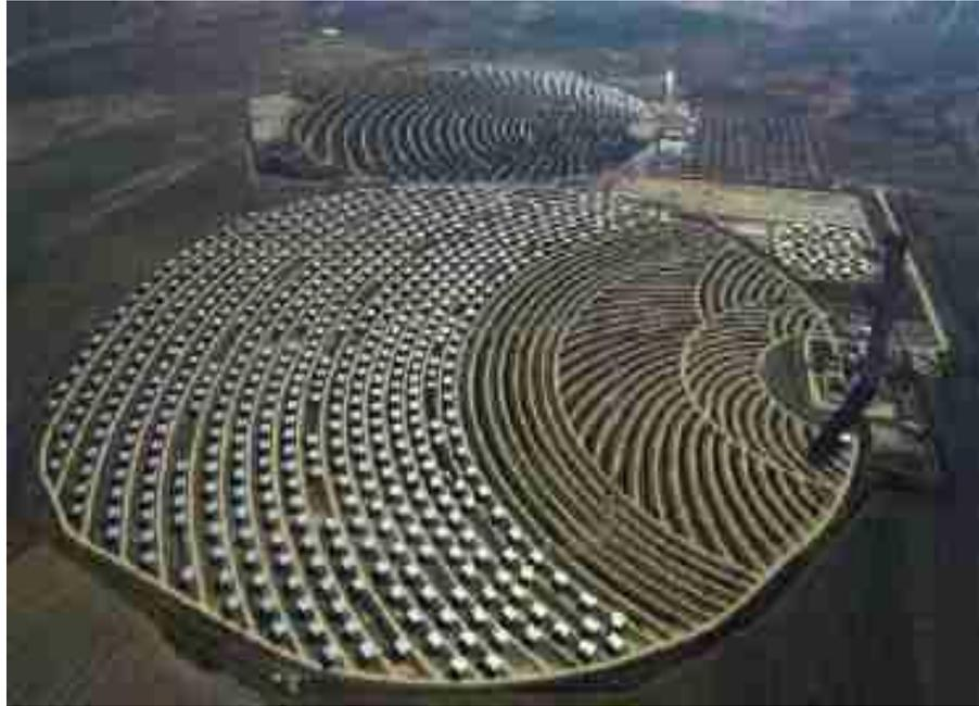
**Figura 1.8: CT Gemasolar, planta de energía solar con receptor central (RC) de 19,9 MW, ubicada en Fuentes, Andalucía, Sevilla (España).**
