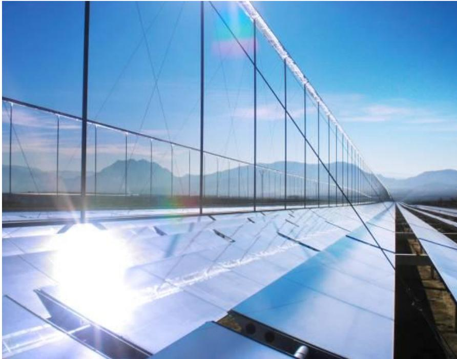
**Figura 1.12: Colectores solares Fresnel de la CT Puerto Errado I en Murcia (España) de 1.4 MW**
