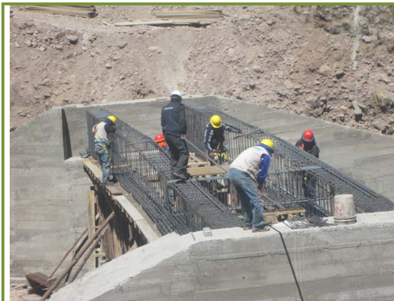
Puente Carrozable en el rio Palca del sector Ruelas, armado del acero de superestructura Fecha 15//09/2013
