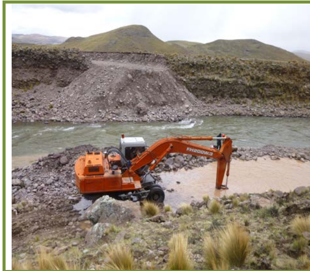
Puente Carrozable en el rio Palca del sector Ruelas, Excavación Para las zapatas del estribo. Fecha 17/12/2012
