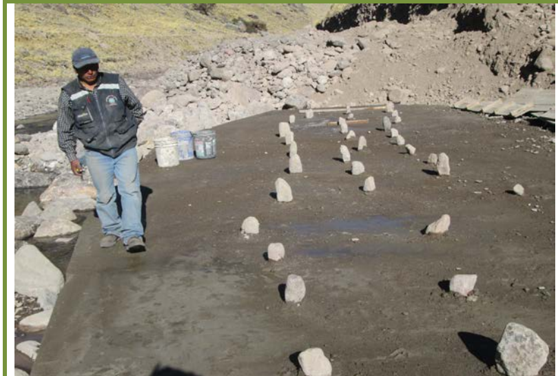
Puente Carrozable en el rio Palca del sector Ruelas, vaceado del estribo Fecha 20//07/2013
