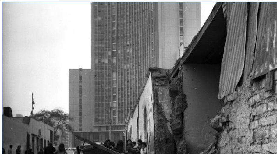
Figura 76. Daños ocasionados en el Distrito de Lima luego del terremoto del 3 de octubre de 1974. (Archivo histórico El Comercio).
