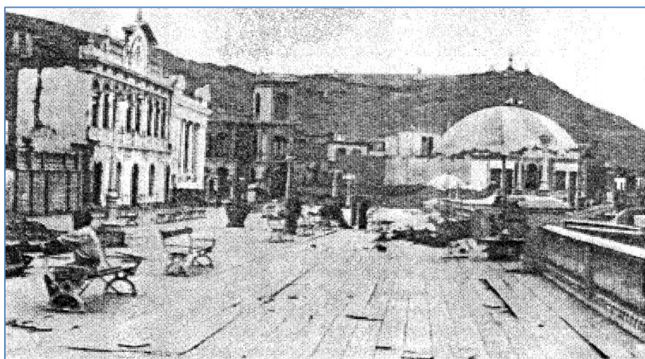
Figura 75. Terremoto ocurrido el 24 de mayo de 1940. Destrucción del antiguo malecón de Chorrillos. (Silgado, 1974).
