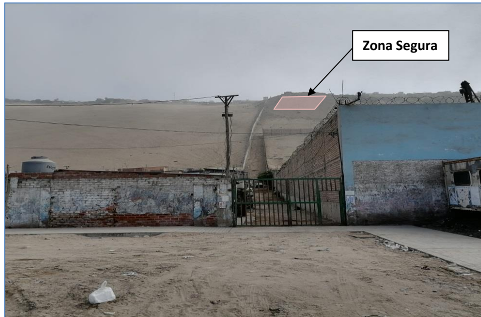
Figura 83. Ruta de evacuación sur. Lugar identificado como zona segura (parte superior), se puede observar que la ruta de evacuación (puerta de reja) en la vía Panamericana Sur no presenta señaléticas de ruta de evacuación.
