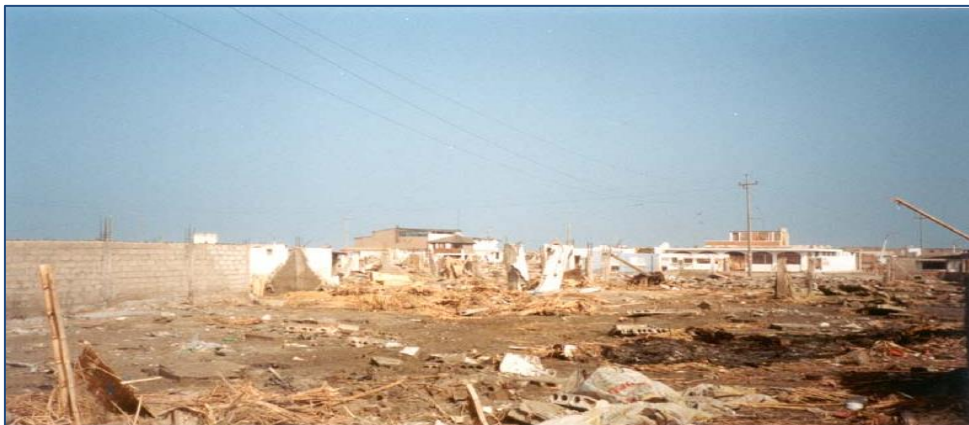
Figura 78. Daños ocasionados por el balneario de Camaná debido al Tsunami producido por el terremoto de Arequipa de 23 de junio de 2001. (Tavera,2002).
