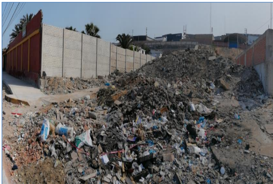
Figura 84. Ruta de evacuación norte. Lugar identificado como zona segura, se puede observar que actualmente la ruta de evacuación se encuentra con desmontes obstaculizando la evacuación.
