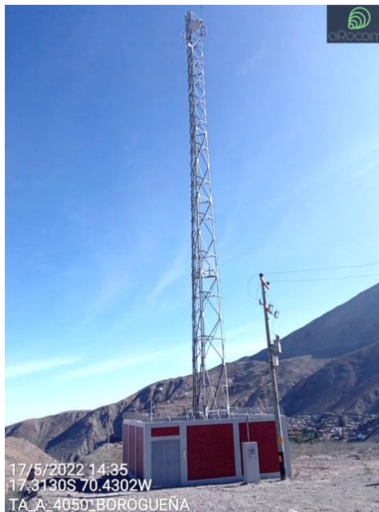
Figura 17: Vista exterior de un Nodo tipo Acceso típico
