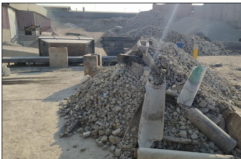
Figura 1 Planta de producción del agregado reciclado.
