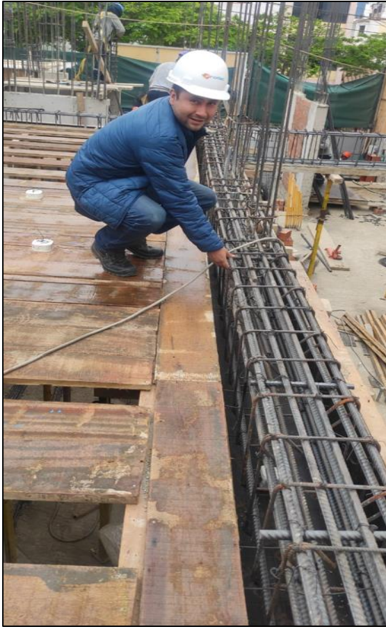
Supervisión de obra armado de vigas
