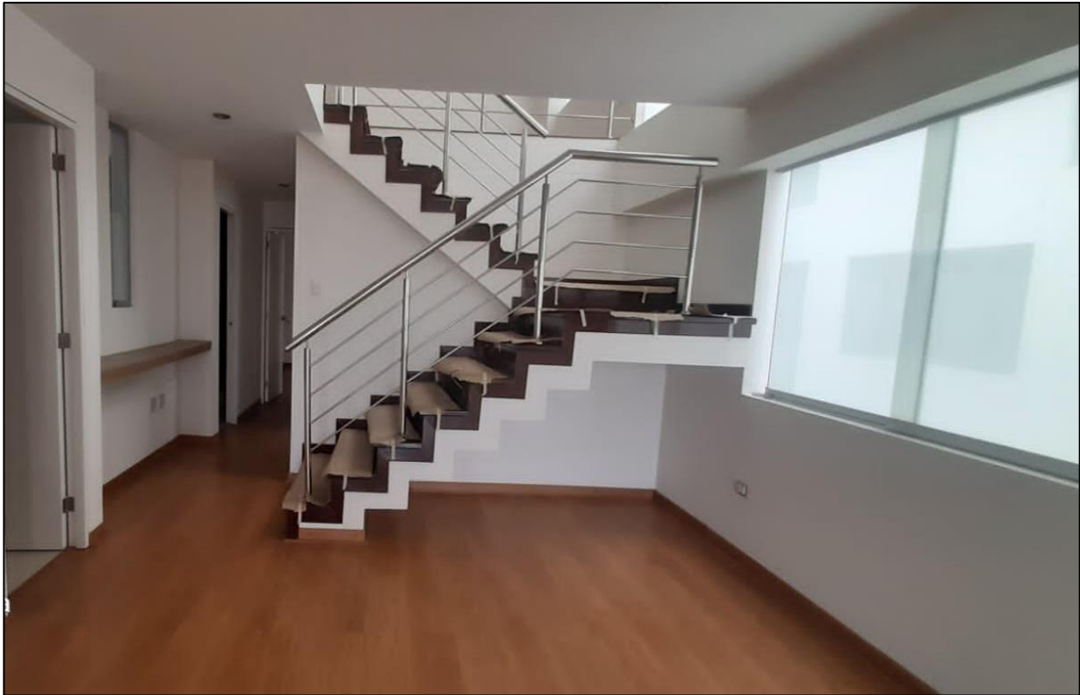
Etapa de acabados interiores – escalera/piso
