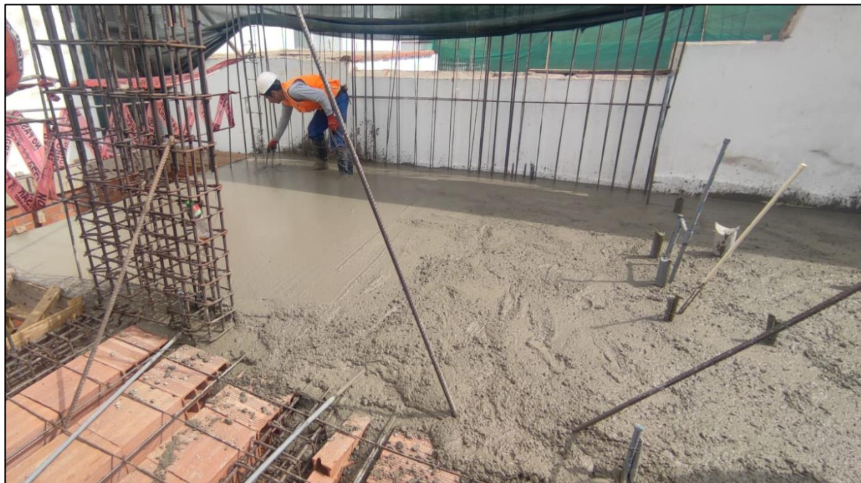
Etapa de vaciado - losa aligerada
