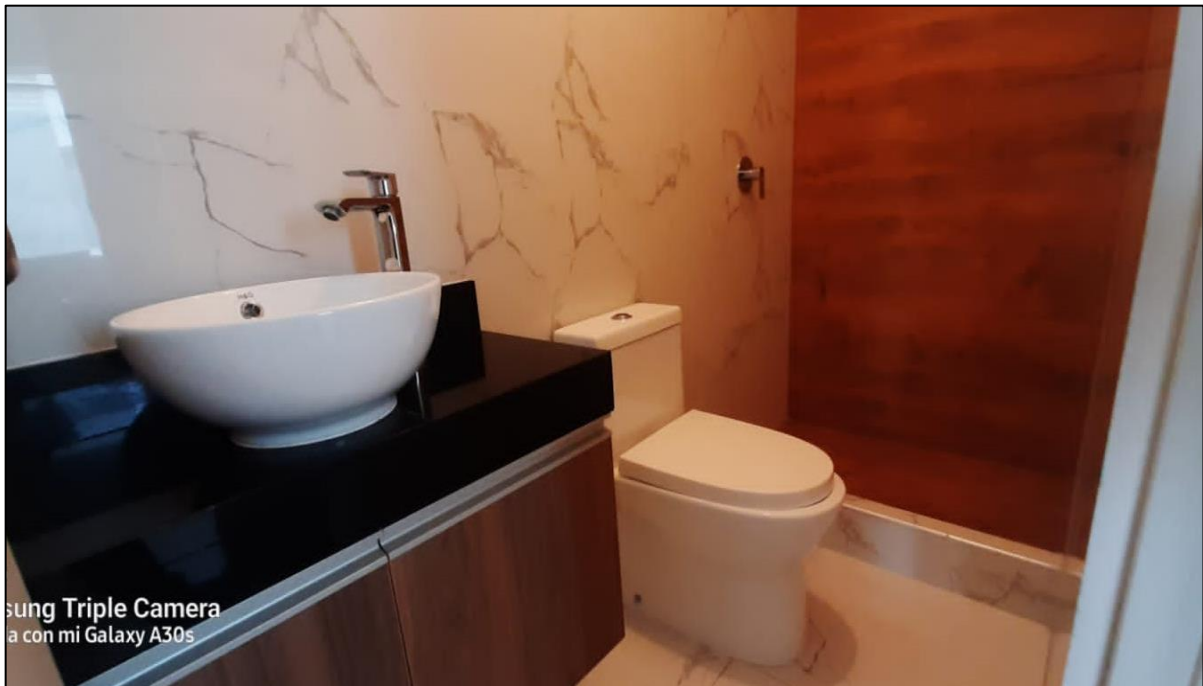
Etapa de acabados interiores – servicio higiénico
