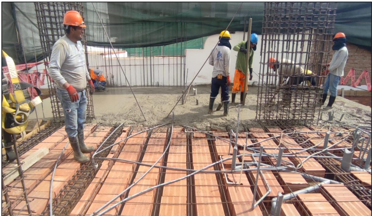
Etapas de vaciado – losa aligerada
