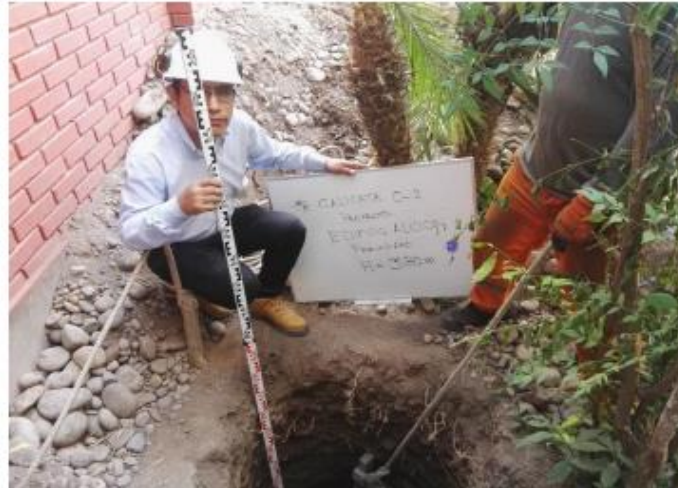
FOTO 7.- Vista exterior calicata 02 (3.80 m)
