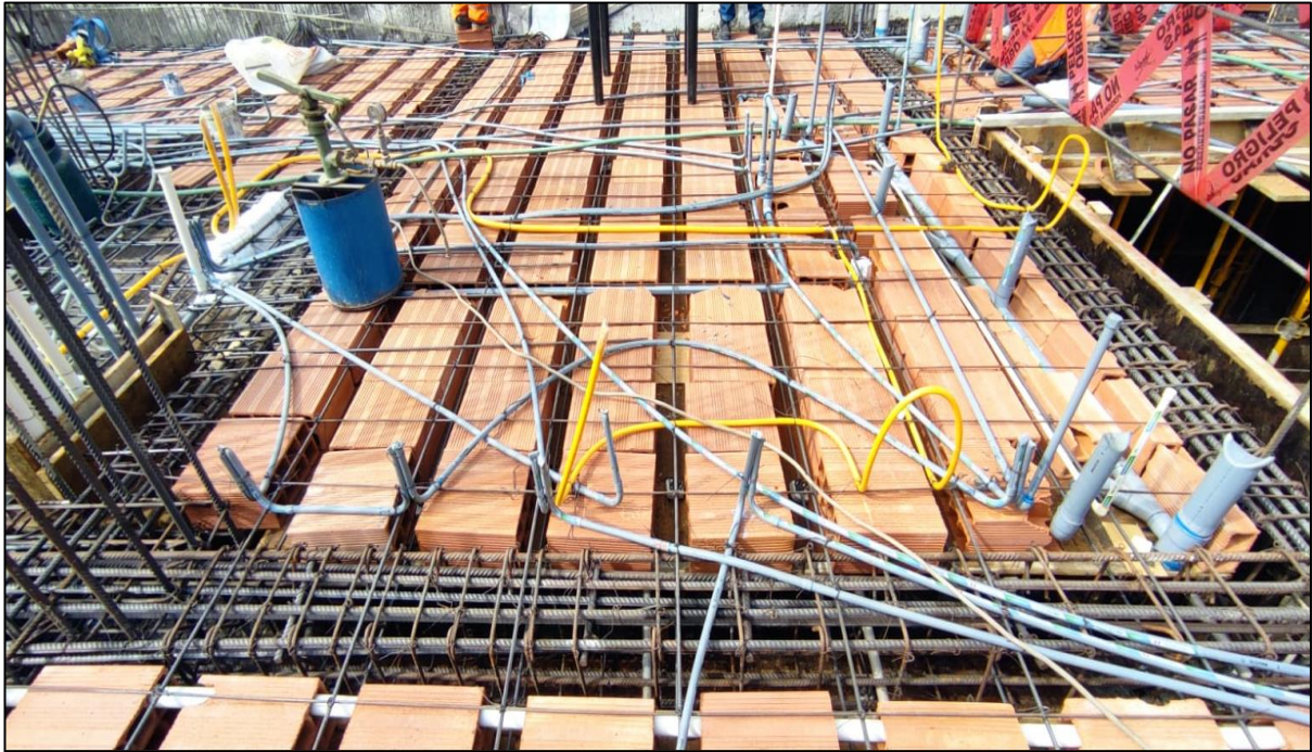
Etapas de armado de vigas /colocación de ladrillos de techo/ instalaciones
