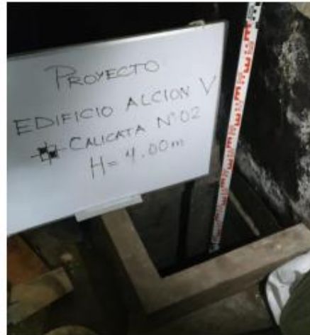
FOTO 6.- Vista exterior calicata 02 (4.00 m)
