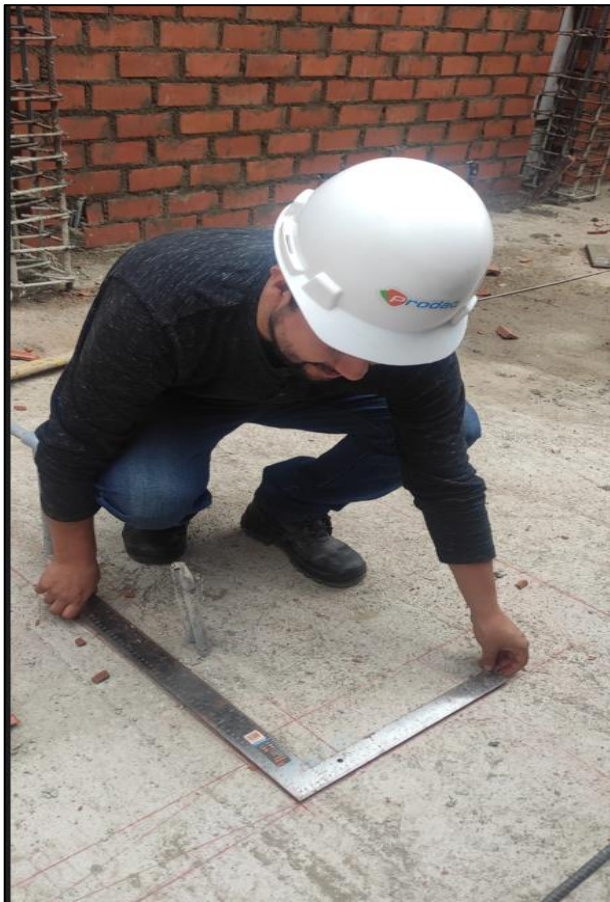
Supervisión de obra albañilería (trazado/nivel)
