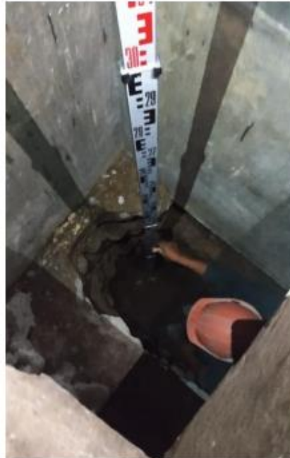
FOTO 7.- Vista exterior calicata 02
