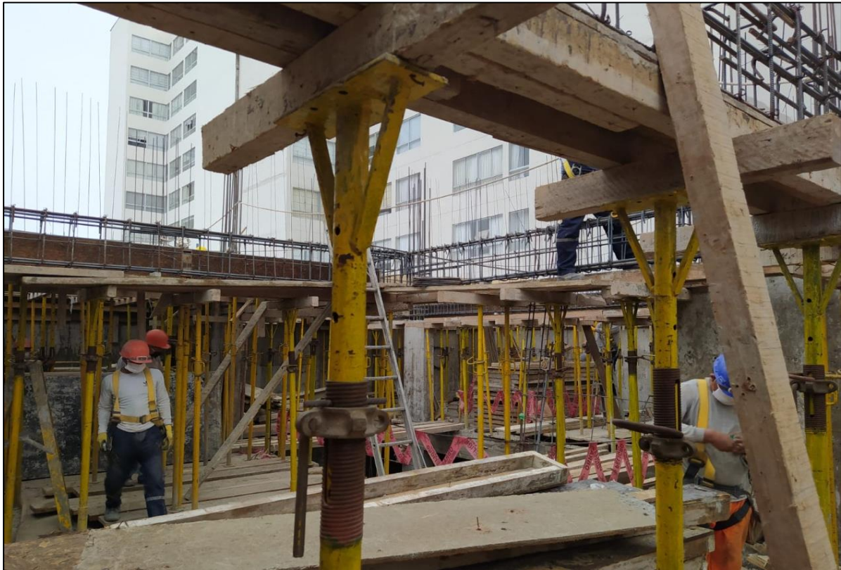
Etapa de encofrado vigas, columnas y placas
