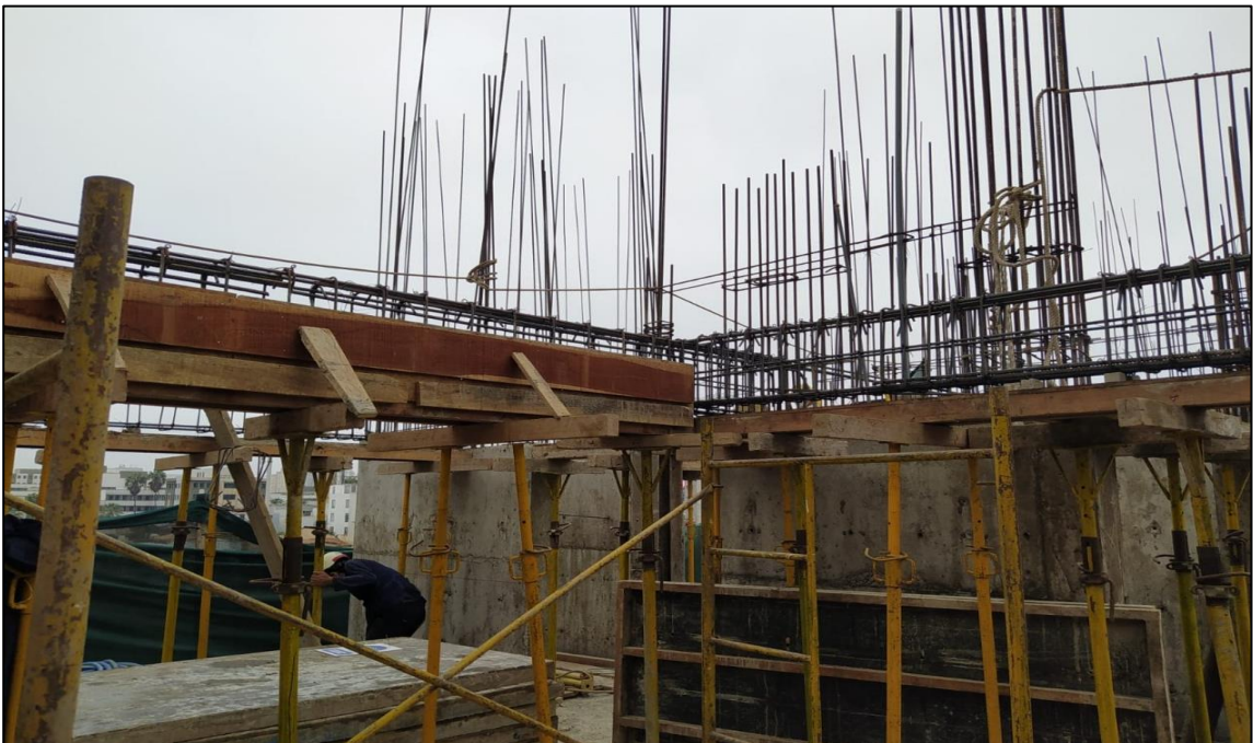
Etapas de armado de vigas
