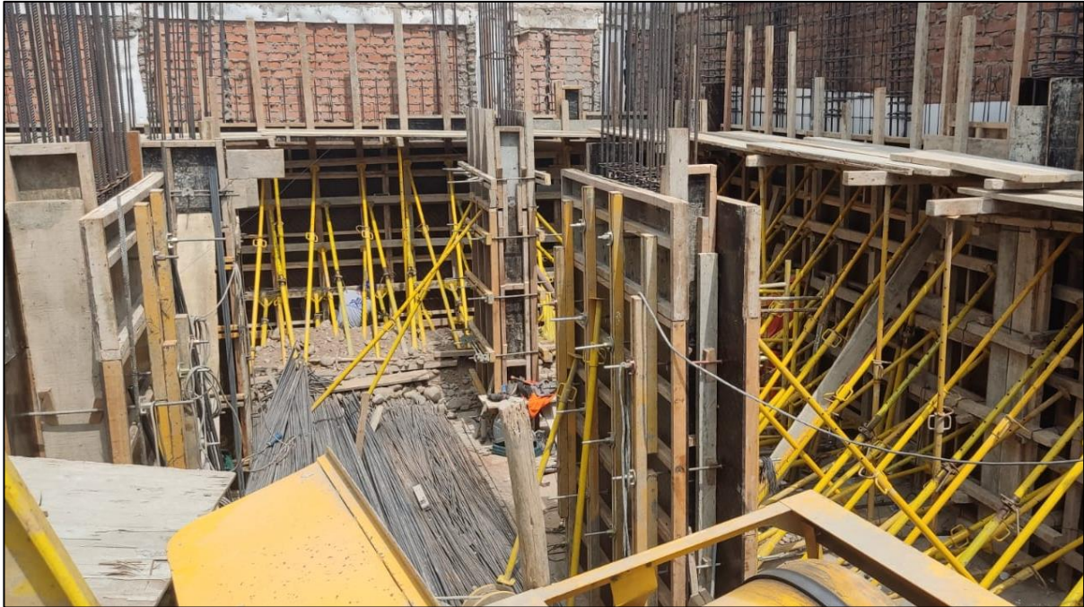
Etapa de encofrado vigas, columnas y placas
