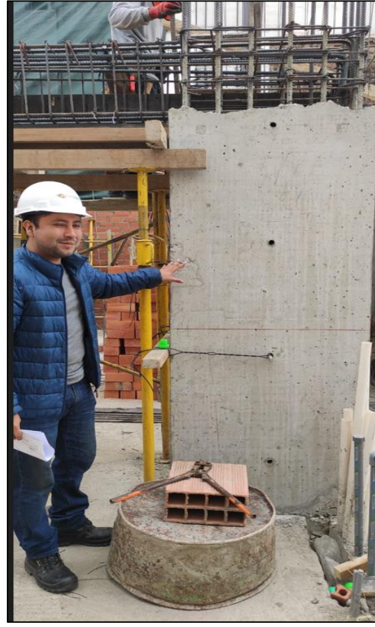
Supervisión de obra (desenfofrado de columna)
