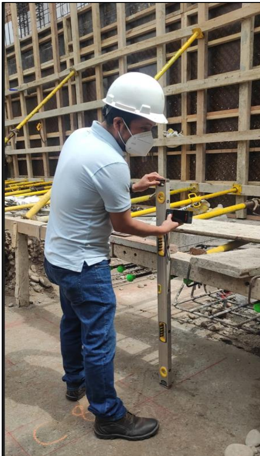
Supervisión de obra (trazado de columnas)
