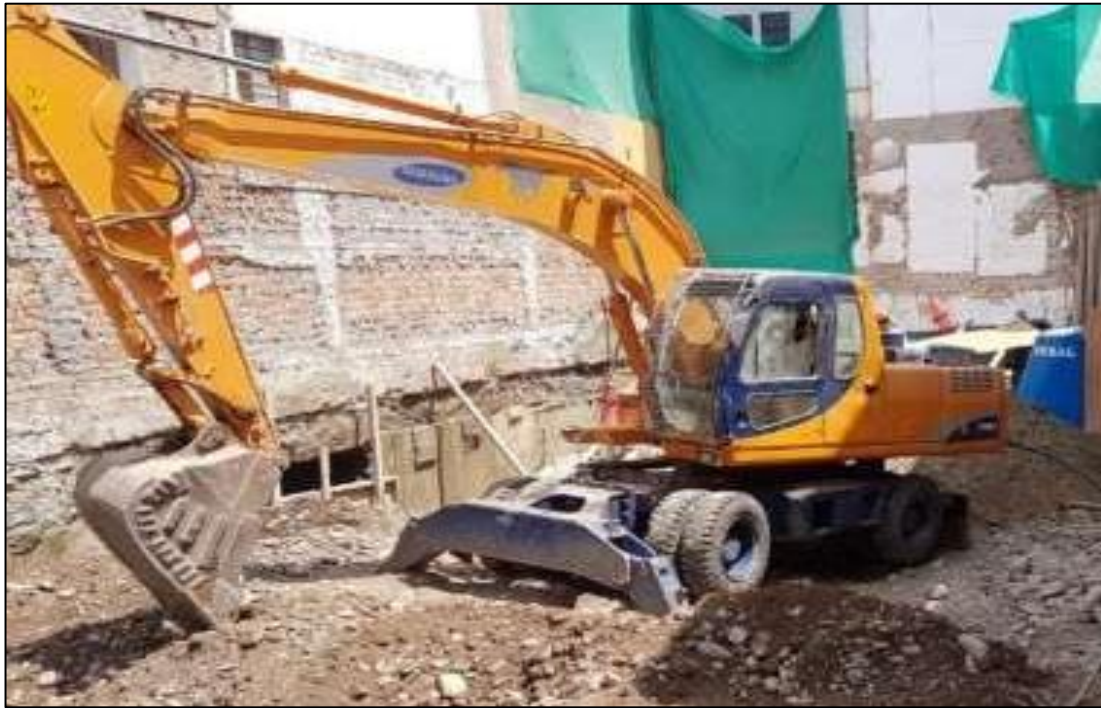
Etapa de excavación masiva
