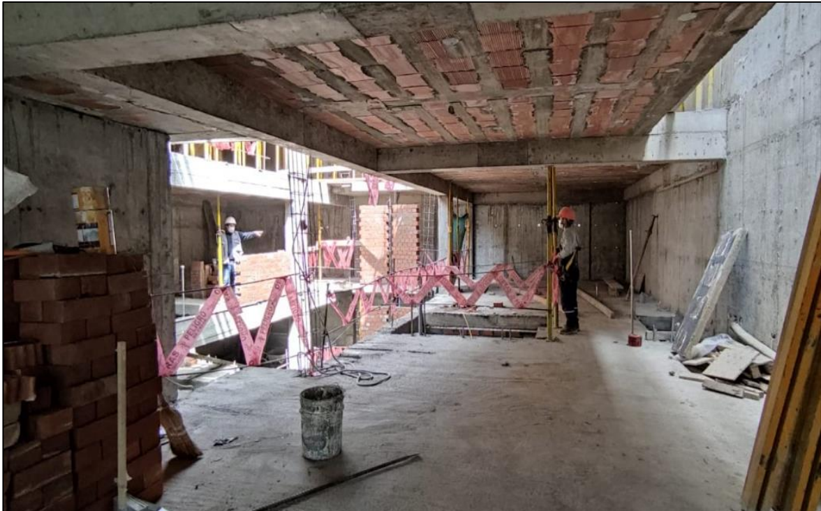
Etapa de desencofrado y construcción de albañilería
