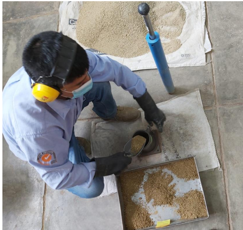
Figura 4.17. Ejecución proctor modificado
