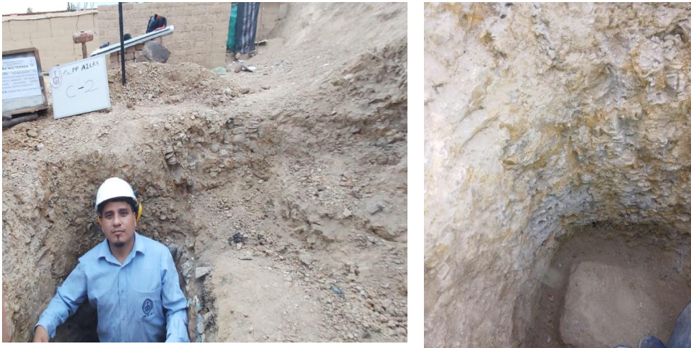
Figura 3.11. C-2 realizada y extracción de muestra de suelo
