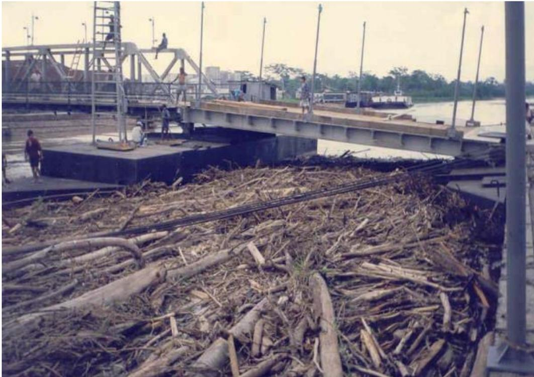
Figura N° 5 Acumulación de palizada en puerto fluvial (Consortio Hidrovia Huallaga, 2005)
