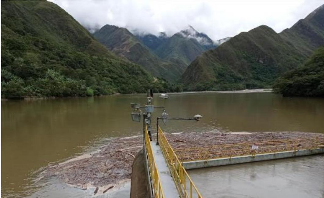
Figura N° 6 Acumulación de palizada en presa Chimay, río Tulumayo (Elaboración propia)
