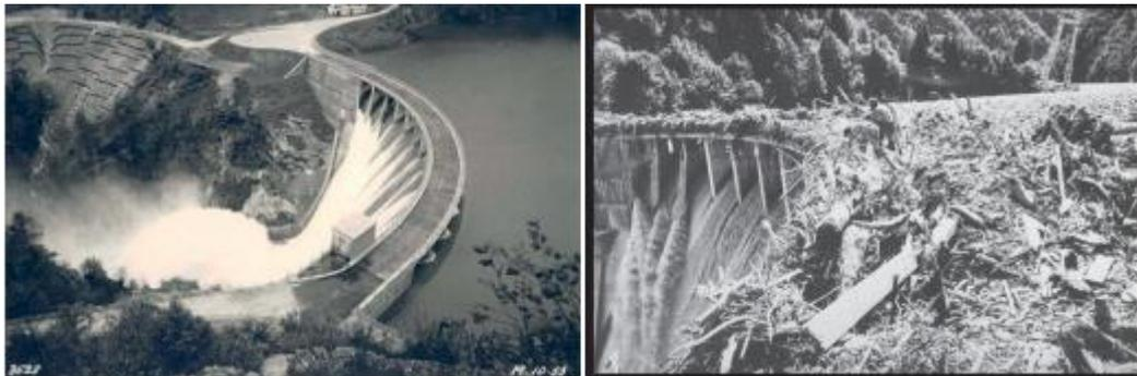
Figura N° 1 Presa Palagnedra, Suiza, antes y después del bloqueo de gran cantidad de leños flotantes (Furlan, 2019)
