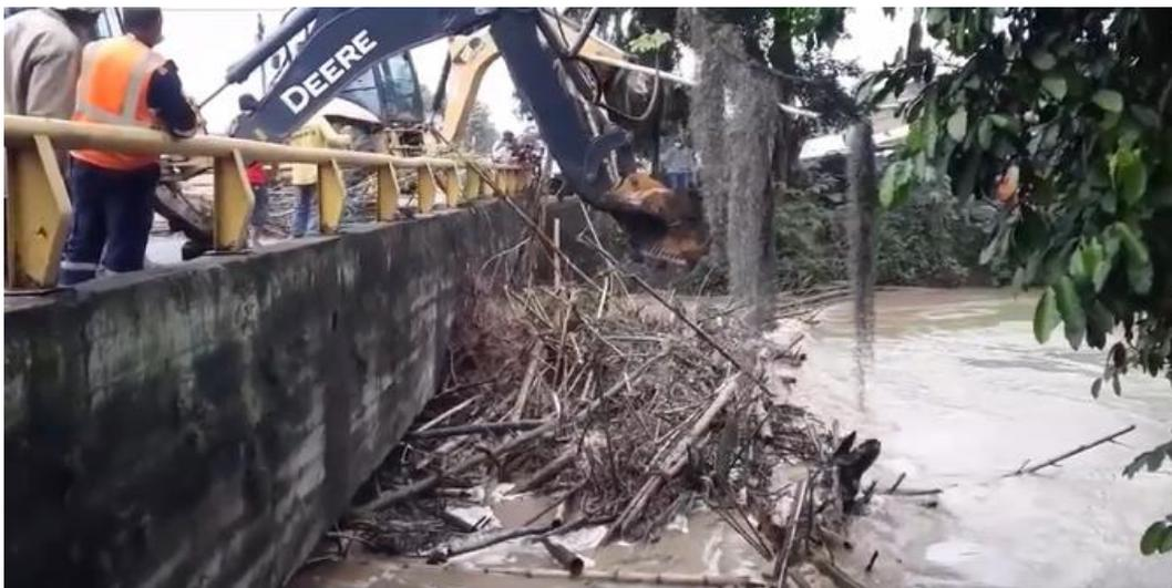
Figura N° 7 Acumulación de palizada en puente del río La Paila, Colombia (Alcaldía Zarzal Valle, 2022)
