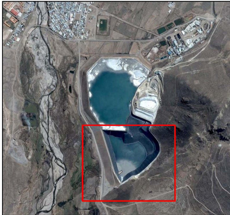
Figura 3.2 Vista en planta de la zona de emplazamiento de la presa de relaves en el año 2013.
