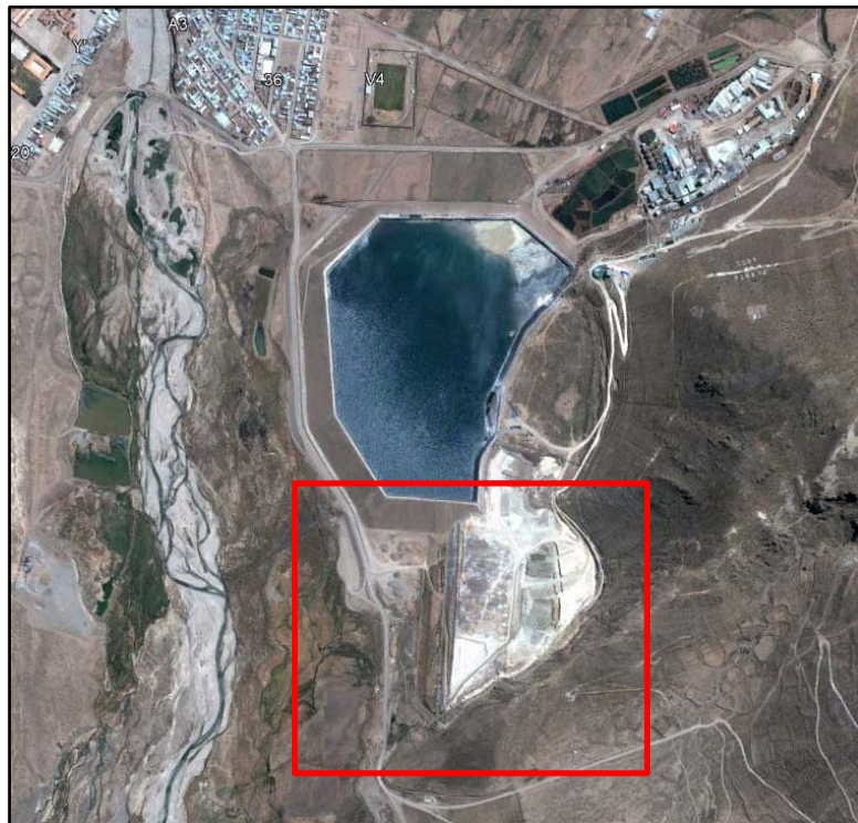
Figura 3.1 Vista en planta de la zona de emplazamiento de la presa de relaves en el año 2010. (antes de la construcción)
