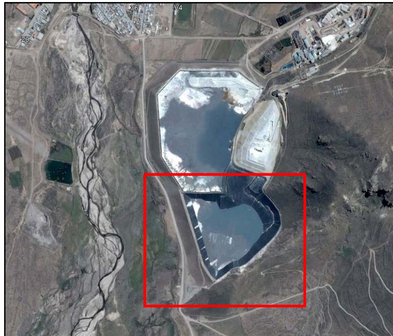
Figura 3.3 Vista en planta de la zona de emplazamiento de la presa de relaves en el año 2016.
