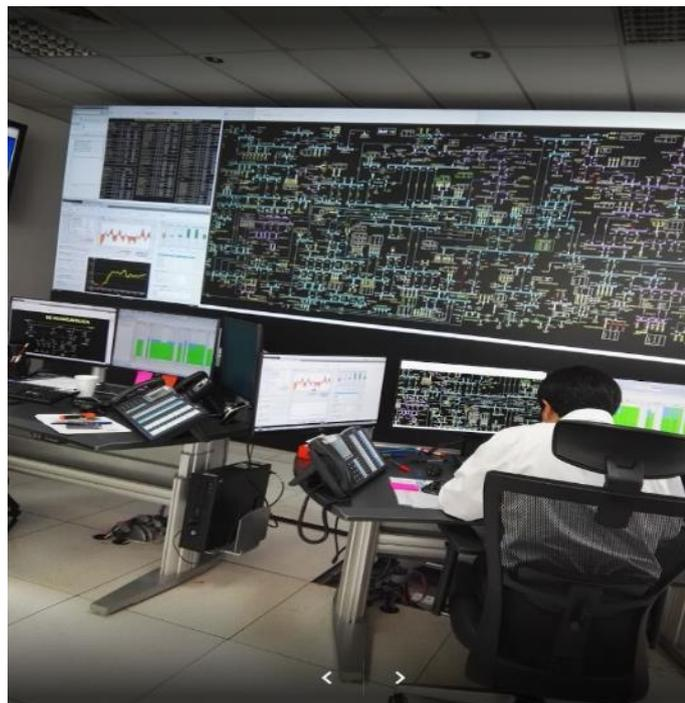
Fig. 2. Centro de Control COES SINAC. Las pantallas muestran el sistema SCADA. [35]
