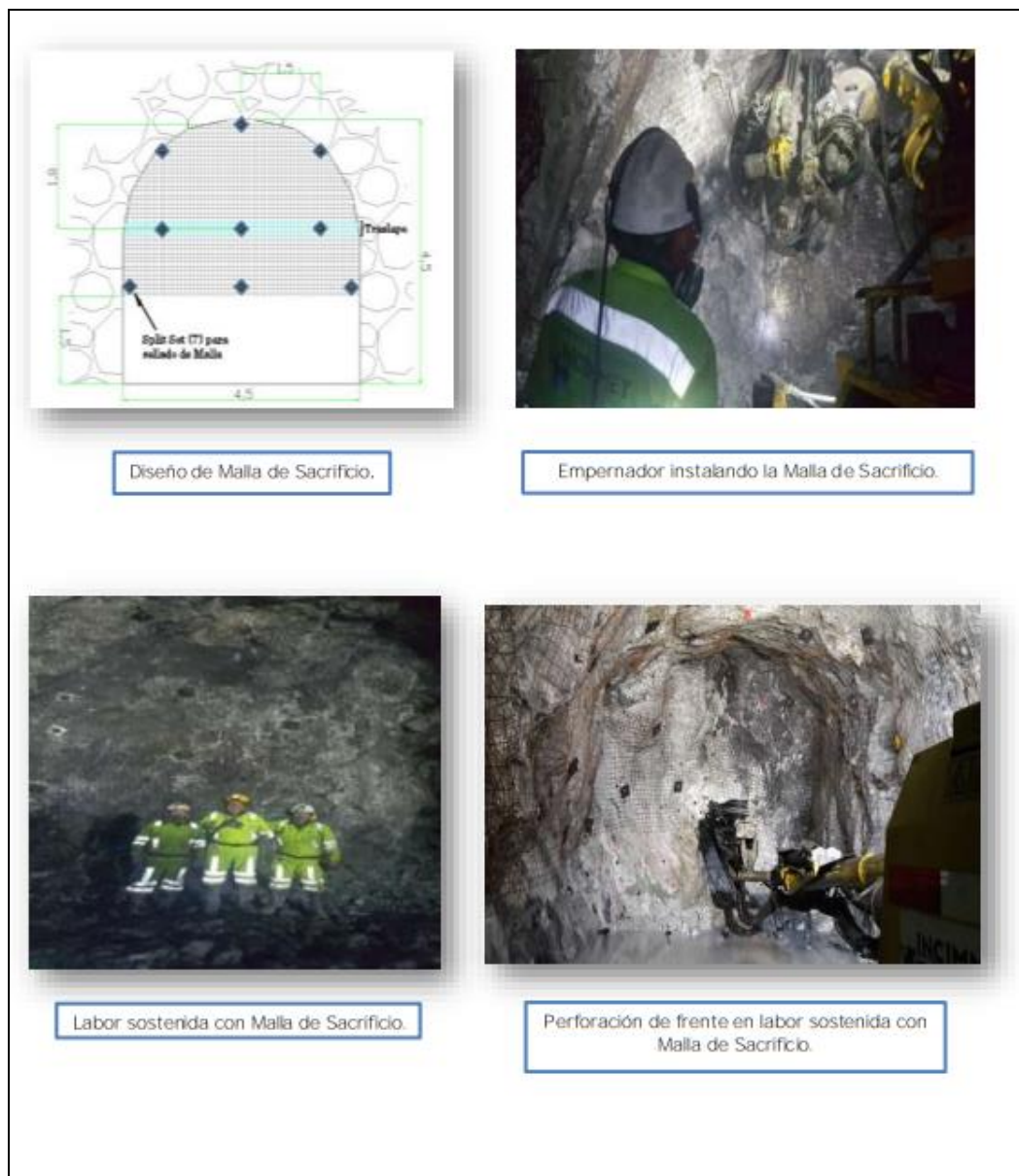
Figura 3.39. Instalación de Mallas de Sacrificio.
