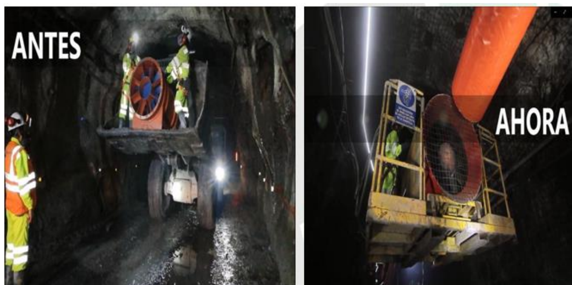
Figura 3.41. Momento de instalación de ventilador auxiliar.
