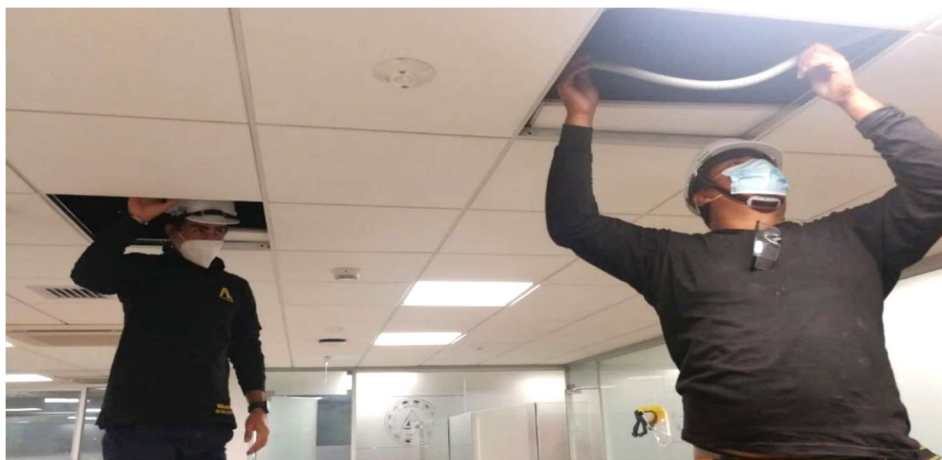
Imagen N° 34 Pase de la tubería corrugada sobre el cielo raso (Fuente: Empresa Giadan Inversiones SAC)
