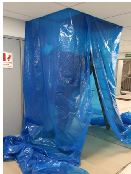
Imagen N° 31 Aislamiento del lugar de trabajo (Fuente: Empresa Giadan Inversiones SAC)
