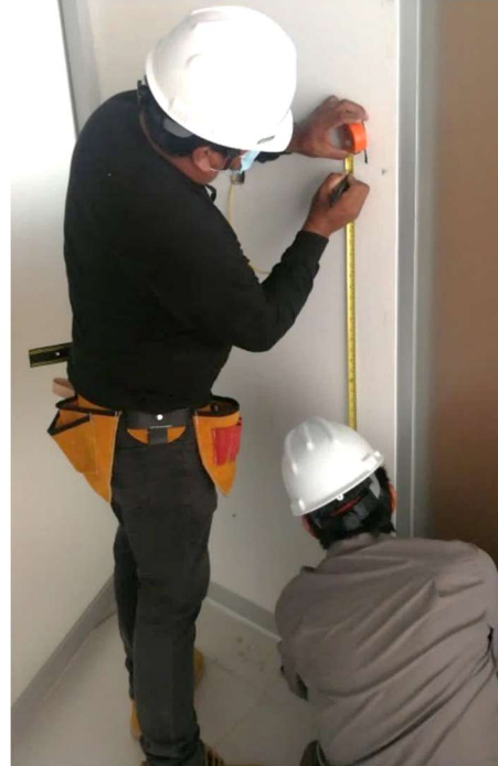
Imagen N° 28 Demarcado de cajas
