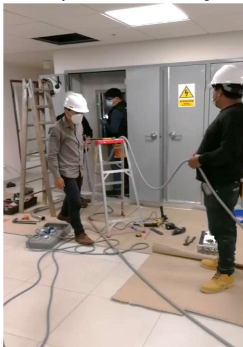
Imagen N° 30 Dimensionando el tubo corrugado (Fuente: Empresa Giadan Inversiones SAC)
