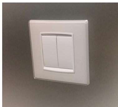
Imagen N° 40 Mando inalámbrico sobre vidrio
