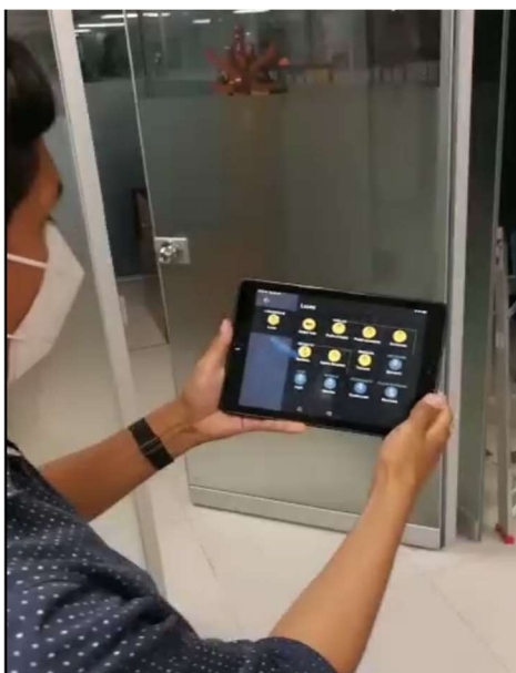
Imagen N° 43 Pruebas de funcionamiento de luminarias ON/OFF
