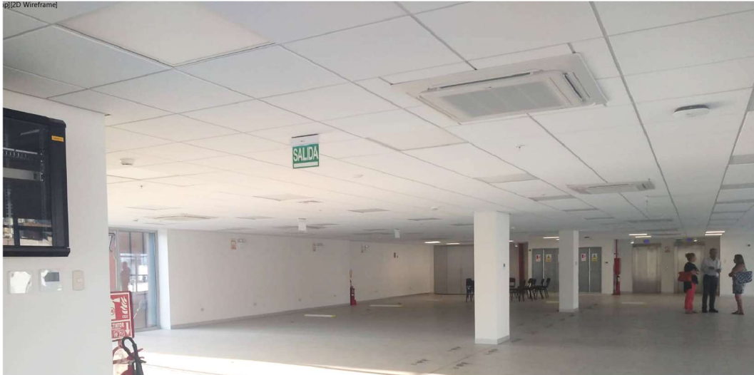
Imagen N° 7 Distribución previa de plafones y evaporadores en techo (Fuente: CIP Lima)
