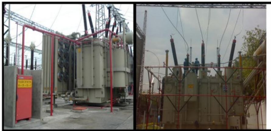
Figura 9 Sistemas SPEI “SERGI” (izquierda) y SCI (derecha)
