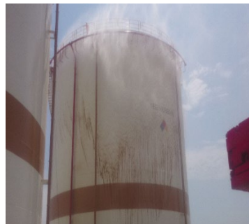
Figura 17 Pruebas de Diluvio en Tks. Combustible
