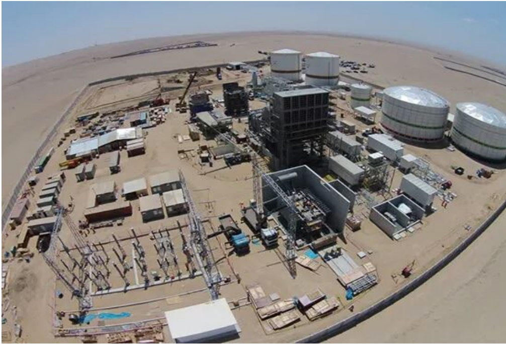
Figura 12 Vista Panorámica de la Planta 200MW
