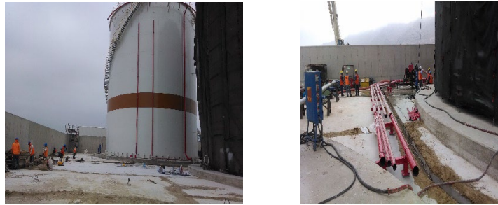
Figura 16 Sistemas de extinción Tks Combustibles
