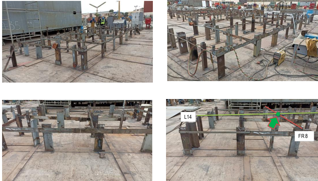
Figura 1. Panel fotográfico de la cama estructural fabricada para el módulo A36.
