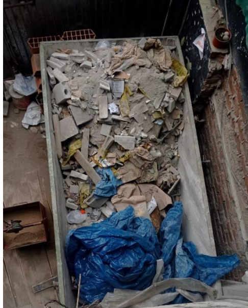
Figura N°4. Residuos sólidos de la construcción de Edificios Multifamiliares
