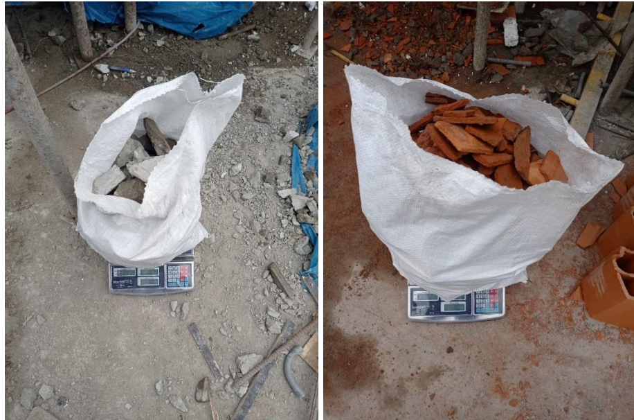
Figura N°24. Pesaje de los sacos con escombros
