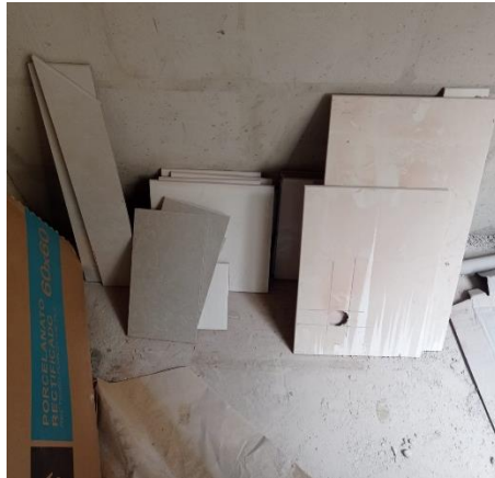
Figura N°39. Segregación de los retazos de piezas de cerámico y porcelanato
