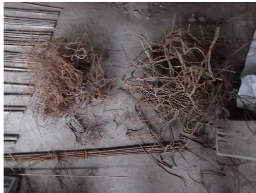
Figura N°20. Residuos agrupados de Alambre #16 y Alambre #8
