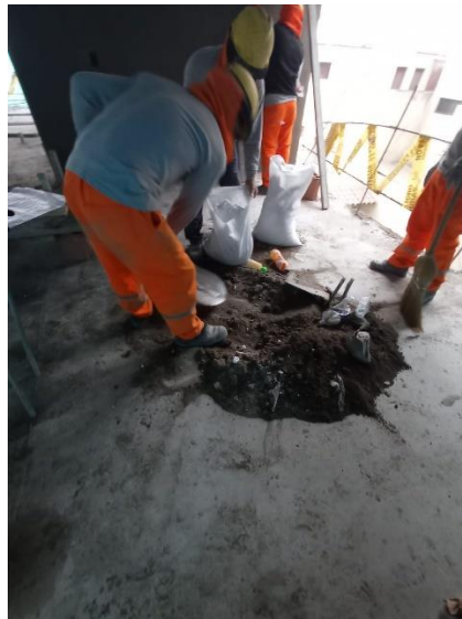
Figura N°26. Colocación de escombros de concreto y residuos de mortero en sacos
