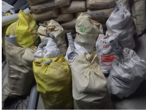
Figura N°37. Retazos de tuberías sanitarias agrupadas según tipo
