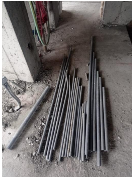
Figura N°29. Retazos de tuberías eléctricas agrupadas según diámetro
