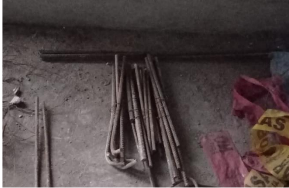
Figura N°13. Retazos de barras de acero juntados y amarrados
