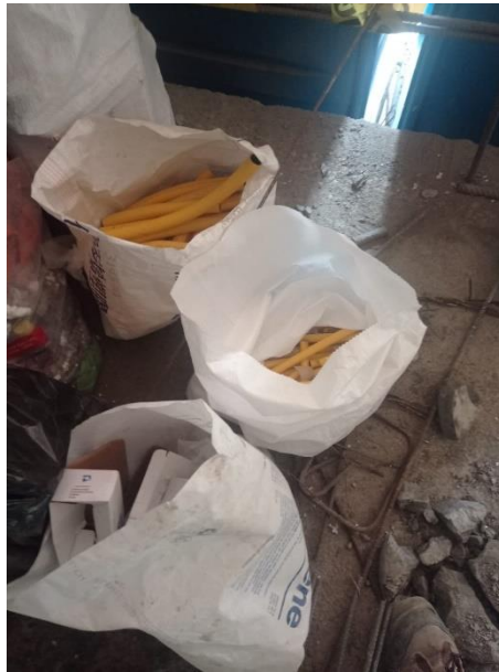
Figura N°31. Retazos de tuberías de gas Pe Al Pe y cajas de cartón en sacos
