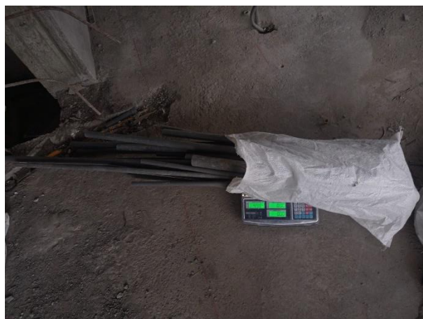
Figura N°30. Pesaje de los sacos con retazos de tuberías eléctricas
