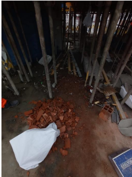
Figura N°23. Segregación de escombros de viguetas pretensadas y bovedillas
