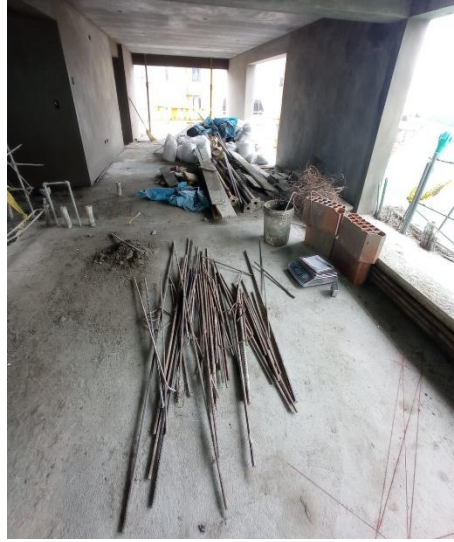
Figura N°9. Punto de acopio de retazos de barras de acero
