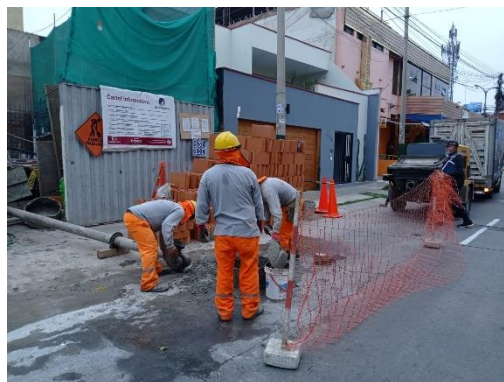
Figura N°25. Residuos de concreto premezclado posterior al vaciado
