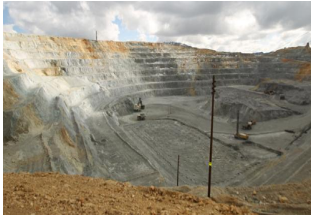
Perforación de taladros en banco
