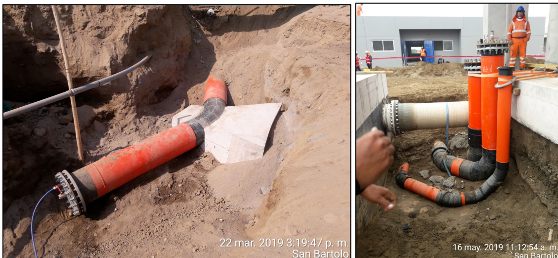
Prueba hidráulica de tubería de impulsión de desagües.
