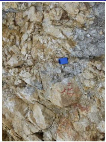
Fotografía de detalle del macizo rocoso
