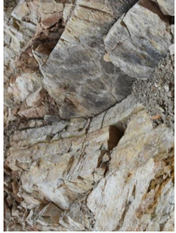
Fotografía de detalle del macizo rocoso
