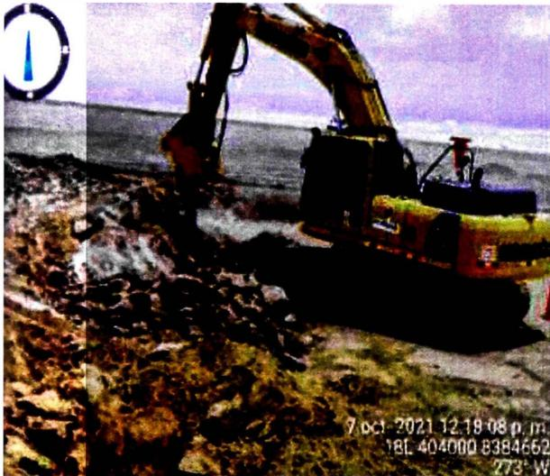
*Excavación de aerogenerador con ripper excéntrico*
