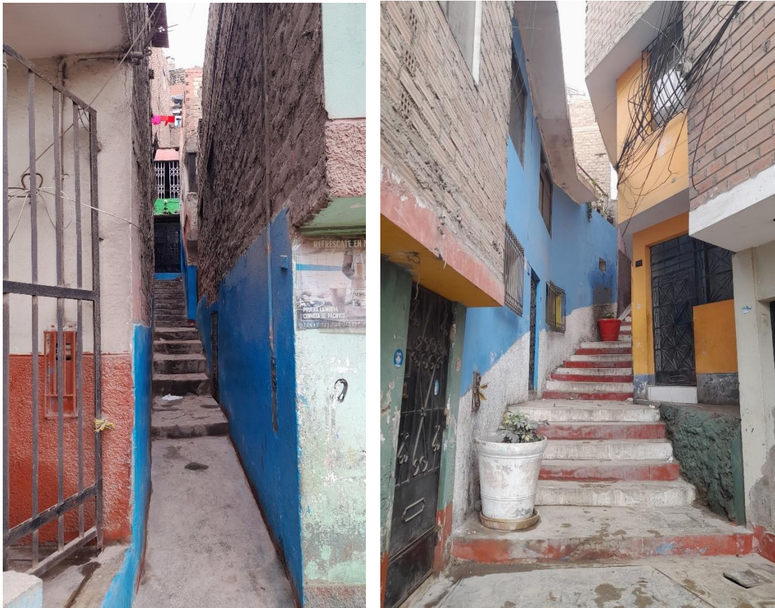
Imágenes 71 y 72. Vista de escaleras internas. Fuente: La autora
