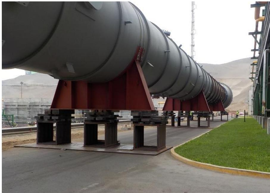
*Nota:* Vistas diferentes del equipo 20C-004 descargado al lado norte de la plataforma de trabajo, aun sin estructuras ni aislamiento térmico.
