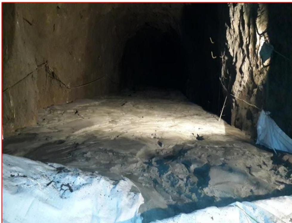
**Anexo 7: Silo de relleno Hidráulico con capacidad de 500 m3**
