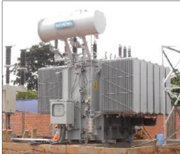
Fig. 11. Transformador de potencia AT/MT
