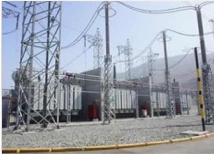
Fig. 9. Subestación eléctrica de transformación 500 kV – 220 kV 750 MVA
