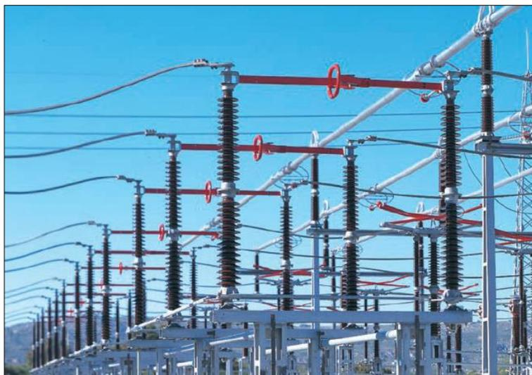
Fig. 19. Seccionadores de alta tensión 220 kV
