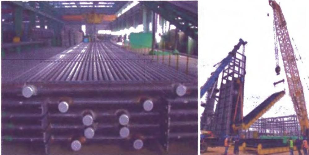
Figura 14. Harps, izquierda: arreglo de tuberías colocados uno sobre otro y derecha: instalación de un harp.
