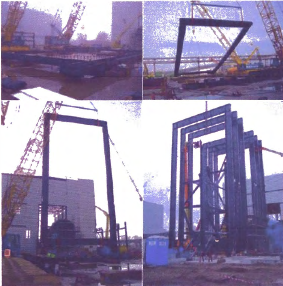
Figura 16. Preensamble en piso, izaje, posicionamiento final y alineamiento de los marcos estructurales.
