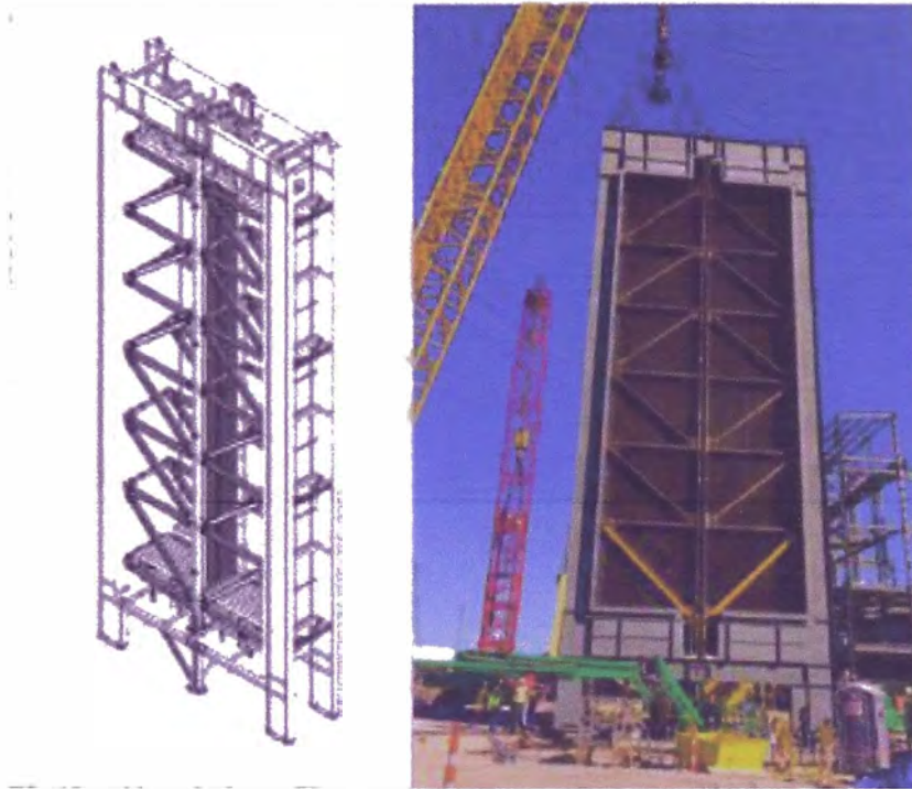
Figura 42. Esquema y posicionamiento final con la grúa del segundo módulo.
