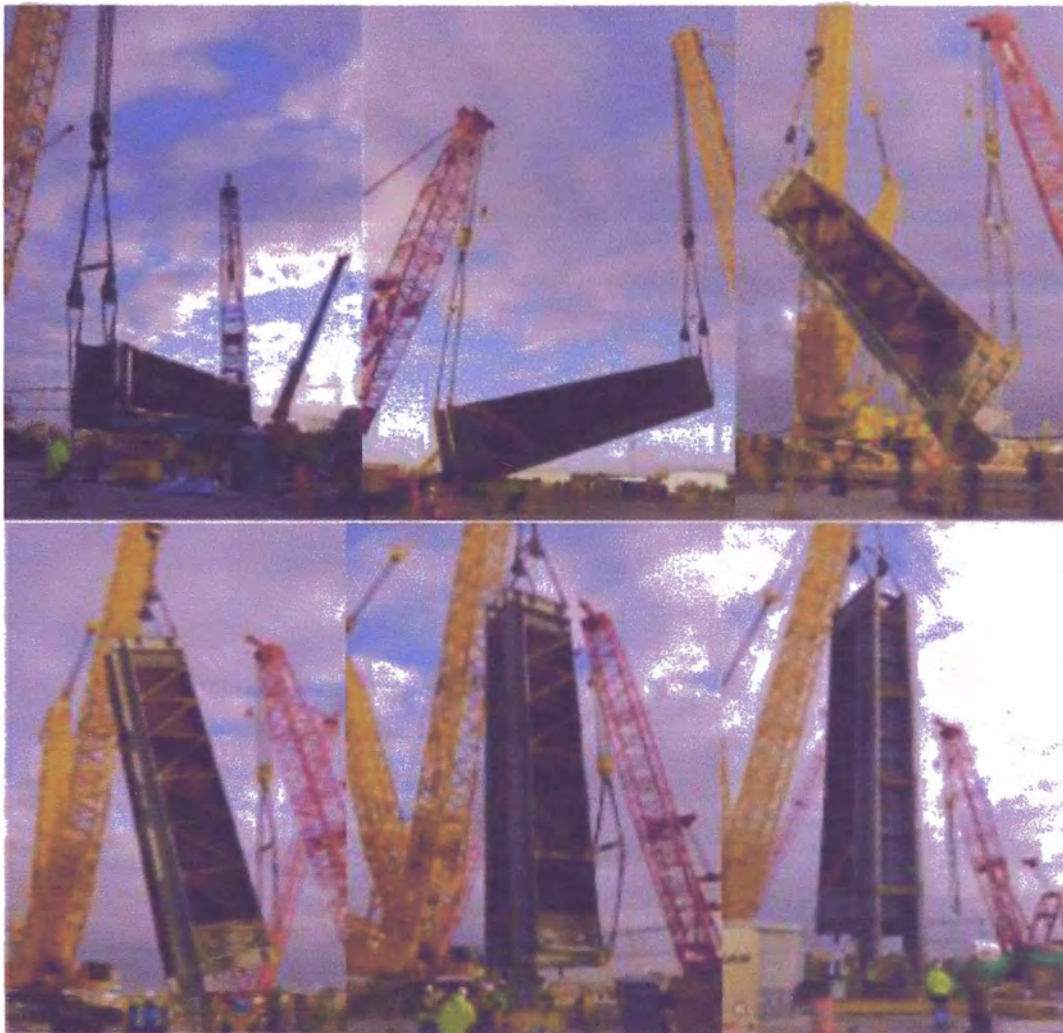
Figura 40. Verticalización y posicionamiento de un módulo
