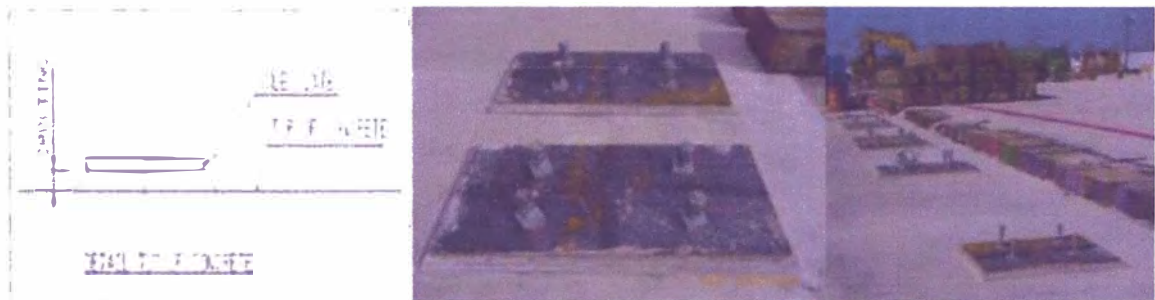
Figura 38. Instalación de las placas base
