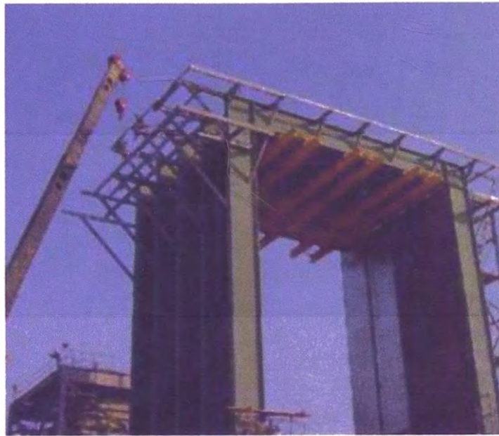
Figura 21. Instalación de las vigas carrileras
