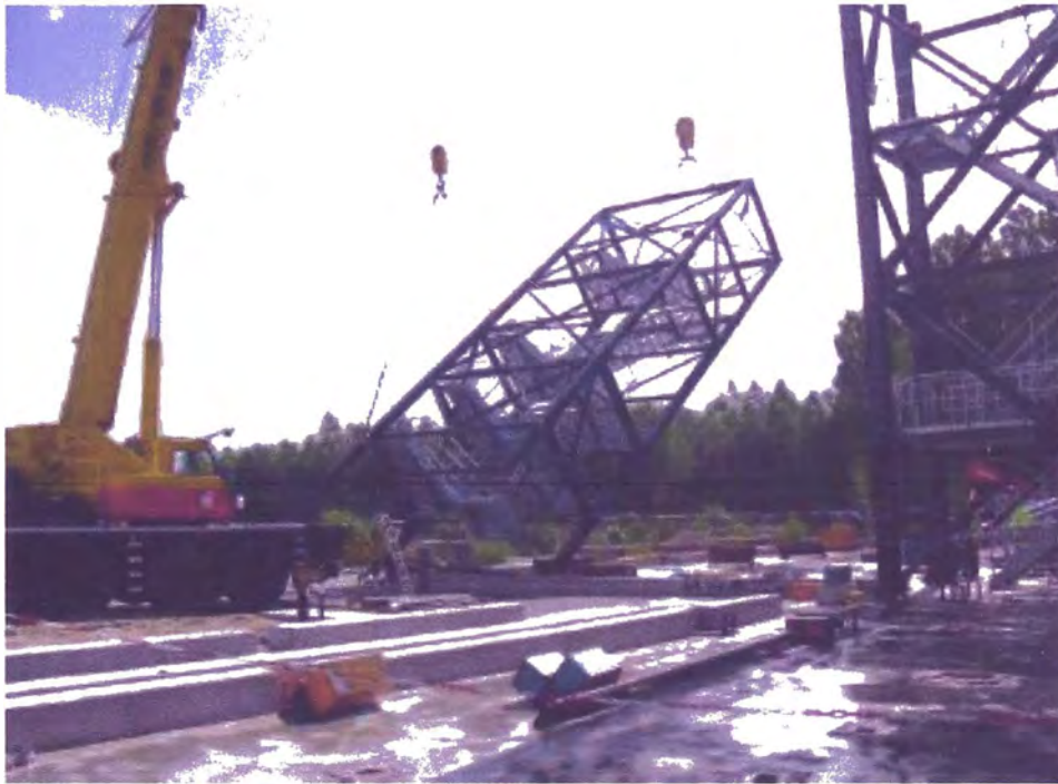
Figura 53. Maniobra de volteo de las escaleras laterales de la caldera
