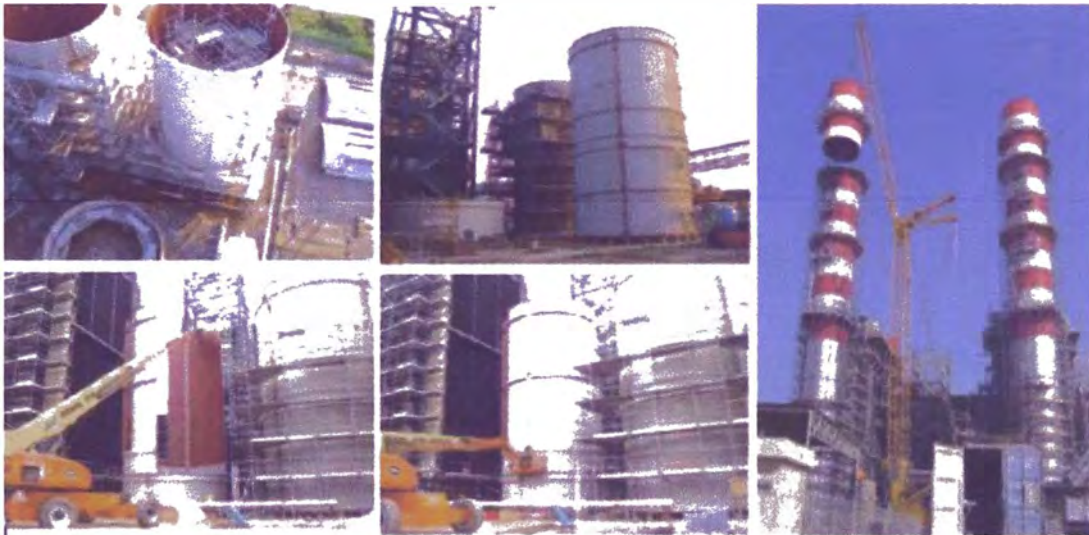
Figura 32. Preensamble de las secciones de la chimenea e izaje de la sección superior con grúa.
