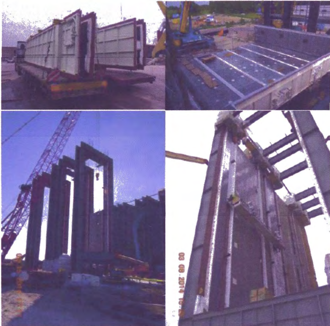
Figura 18. Traslado e instalación de paneles de revestimiento inferior y lateral.
