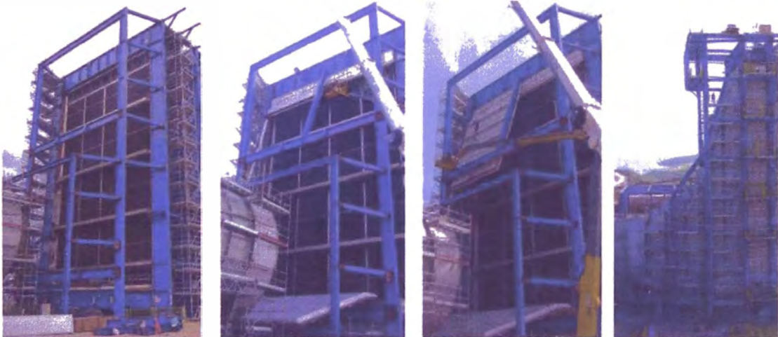
Figura 56. secuencia de instalación de los paneles de revestimiento del ducto de entrada.
