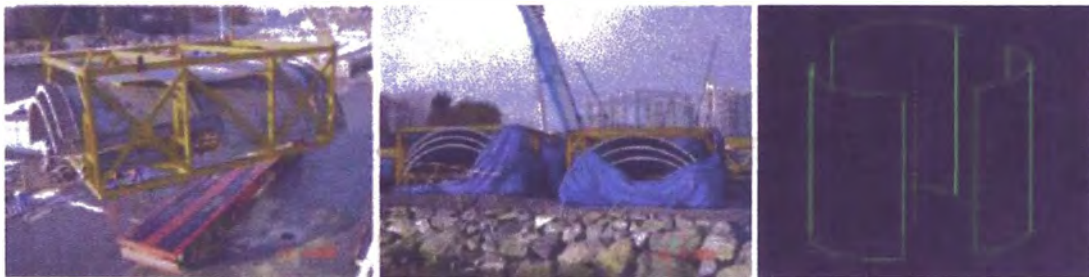
Figura 31. Traslado, almacenamiento y esquema de posición de las planchas roladas de la chimenea.
