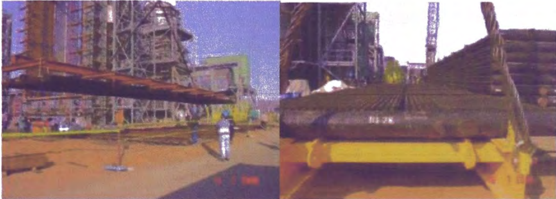
Figura 23. Fijación de un harp sobre el bastidor de elevación
