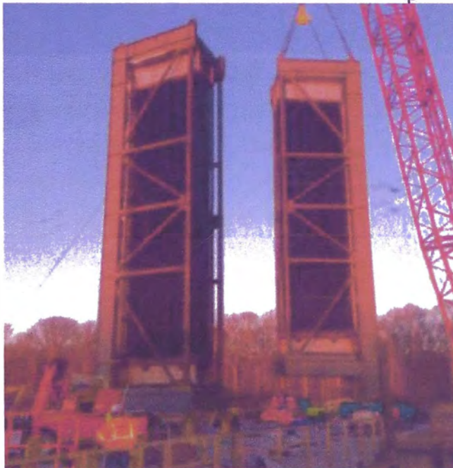
Figura 35. Instalación de dos módulos de una caldera recuperadora de calor
