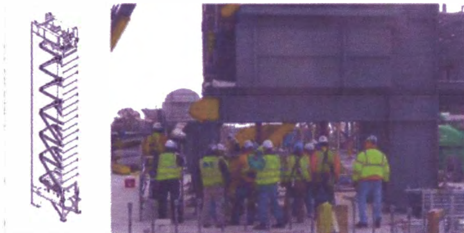
Figura 41. Posicionamiento del primer módulo utilizando estructura temporal.
