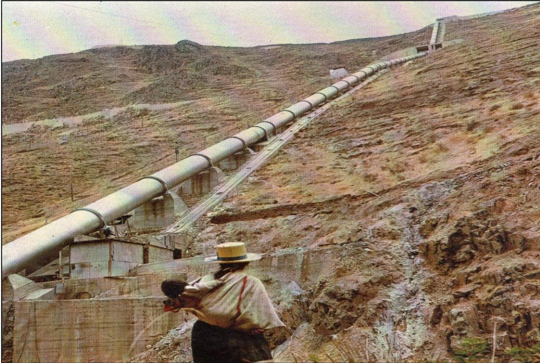
Fig. Nº 5.4 Tubería de presión a la intemperie
