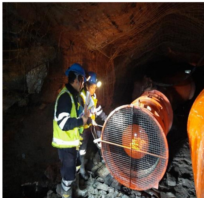
Figura 5: Medición de velocidades en la salida del ventilador Tomocorp de 30 KCFM en el aforo de ingreso de aire-GL 06E en el nivel 4530
