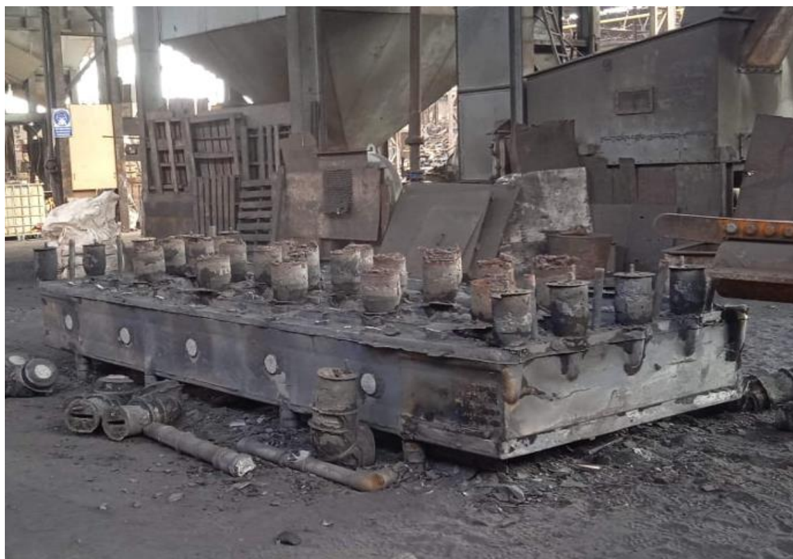
Anexo 9: Rotura de alimentadores y canales
