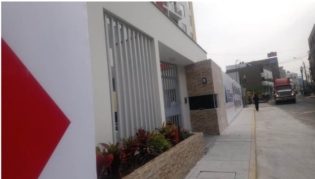
Figura 8: Fachada del Proyecto terminado.
