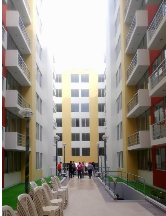
Figura 10: Vista de fachada interior, proyecto finalizado.
