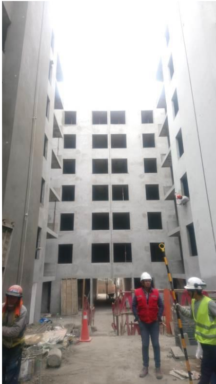
Figura 9: Vista de fachada interior, etapa de casco finalizado.
