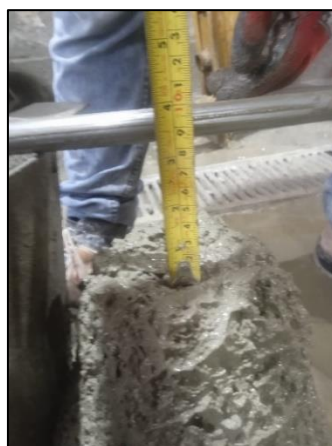
Figura 17 Asentamiento del concreto fresco.
