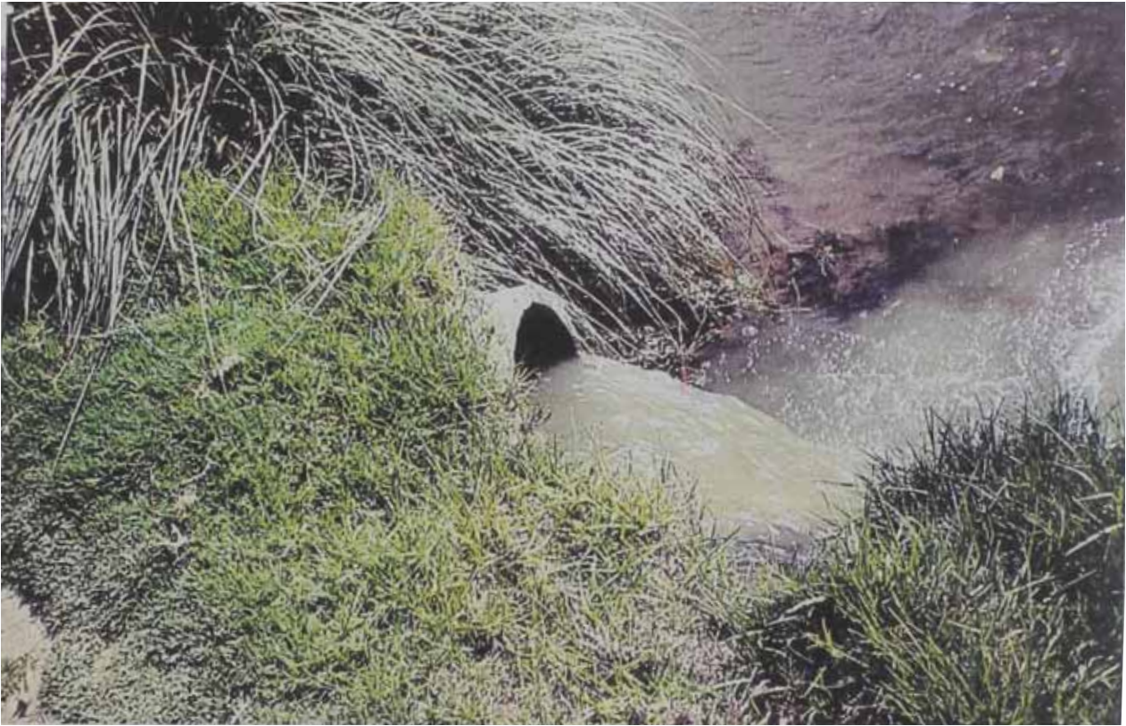
Colector Principal, descargando su aguas al río Tarma.
