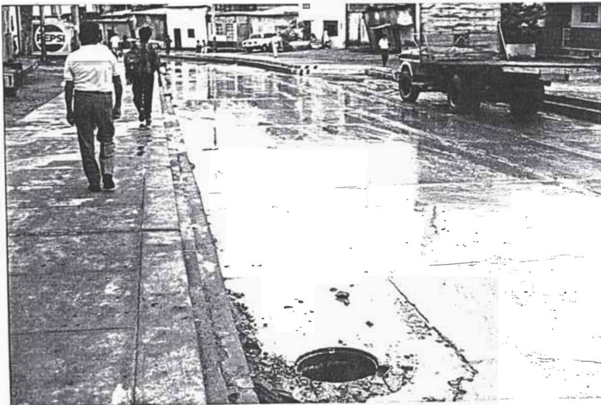
Foto 7.6.- "Jirón Zanjón", notese que los pobladores destapan los buzones para evacuar el agua de lluvia
