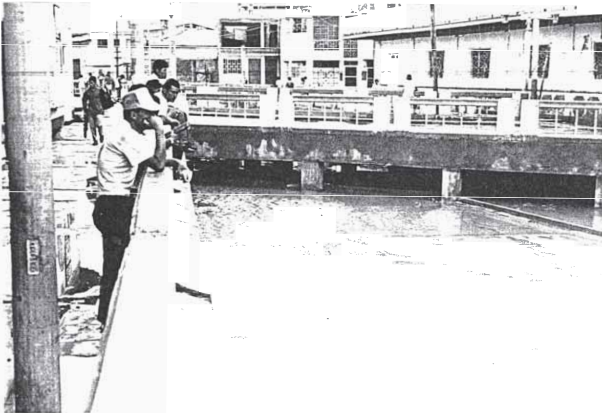
Foto 7.8.- Primer puente en la "Quebrada del Jirón Zanjón"
