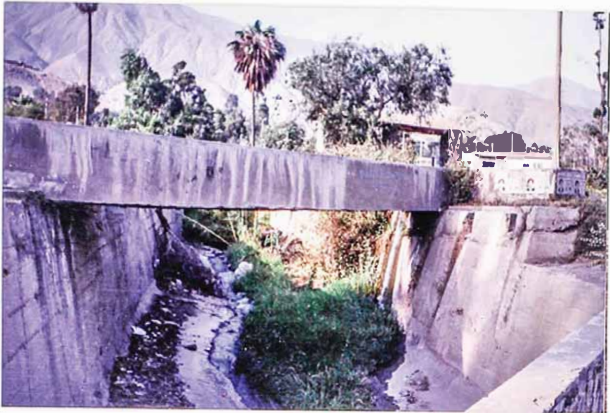
Foto N°20.- Vista del canal de demasías tomada desde la carretera Central en dirección oeste al flujo del agua. El obstáculo que se encuentra en la parte superior del canal, es un sequeño canal de riego, que se encuentra a escasos metros de la carretera, pero representa un obstáculo a salvar, por lo que debe considerarse el diseño de una obra hidráulica para vencer este obstáculo.
