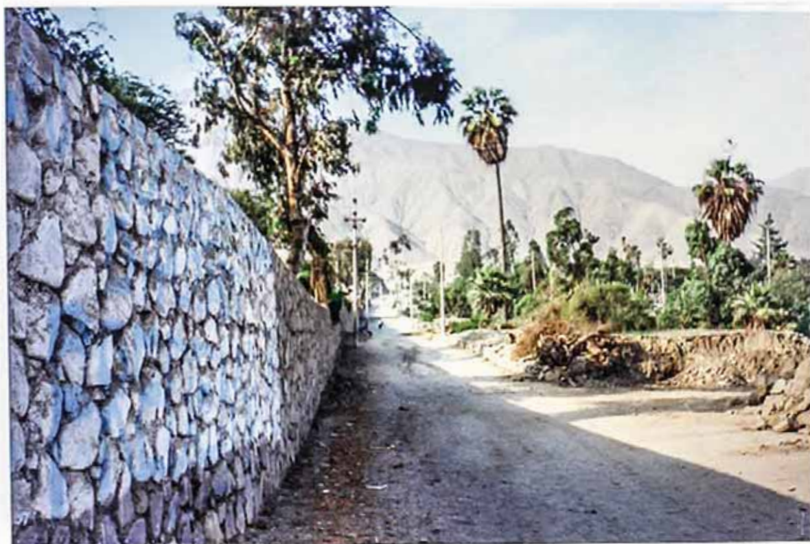
Foto N°19.- Vista del camino de acceso a la comunidad de Yanacoto N°5, tomada al inicio del muestreo. El movimiento de tierras hecha en su inicio, no se había efectuado cuando se realizó el levantamiento topográfico (Esc 90 - Ene 91), actualmente constituye un peligro pues sería una zona de represamiento de efectos no estimados, por lo que debe aprovecharse para iniciar y completar la excavación de la sección compuesta, obra sugerida para el tratamiento del huayco.
