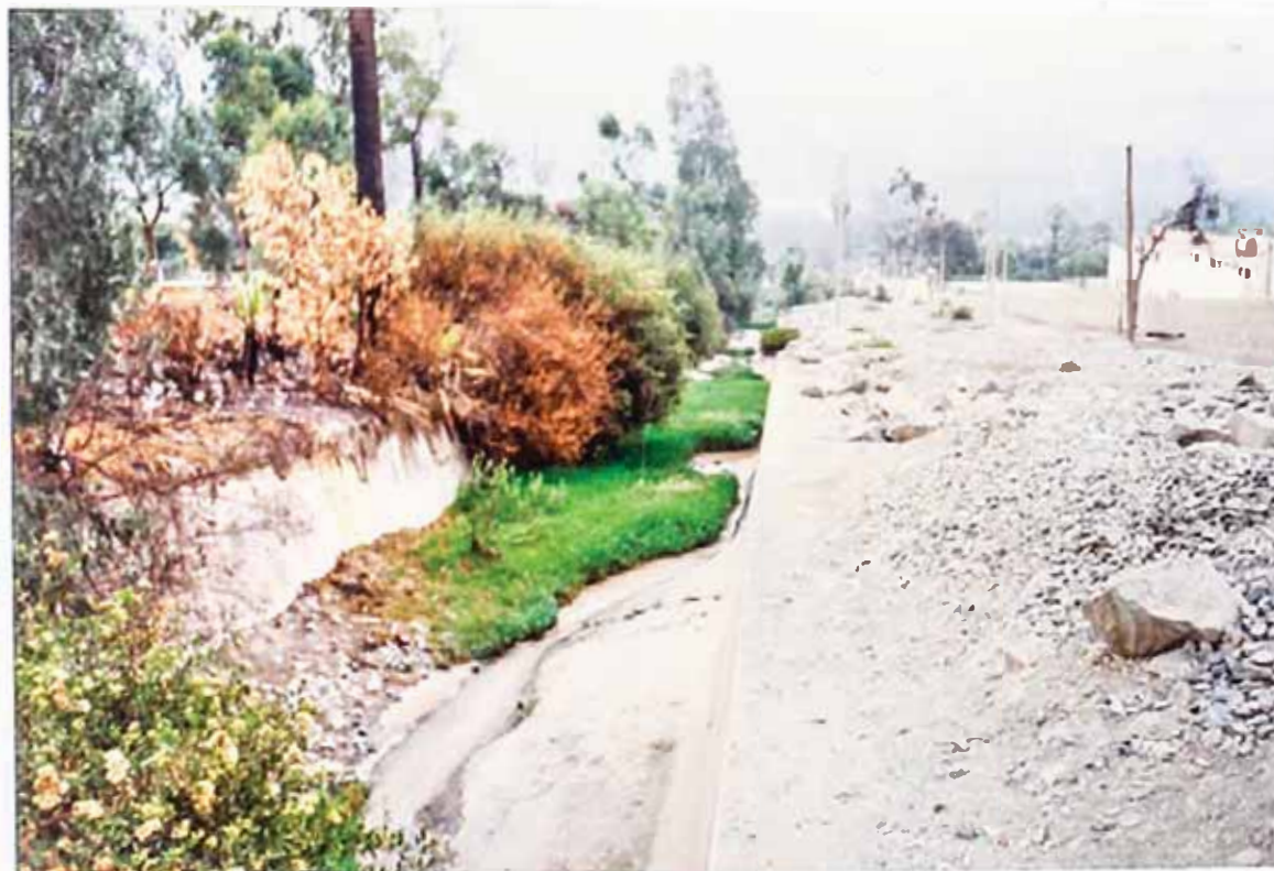
Foto N°16.- Vista del canal de drenajes en el tramo del cauce bajo, tomada en dirección del flujo del agua. A la derecha del canal se observa un depósito natural de tierra y rocas, que pueden ser aprovechados para la construcción del canal de sección compuesta, a la derecha de este depósito está el actual camino de acceso a la comunidad de Yanacoto así como el muro perimetral del Country Club El Bosque.
