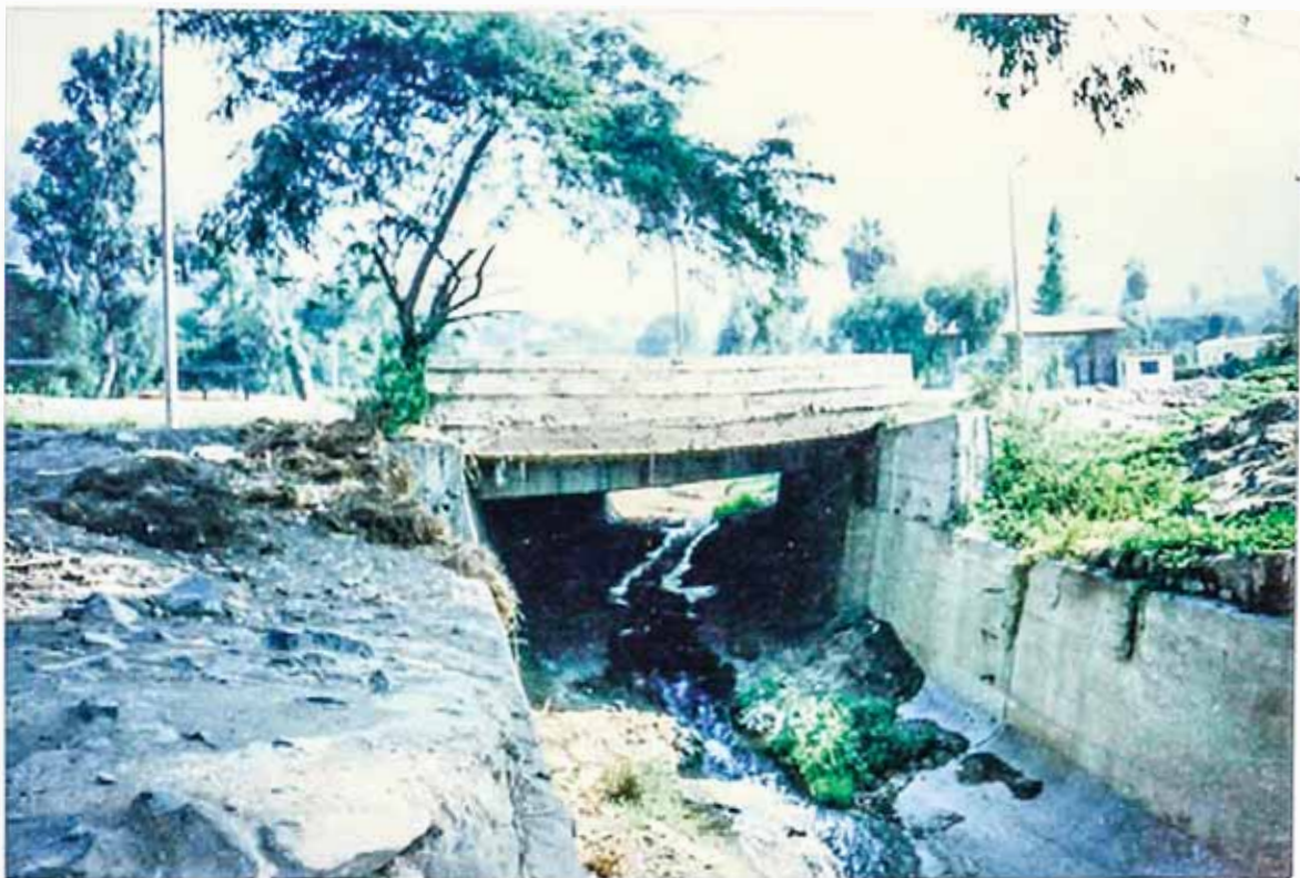
Foto N°21.- Vista del canal de demasías antes de desembocar al río Rimac, claramente se observa que pasa por debajo de la carretera Central, lugar donde presenta un ligero cambio de dirección hacia la izquierda, pero manteniendo sus direcciones. Este conducto, no sería suficiente para el paso de un gran huayco, ni sería posible hacer que todo el canal de sección compuesta pase por debajo de la carretera, debido a las escarpas existentes al pie del río, las cuales llegan hasta los 20 m presentando grietas de tensión, por lo que se recomienda la construcción de un badén o puente antes de llegar a la carretera y antes del canal de riego (foto anterior) para salvar este obstáculo.
