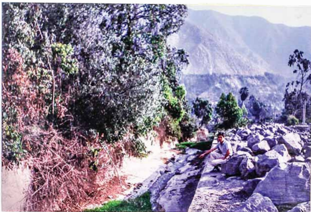
Foto N°18.- Vista del canal de desahues, dentro del cauce bajo, en dirección del flujo del agua. A la derecha se sigue presentando el depósito natural de tierra y rocas, que serán los materiales de construcción del canal de sección compuesta. El canal de desahues se encuentra erosionado debido al paso del agua por su parte central.
