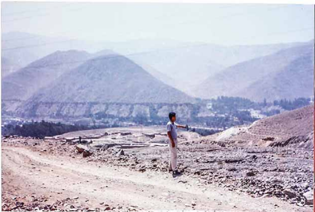
Foto N°3.- Vista del tramo final del cauce alto, tomado desde la parte alta de la margen izquierda (camino de acceso a las torres de alta tensión). Al centro a la derecha se observa la terraza que dejó el huayco más grande y antiguo que ha bajado por la quebrada.
