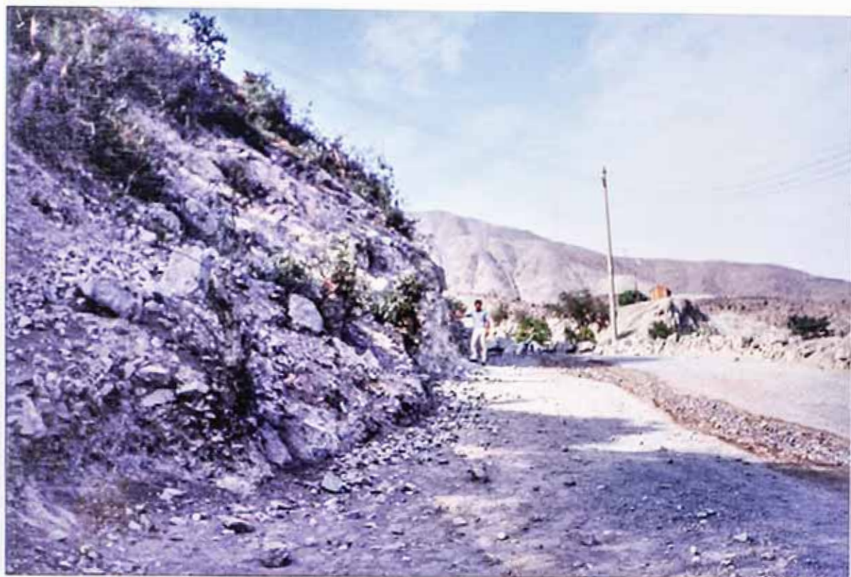
Foto N°15.- Vista de la saliente del cerro al inicio del cauce bajo, la cual junto con el muro de piedras de Electrolima disminuyen la sección de paso, esta es la parte que debe ser eliminada empleando la voladura y el picapedree.
