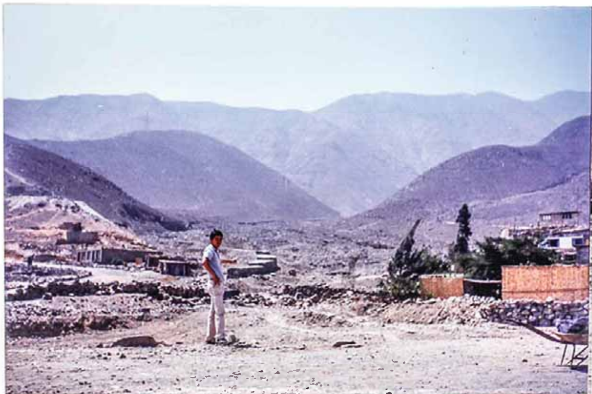
Foto N°4.- Vista panorámica del cauce medio y alto, las viviendas cercanas al cauce medio están expuestas al peligro ante el paso de un gran huayco, al centro puede observarse el muro de rocas (pirca) construido por el PAIF, con la intención de desviar al huayco, pero está construido sin una buena cimentación, lo que lo hace presa fácil de la erosión. Esta zona es el inicio de las obras hidráulicas de encauzamiento.
