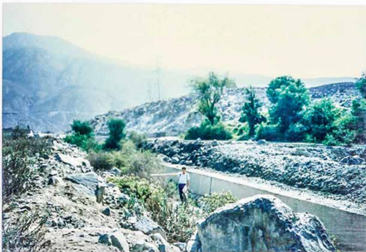
Foto N°11.- Vista del trazo final del cauce medio, tomada en sentido opuesto al flujo del agua. Se observa que se presenta un depósito de tierra y roca suelta en la margen derecha del canal, lugar donde debe construirse el otro canal, utilizando los recursos naturales como material de construcción.
