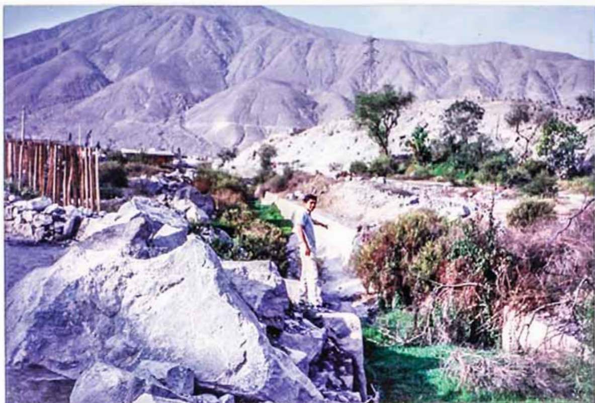
Foto N°13.- Vista del canal de demasías, tomada entre la saliente del cerro y el muro de piedras de Electrolima, en sentido opuesto al flujo del agua. Las rocas que se observan así como el material que resulte del corte del cerro, pueden utilizarse para la construcción del canal de sección compuesta, después de haber sido adecuadamente trabajadas.
