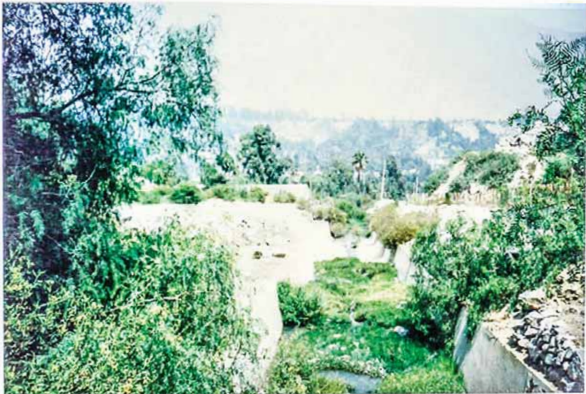
Foto N°10.- Vista panorámica del canal de desahío, en el tramo final del cauce medio, tomada en sentido opuesto al flujo del agua. En su margen derecha debe construirse el otro canal. Se observa la abundante vegetación dentro de canal, más adelante se encuentra el muro de piedras de electrociza (izquierda) y la saliente del cerro (derecha).
