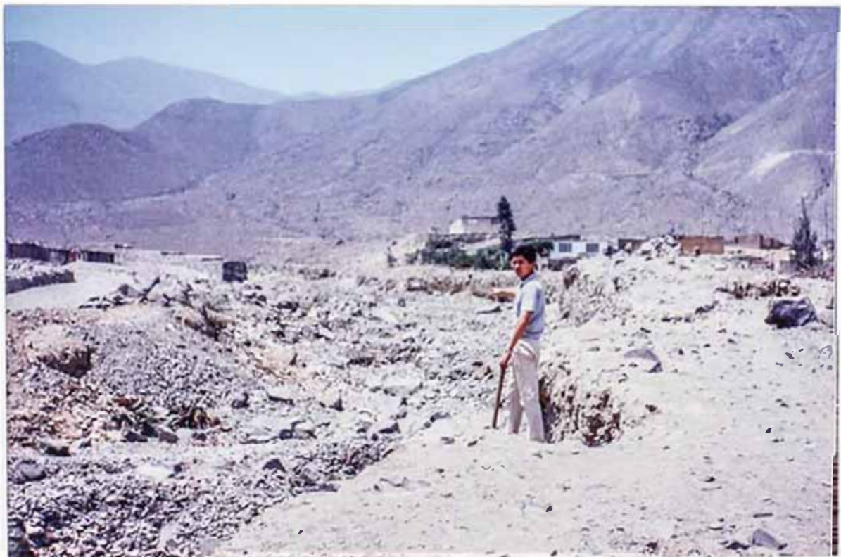
Foto N°6.- Vista del cauce medio, tomada en sentido opuesto al descenso del huayco, en la margen izquierda existen escarpas de 2 a 3 m. de altura, las cuales tienen que ser protegidas por muros de piedra unidas con mortero cemento-arena o muros de concreto armado de alta resistencia. La zona es ideal para el inicio de la rápida, que tendrá una presa vertedero como reguladora del caudal.
