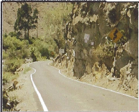
FOTO N° 1: GEOMETRÍA DE LA VÍA, falta de visibilidad en la curva.
