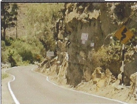
FOTO N° 3: GEOMETRÍA DE LA VÍA, falta de visibilidad en la curva.
