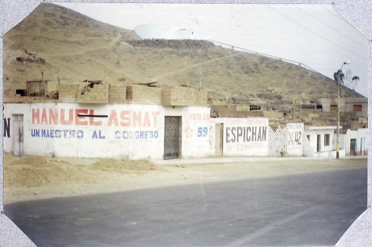
FOTO N° 26 RESERVOIRIO SAN ANTONIO (360 m 3 )
