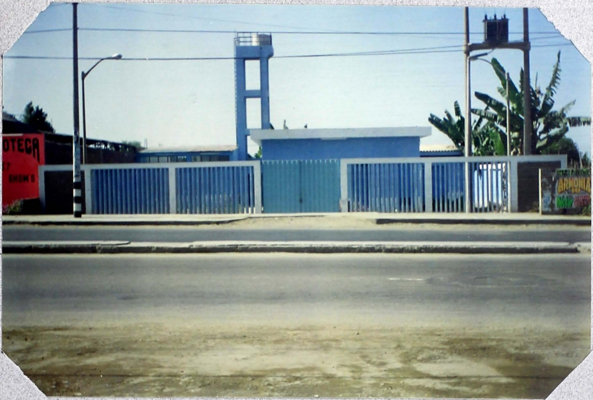
FOTO N°1 ESTACIÓN DE BOMBEO N°1
