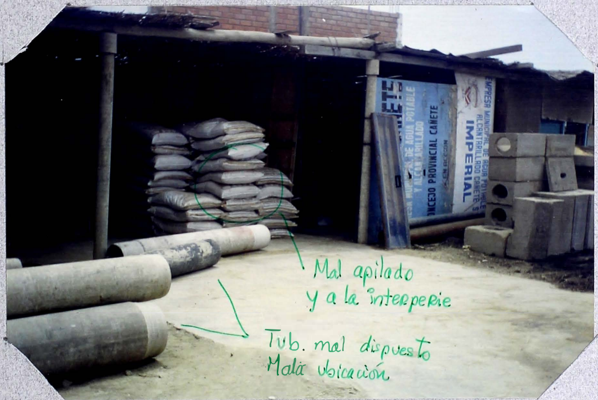
FOTO Nº 6 ALMACEN - E.B. Nº 2
