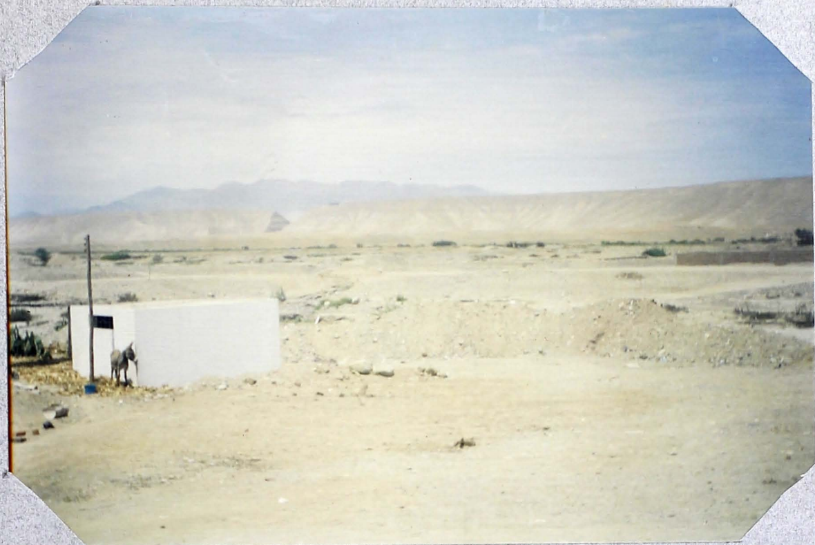
FOTO Nº 18 ESTACIÓN DE BOMBEO DE DESAGUE MUY CERCA A CAUCE DEL RÍO GRANDE (ASIA-OMAS)
