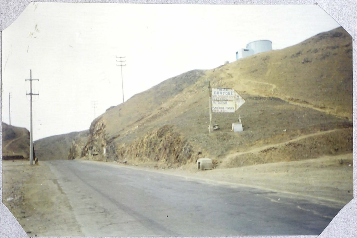
FOTO N° 25 RESERVOIRIO VILLA PARAISO (80 m 3 )
