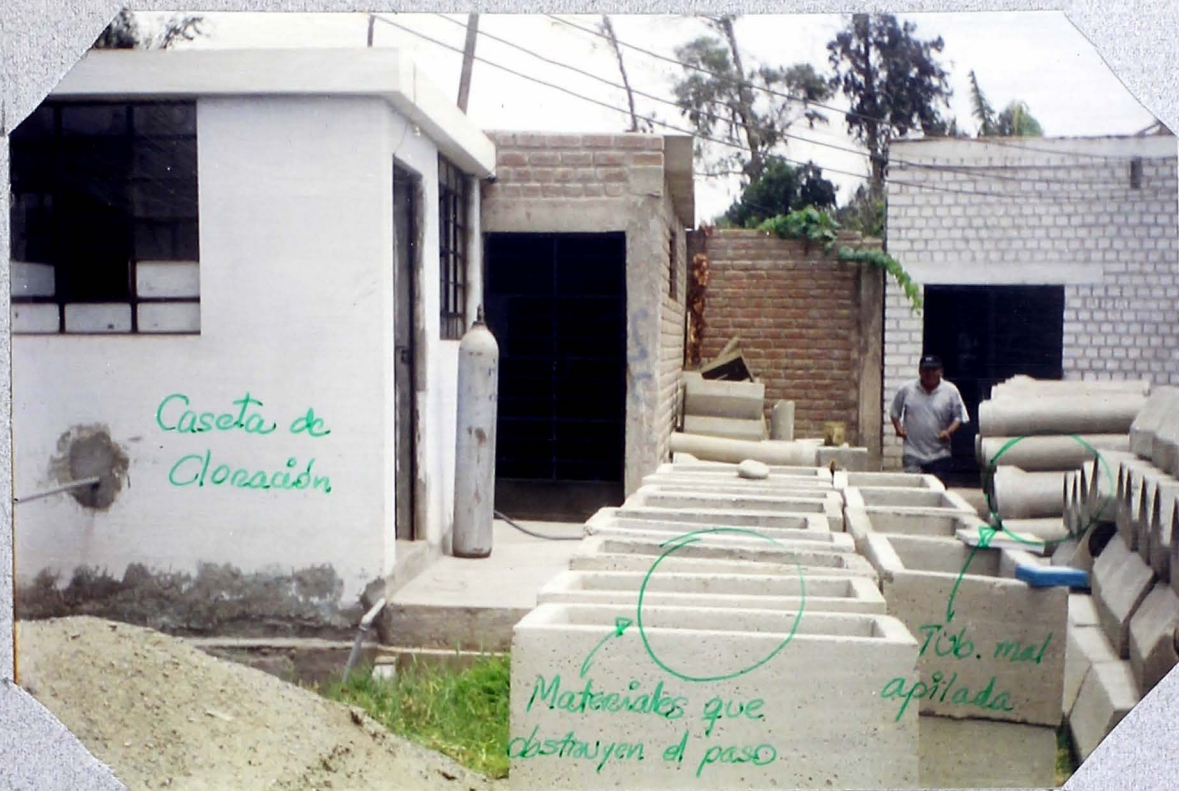
FOTO N° 23 ESTACION DE BOMBEO TRAMPA MORTAL
