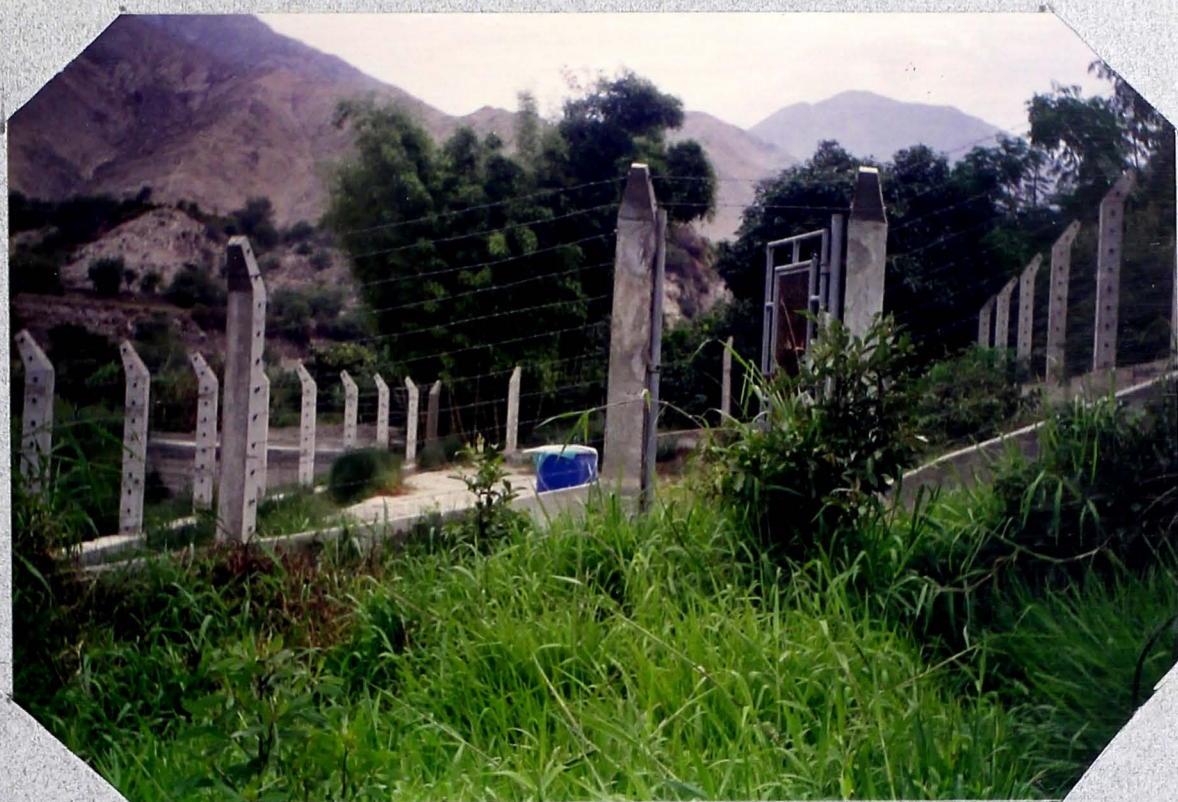
FOTO N o 7 CAPTACION - GALERIA FILTRANTE
