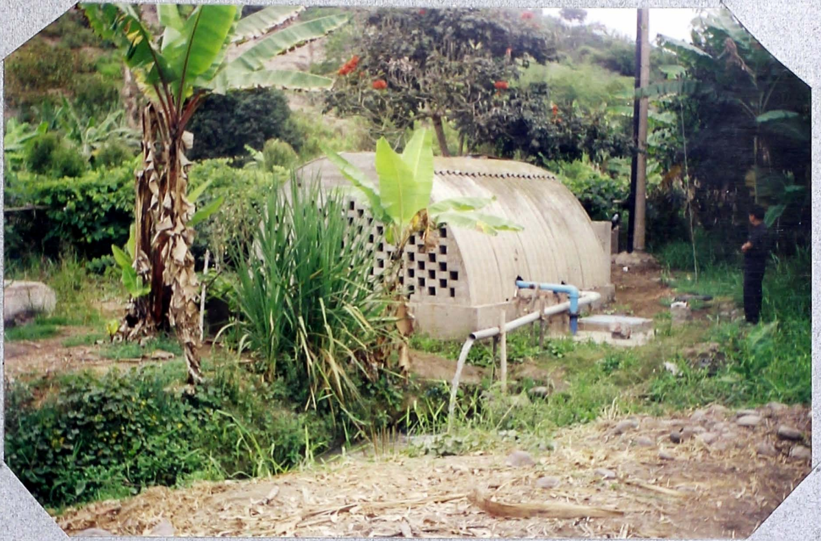
FOTO N° 27 ESTACION DE BOMBEO CON VÍA DESCRIBIBLE ACCESO.
